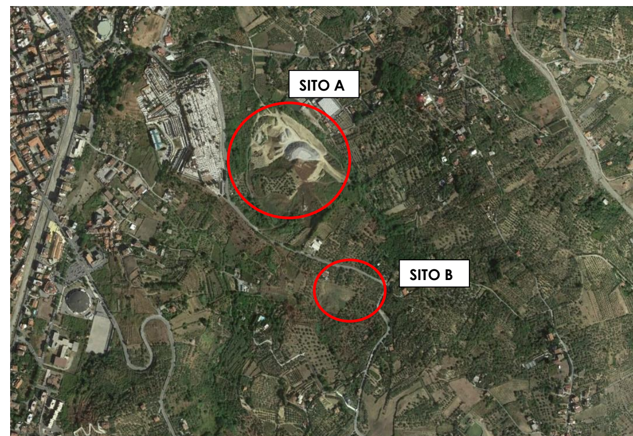
Vista aerea dell'area in cui si inseriscono i siti di conferimento (da Google Earth, aggiornamento 2018 ).
