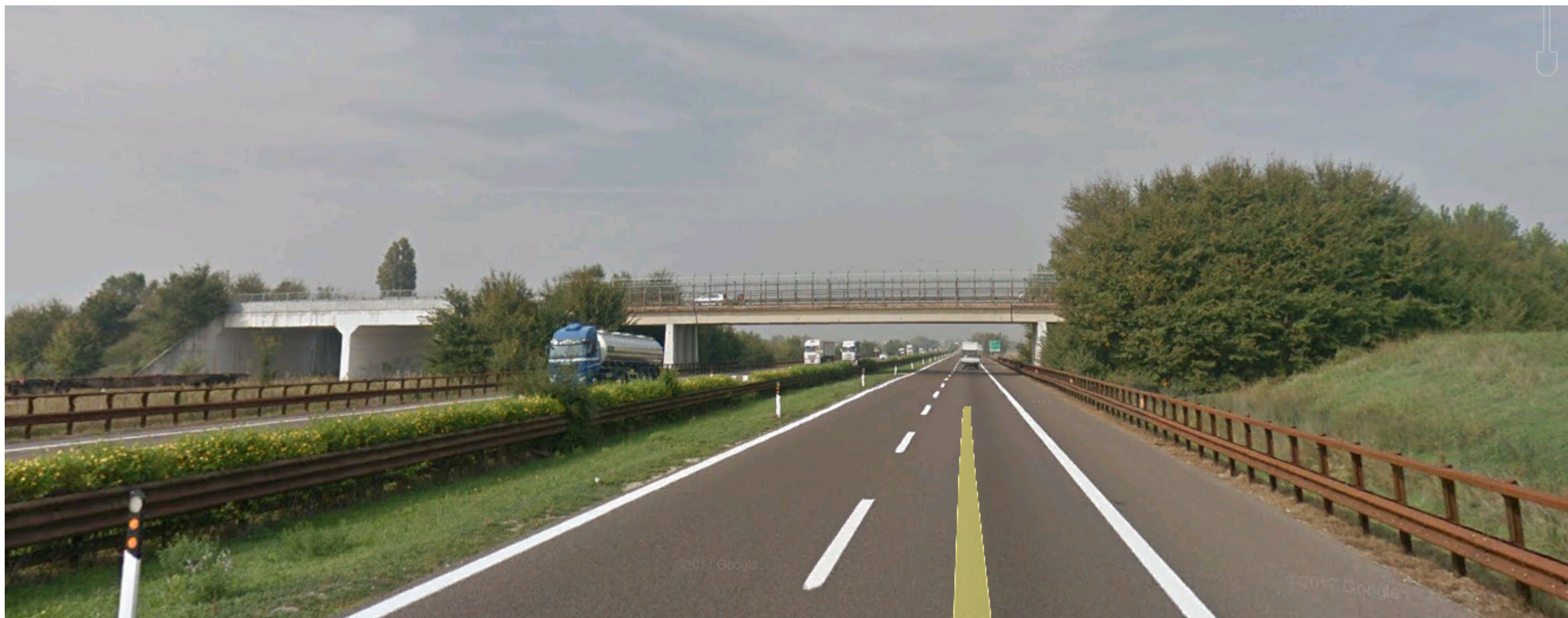
TAVOLA 4 - Veduta del sovrappasso n°108 vista da sud (© 2018 Google Streetview)
