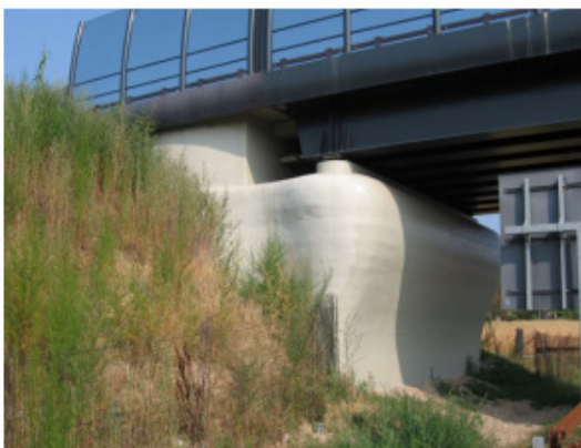
TAVOLA 14 - Tipologia del nuovo sovrappasso n. 108 in affiancamento al sovrappasso ferroviario da Tav. 7.7.4.0 di progetto - prospetto e foto opera simile
