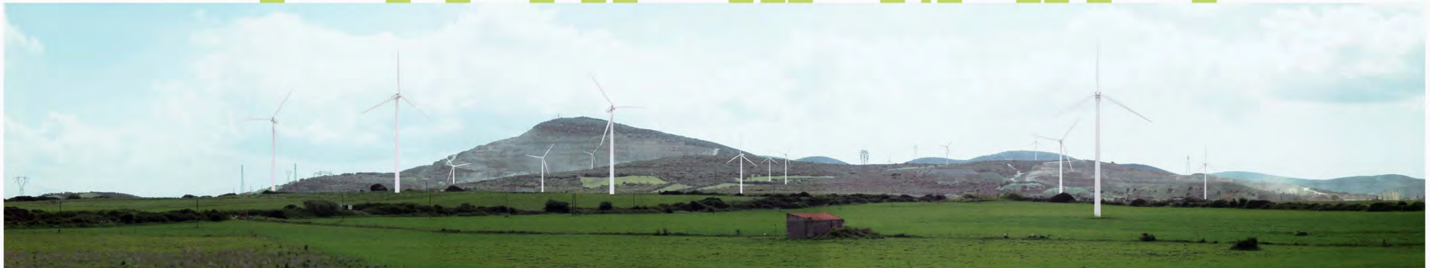
FOTO INSERIMENTO > N.4 dalla nuova Strada Provinciale n. 57
