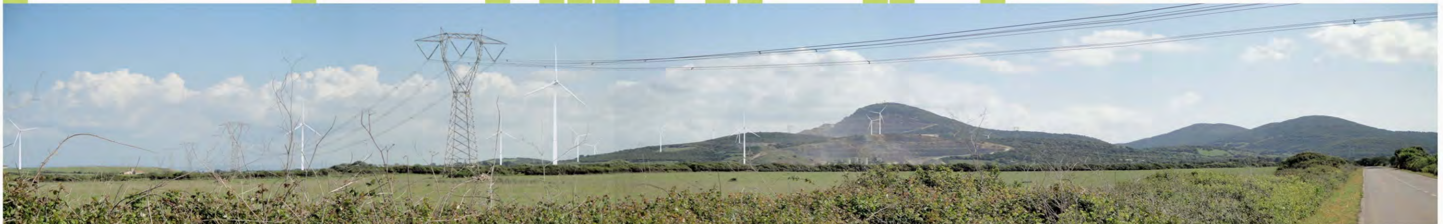
FOTO INSERIMENTO > N.3 dalla vecchia Strada Provinciale n. 57 Porto Torres-Palmadula
