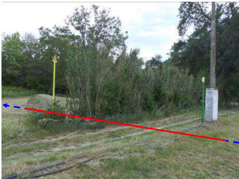
Foto n.2 – Variante per sostituzione giunto a flangia DN 400 (16") in attraversamento strada comunale Fontanelle (in rosso) e il metanodotto esistente (in blu)
