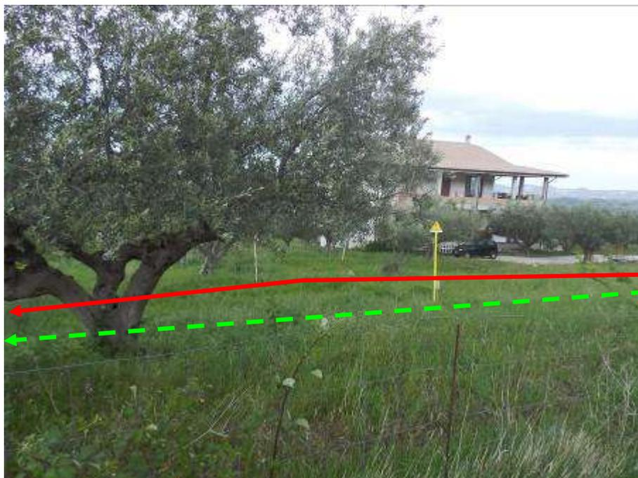
Foto n.5 – Variante per sostituzione curva R<3D DN 400 (16") (in rosso) e la dismissione connessa (in verde)
