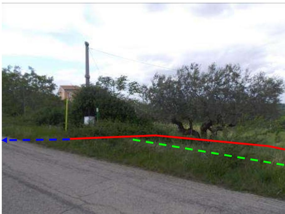
Foto n.6 – Variante per sostituzione curva R<3D DN 400 (16") nel punto di inserimento (in rosso), il metanodotto esistente (in blu) e la dismissione connessa (in verde)
