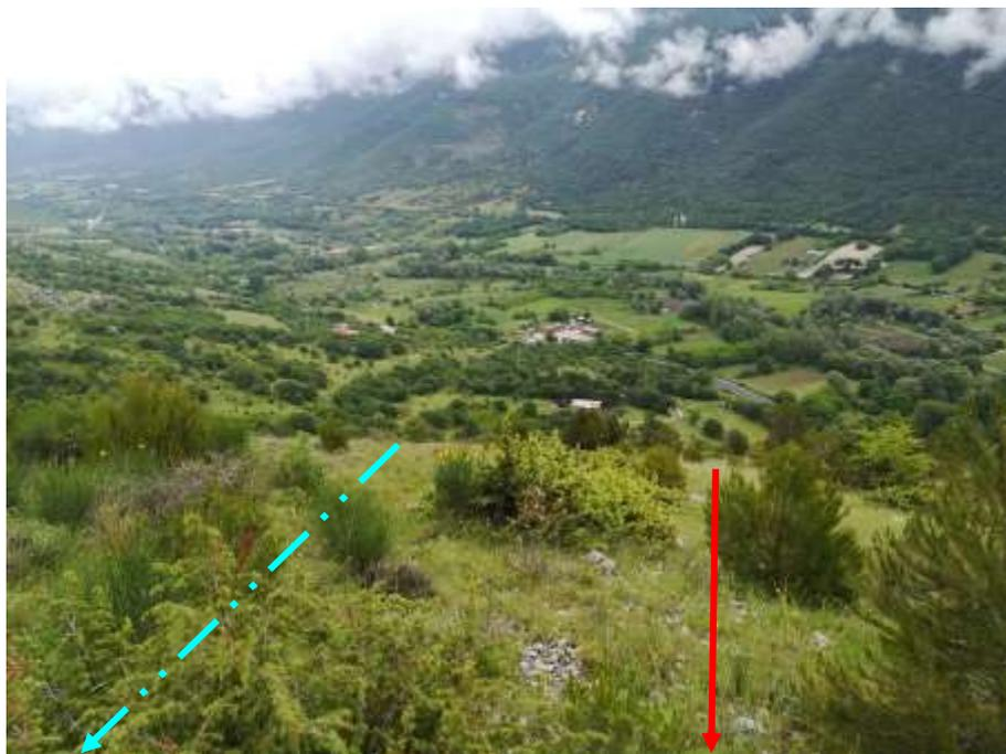
Foto n.15 – Variante per attraversamento Fiume Tirino DN 400 (16") (in rosso) e metanodotto SGI DN 500 (in azzurro)
