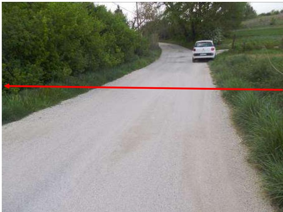
Foto n.11 – Variante per attraversamento Fiume Tirino DN 400 (16"), attraversamento strada comunale Via Pescopiano (in rosso), in trivellazione spingitubo
