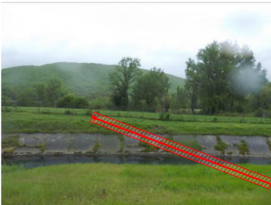
Foto n.14 – Variante per attraversamento Fiume Salto DN 400 (16'') in T.O.C.
