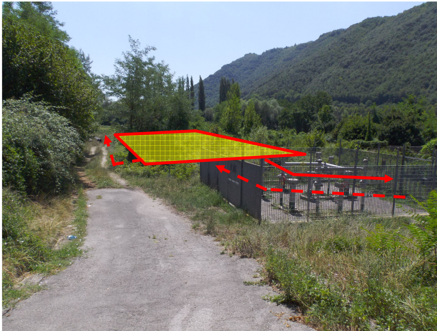
Foto n.26 – Variante per ricollegamento Met. Rieti-Terni DN 300 (12”) (in rosso) all’uscita della nuova trappola di Rieti, il PIDI 45430/32 esistente da dismettere, la variante per adeguamento diametro DN 400 (16”) che entra nella trappola e la variante per ricollegamento Met. Rieti-Roma DN 300 (12”) (in rosso tratteggiato)
