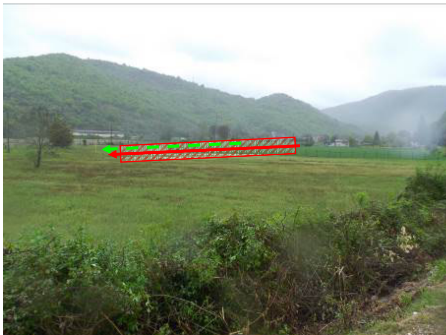
Foto n.12 – Variante per attraversamento Fiume Salto DN 400 (16'') in T.O.C., lato colonna di varo (in rosso) e dismissione connessa (in verde)
