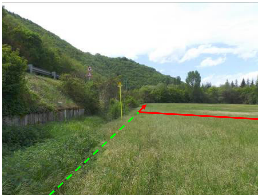
Foto n.16 – Variante per attraversamento Fiume Velino DN 400 (16''), punto di inserimento (in rosso) e dismissione connessa (in verde)
