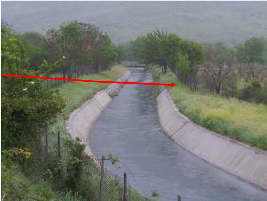
Foto n.7 – Variante per attraversamento Canale scaricatore Cotilia DN 400 (16''), attraversamento in trivellazione spingitubo canale scaricatore Cotilia
