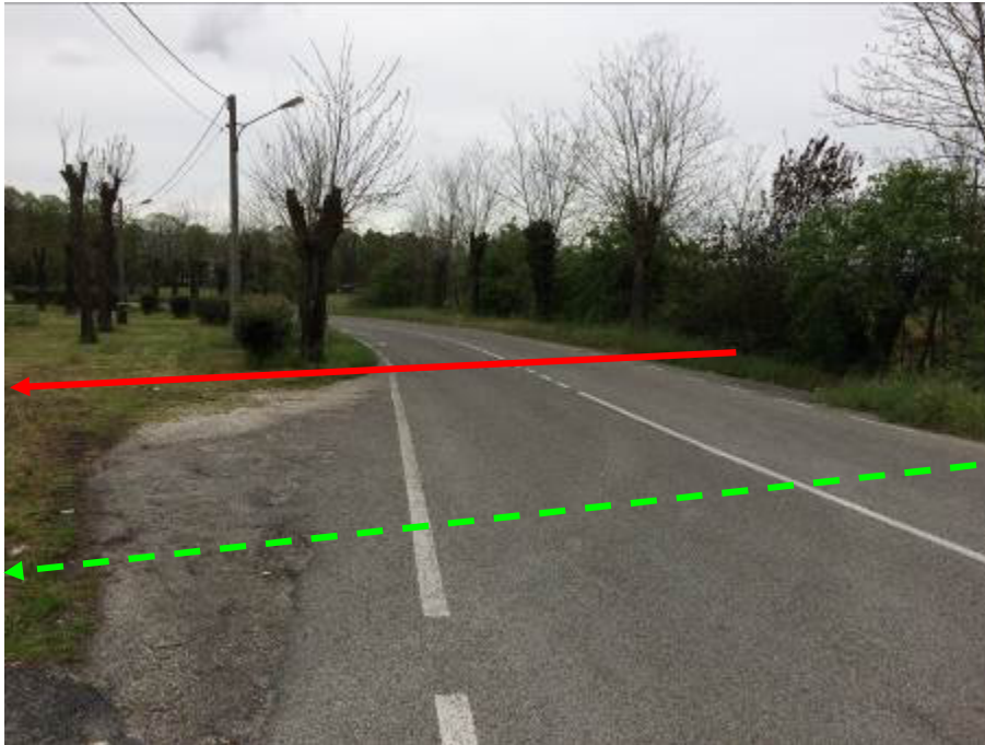
Foto n.21 – Variante per adeguamento diametro DN 400 (16''), attraversamento con trivellazione spingitubo SP 31 (in rosso) e dismissione connessa (in verde)
