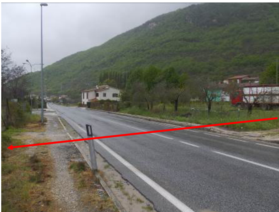
Foto n.8 – Variante per attraversamento Canale scaricatore Cotilia DN 400 (16''), attraversamento in trivellazione spingitubo SS 4
