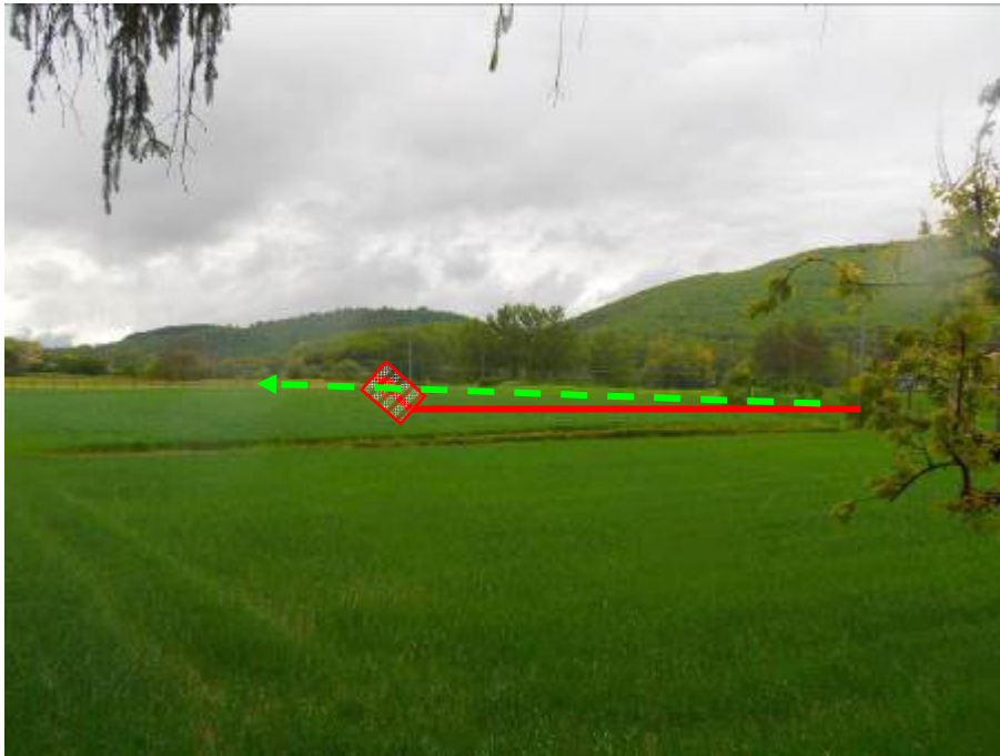
Foto n.13 – Variante per attraversamento Fiume Salto DN 400 (16'') in T.O.C., lato colonna di varo (in rosso) e dismissione connessa (in verde)
