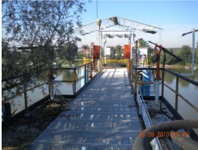
Figura 6: Pontile N. 1 - Pontile di scarico degli olii minerali
