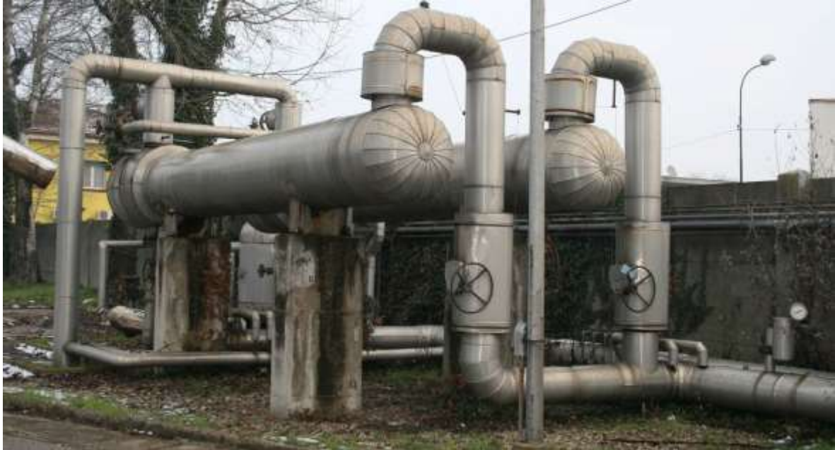
Figura 22: Sistema di riscaldamento dell'olio
