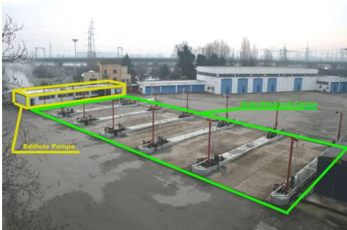
Figura 15: Area rampe di carico ed edificio pompe
