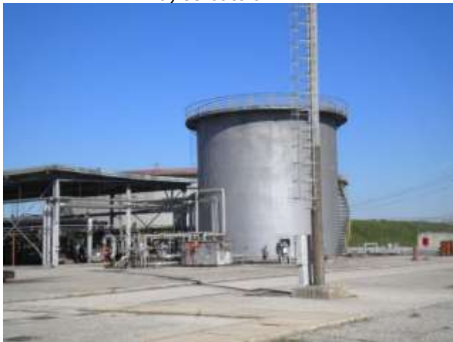
a) serbatoio K11
