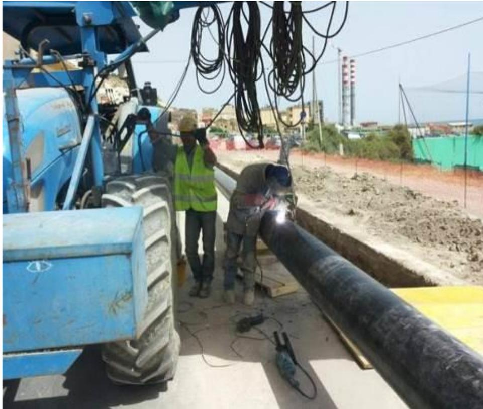
**Fig. 2.6/A** - Foto tipica della fase di saldatura
