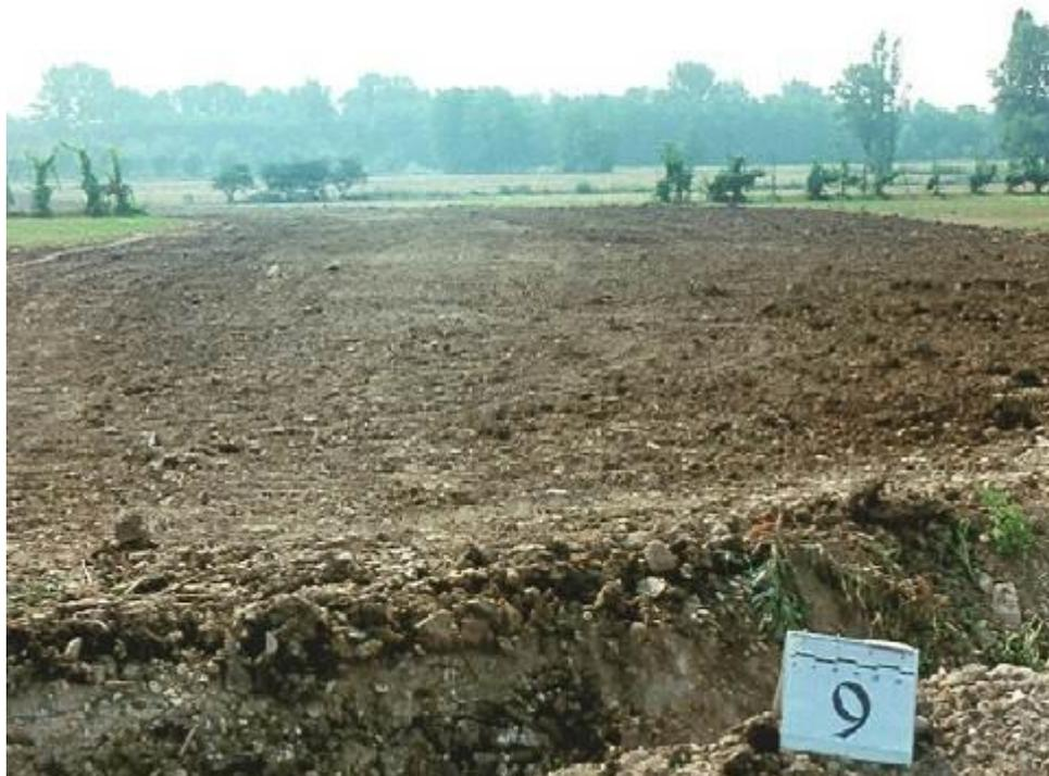
**Fig. 2.12/A** - Rinterro della condotta
