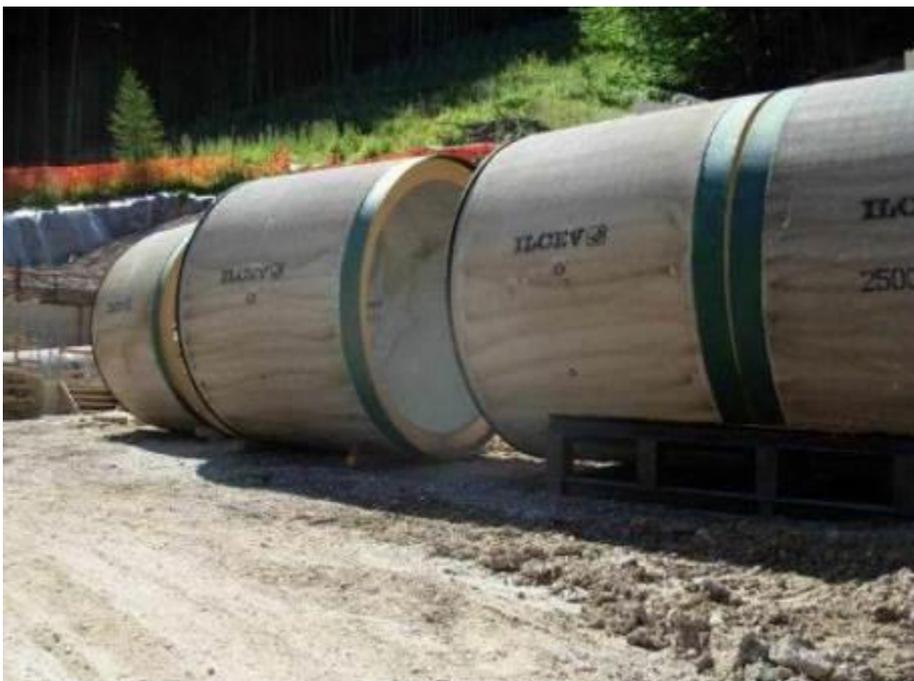
**Fig. 2.13/E** – Stoccaggio tubi in c.a.
