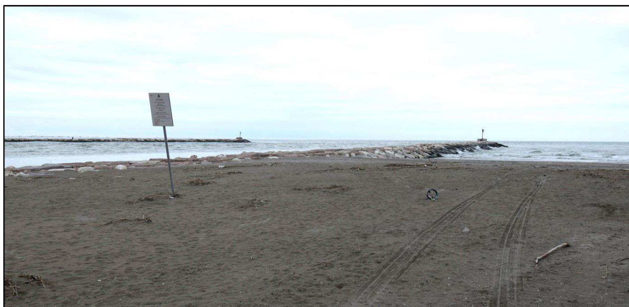
Diga foranea esistente alla bocca del Brenta
