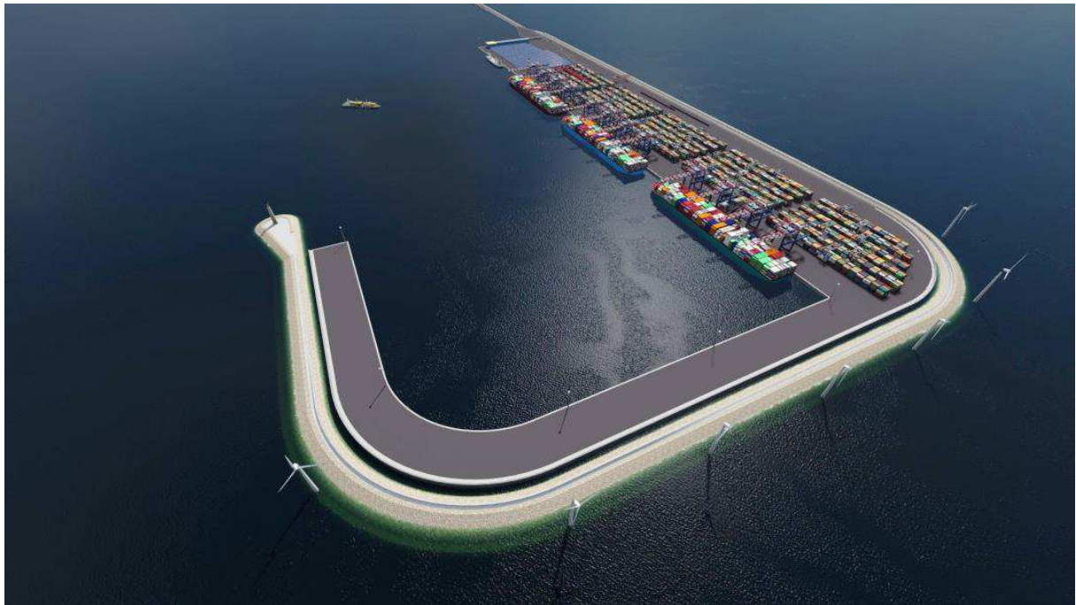
Figura 2 vista dell'impianto eolico a servizio del terminal
