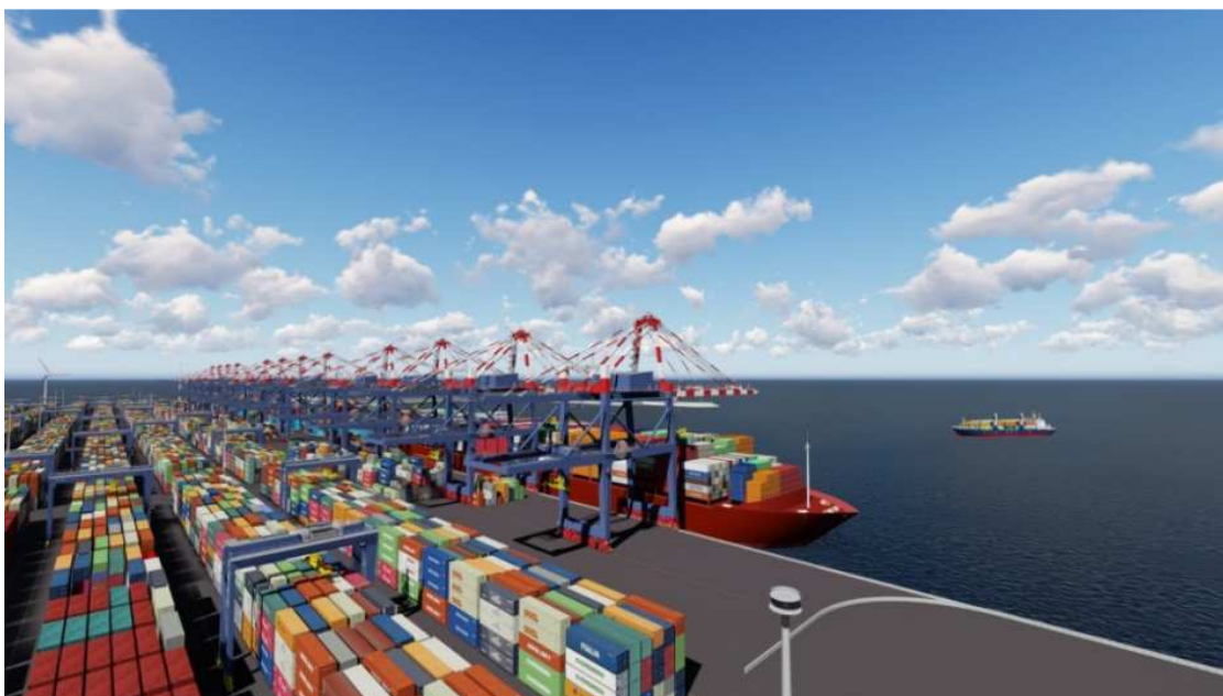
Il piazzale containers
