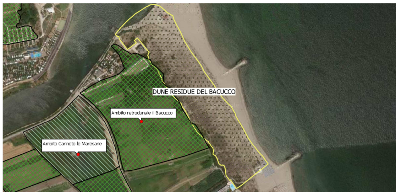
Intervento sul sistema retrodunale del Bacucco
