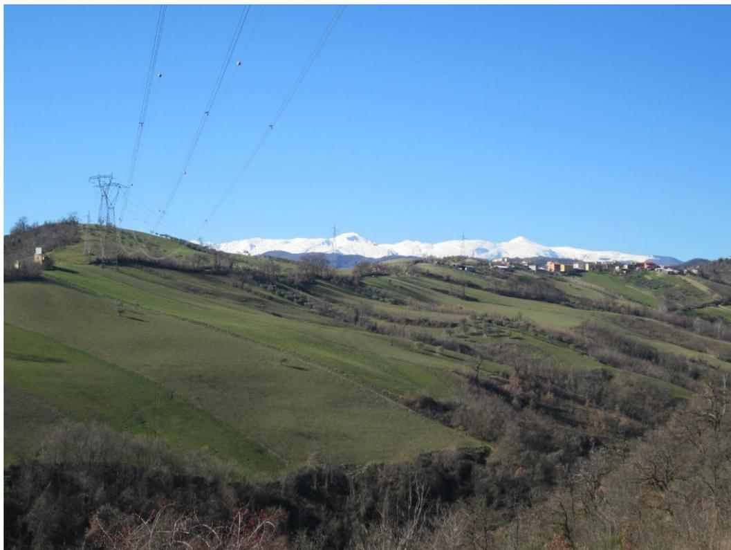
**Foto 1 - Raccordi 132 kV alla SE Teramo. Stato dei luoghi del versante interessato da frana di scorrimento rotazionale quiescente (pericolosità P1) realizzazione dei sostegni tratto 16N - e 16/3**
