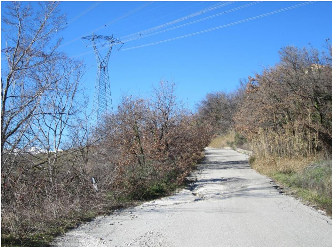
**Foto 4 – Area raccordi alla SE Teramo – Versante in sinistra idrografica del F. Vomano. Strada dissestata in zona a pericolosità P2 (corpo di frana di scorrimento rotazionale, settore compreso tra nuovo sost. 395/1 a monte e nuovi sostegni 16/5, 19/5 a valle**
