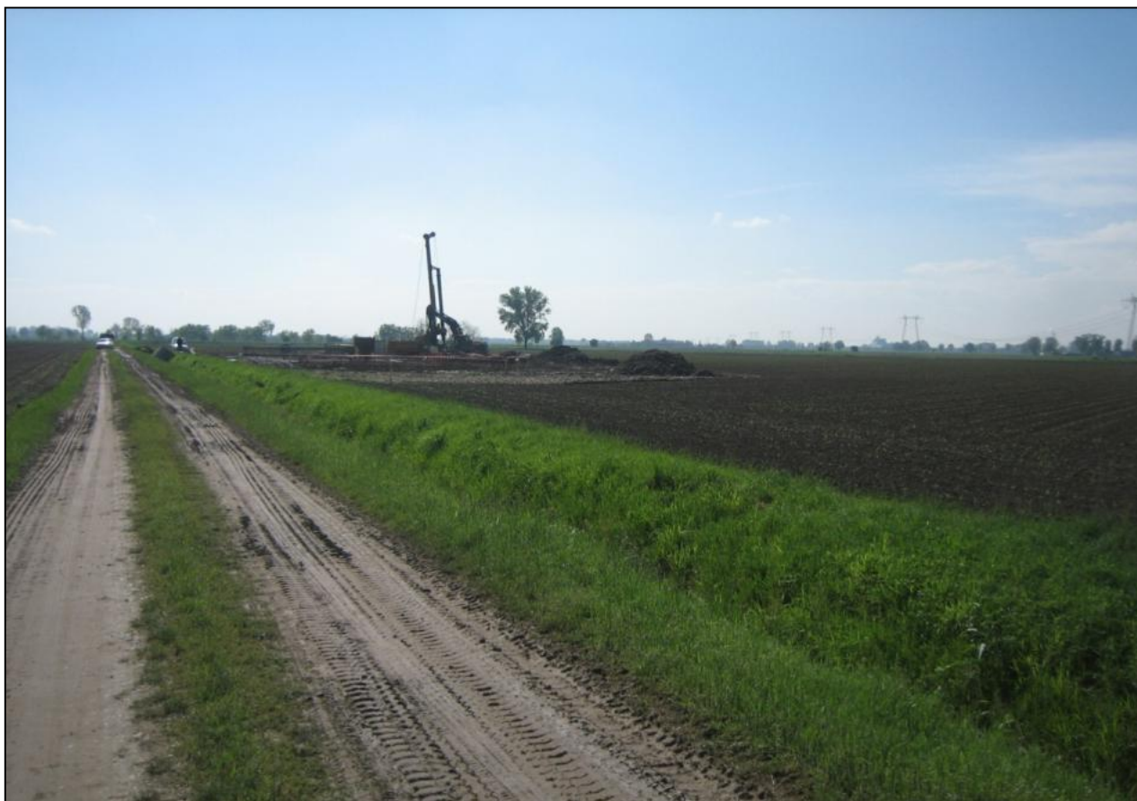
Figura 35 - Esempio di micro cantiere con pista di accesso
