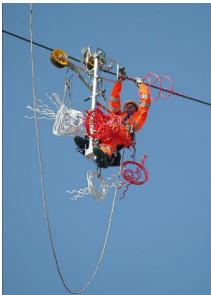
Figura 59 - Montaggio dissuasori di segnalazione per avifauna
