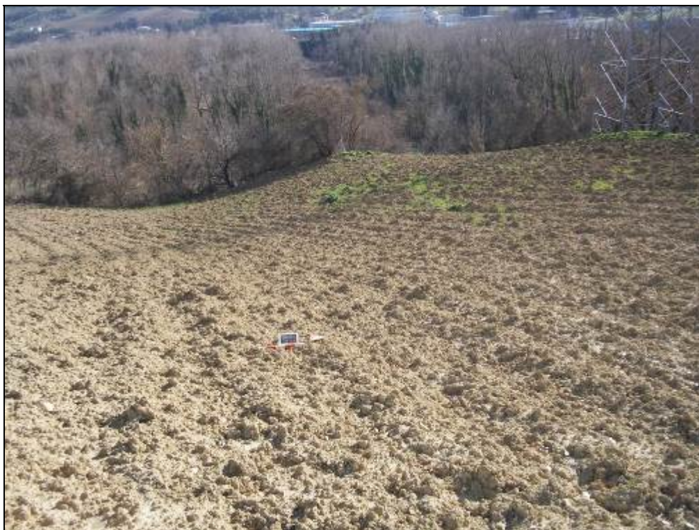
Foto n.47 Comune di Teramo, panoramica delle superfici del sostegno N19/4 ( ID 7 ) ripresa da Nord.
