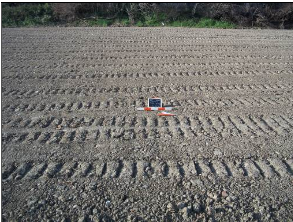
Foto n.120 Comune di Basciano, panoramica delle superfici del sostegno N 30/3 ( ID 31 ) ripresa da Est.
