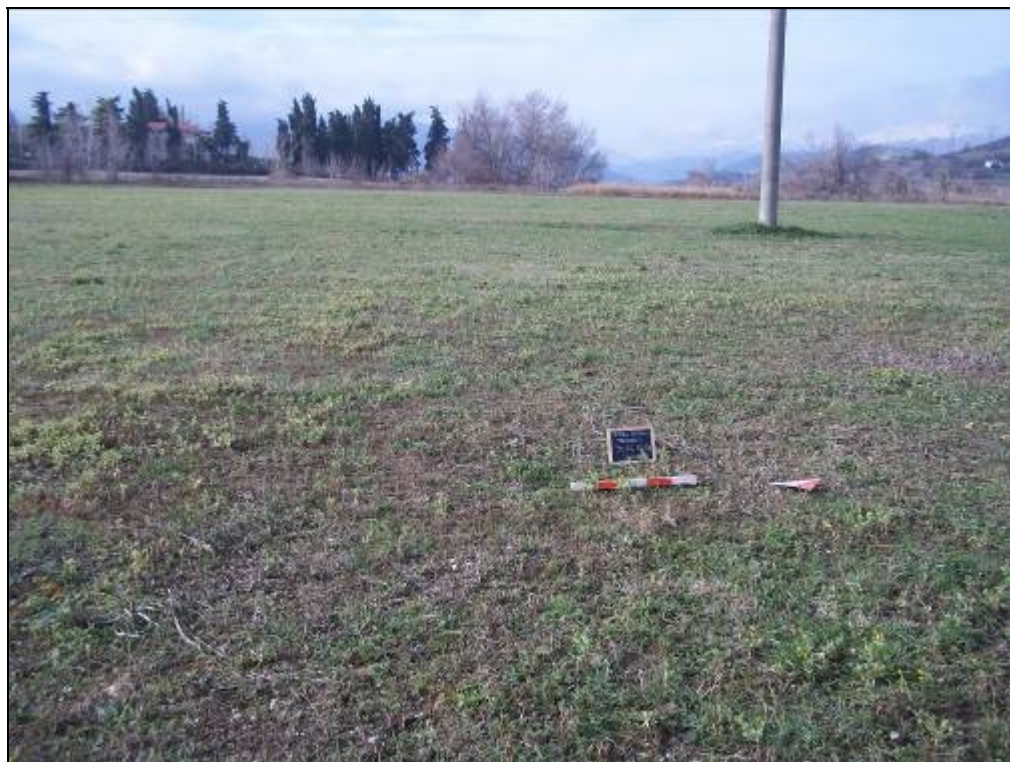
Foto n.136 Comune di Basciano, panoramica delle superfici del sostegno N 30/4 ( ID 13 ) ripresa da Sud.
