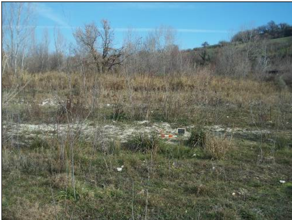
Foto n.153 Comune di Basciano, panoramica delle superfici del sostegno N 31/5 ( ID 14 ) ripresa da Ovest.
