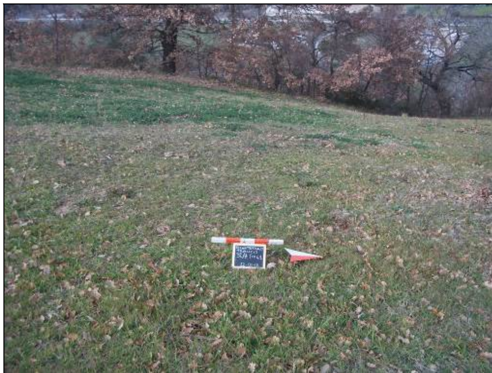
Foto n.164 Comune di Basciano, panoramica delle superfici del sostegno N 31/7 ( ID 41 ) ripresa da Est.
