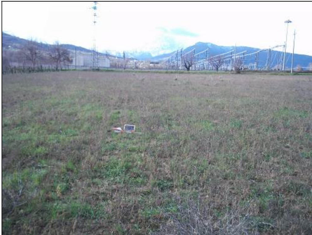
Foto n.33 Comune di Teramo, panoramica delle superfici del sostegno N 398/1 ( ID 52 ) ripresa da est.
