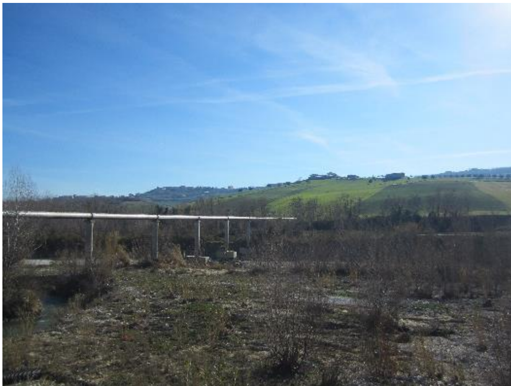
Foto 7 – Elettrodotto 132 kV Cellino-Roseto; attraversamento Fiume Vomano tratto sostegno 26-27
