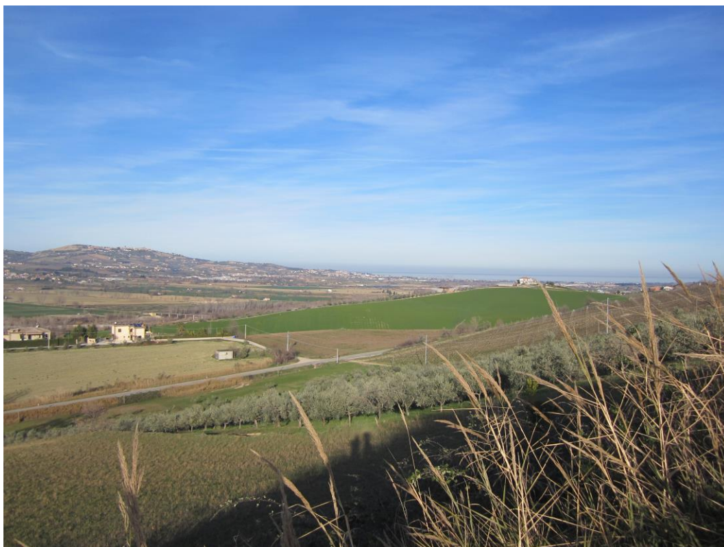
Foto 6 - Elettrodotto 132 kV Cellino-Roseto – Panoramica verso Nord Est; tratto nuovi sost. 24-25
