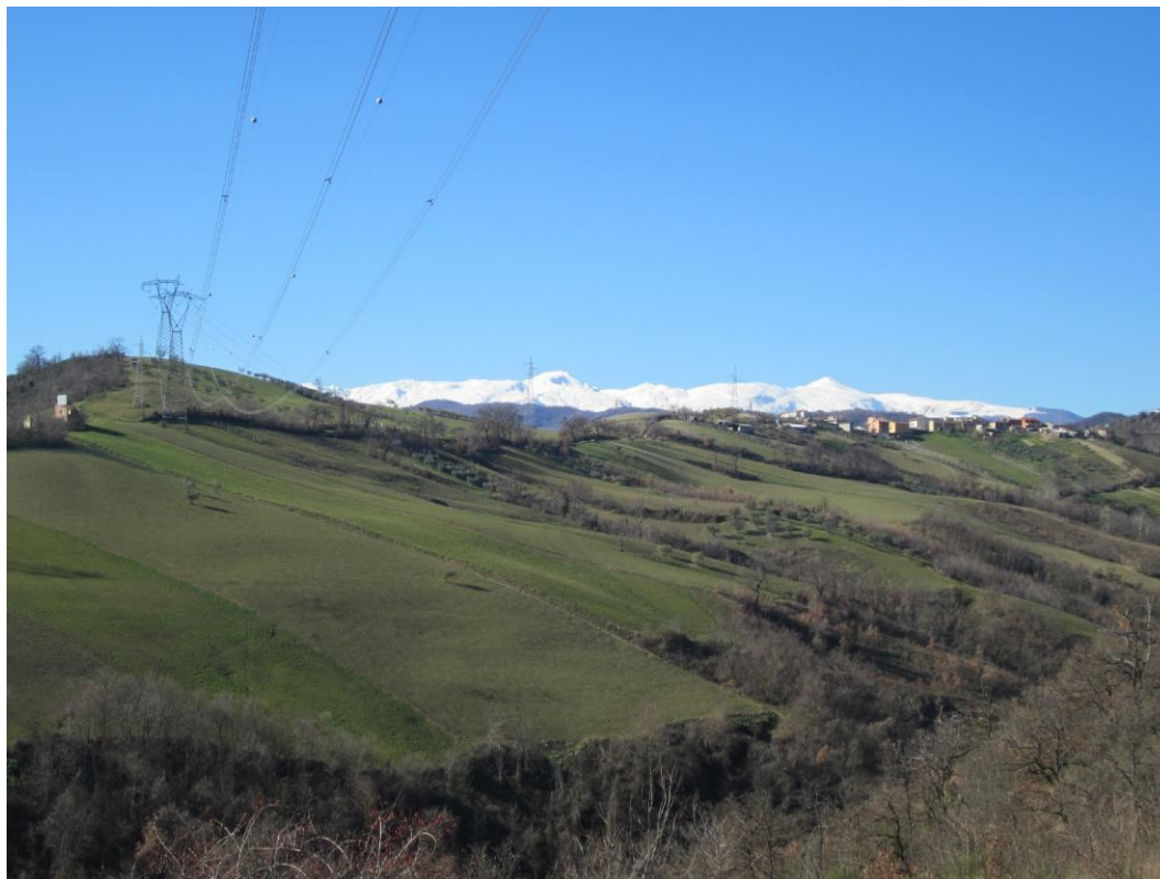
Foto 1 - Raccordi 132 kV alla SE Teramo. Tratto sostegni tratto 16N - e 16/3
