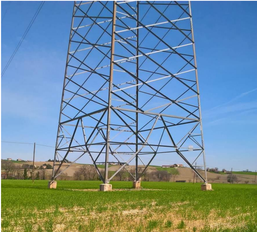
Figura 11 – Ingombro alla base di un sostegno a traliccio
