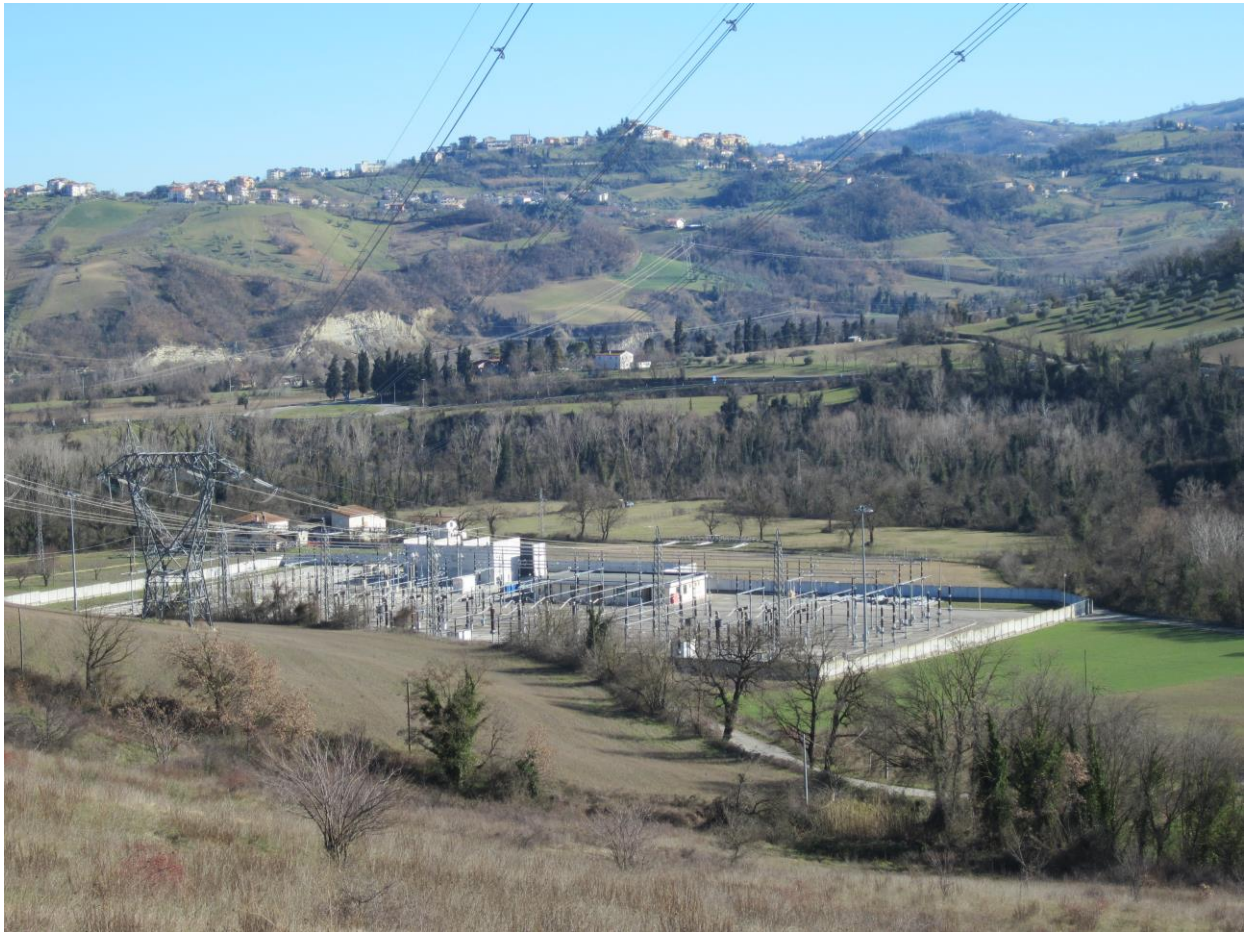
Foto 1 – Raccordi 132kV alla SE Teramo –area sostegni 30/2 e 31/2 (zona pianeggiante oltre la stazione elettrica)
