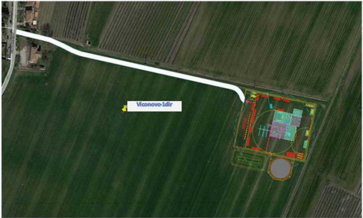
Figura 1.5 - Strada di accesso alla postazione da realizzare (tracciata in bianco). Il pin giallo - Pozzo Viconovo 1 dir - indica la posizione del fondo pozzo.
