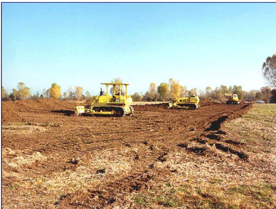
Foto II-5.1.B Apertura dell'area di passaggio
