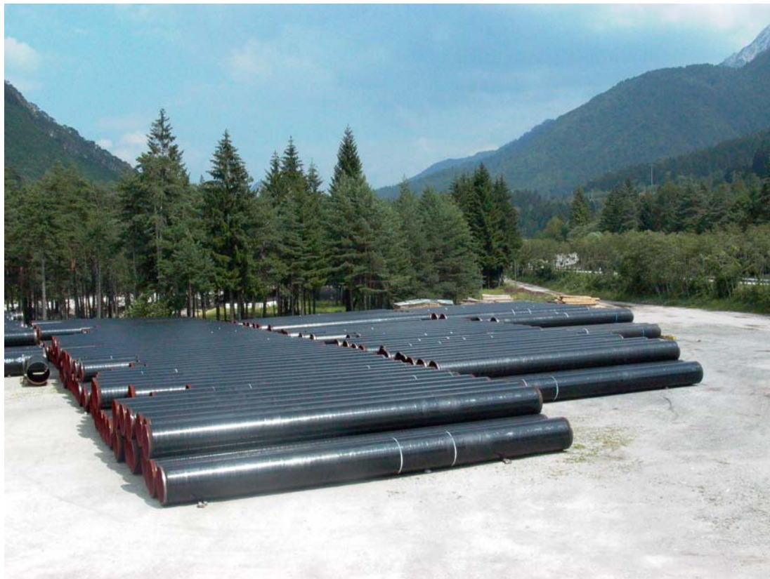
Foto II-5.1.A Piazzola di accatastamento tubazioni
