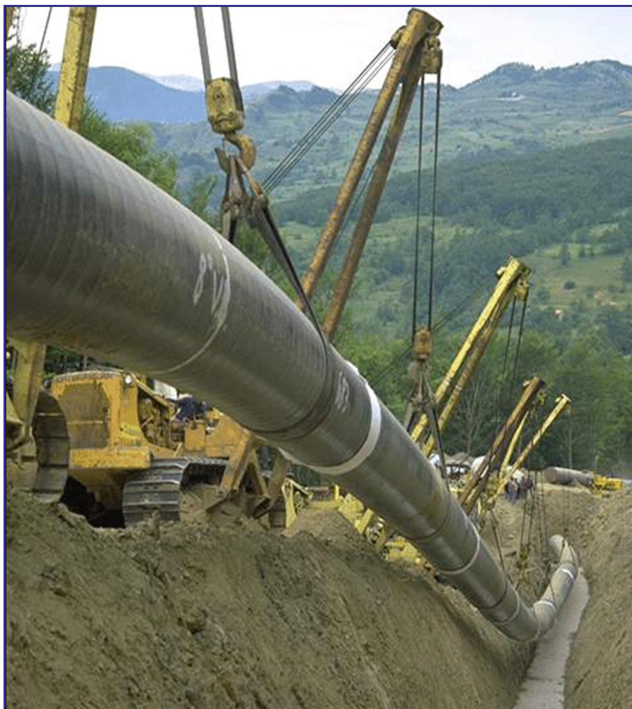
Foto II-5.1.F Posa della condotta
