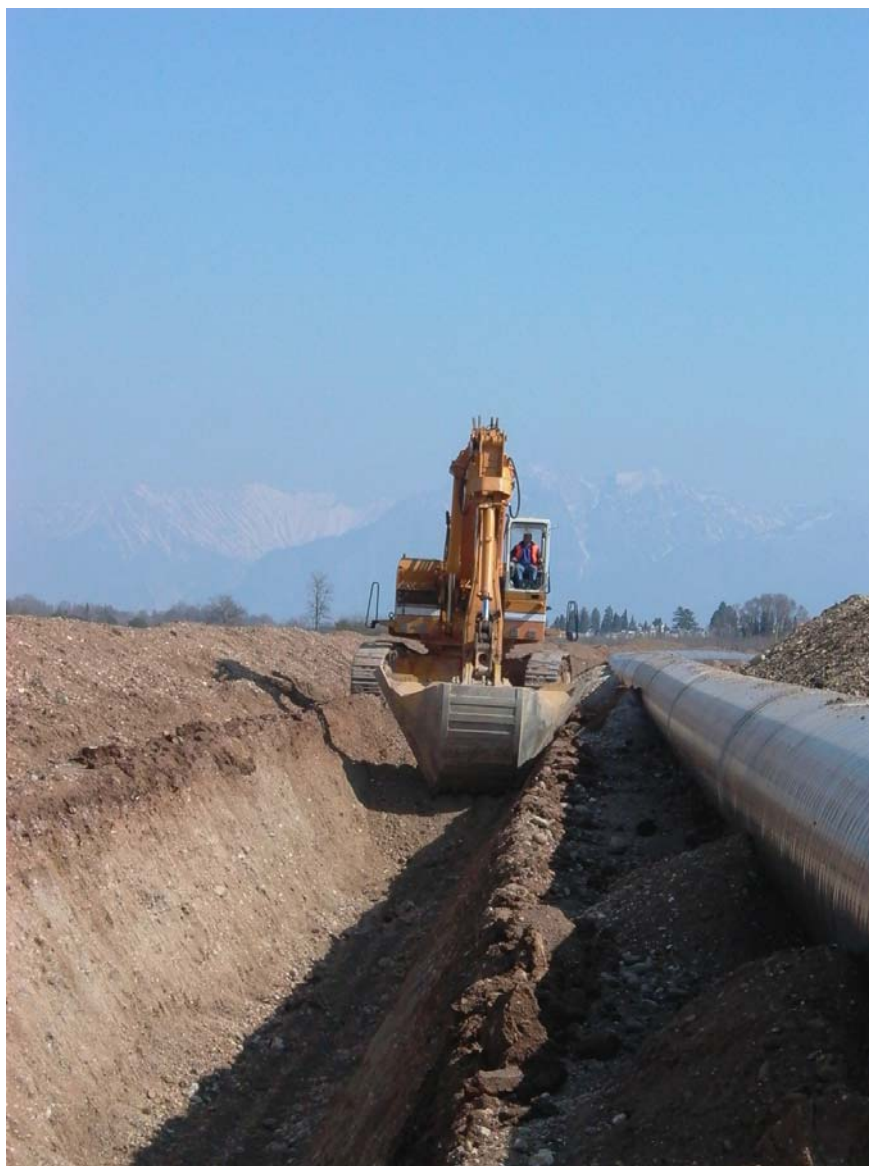
Foto II-5.1.E Scavo della trincea
