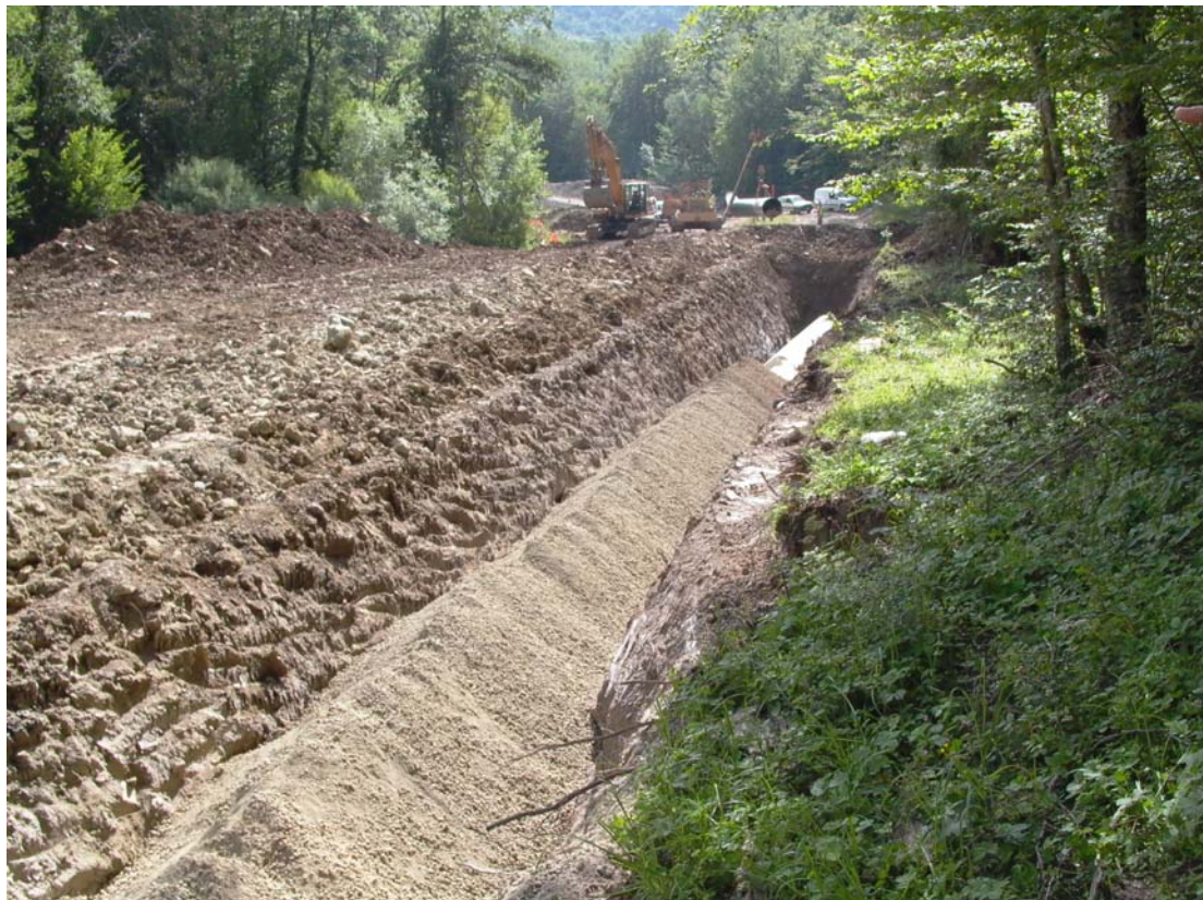
Foto II-5.1.G Rinterro della condotta
