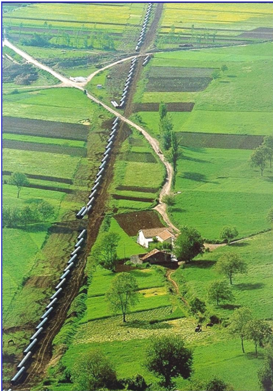
Foto II-5.1.C Sfilamento tubazioni
