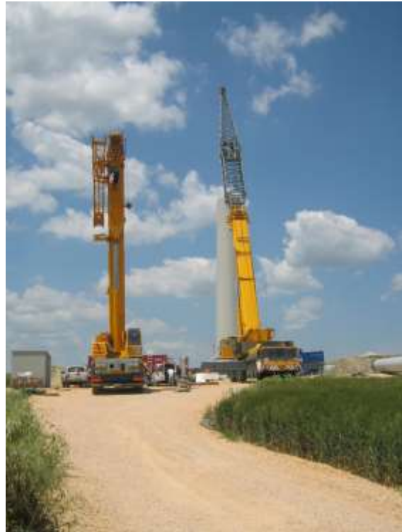
Figura 4: particolare smontaggio torre
