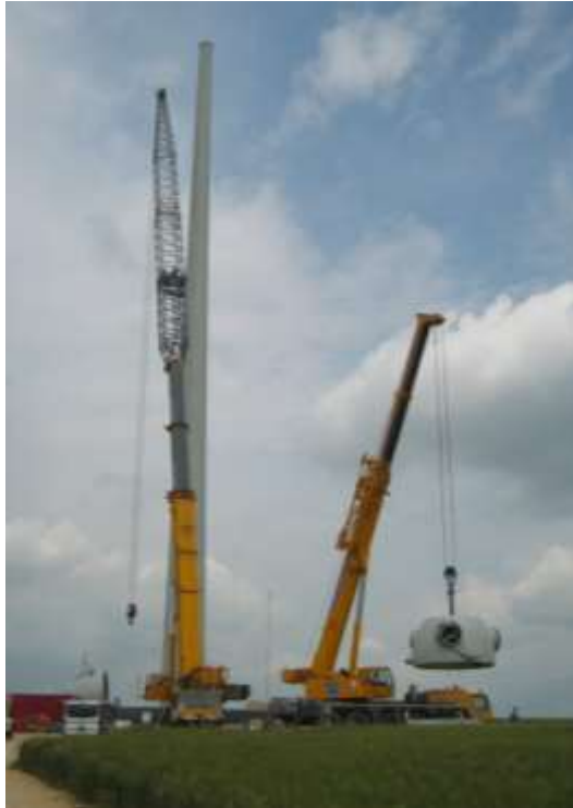
Figura 3: smontaggio navicella
