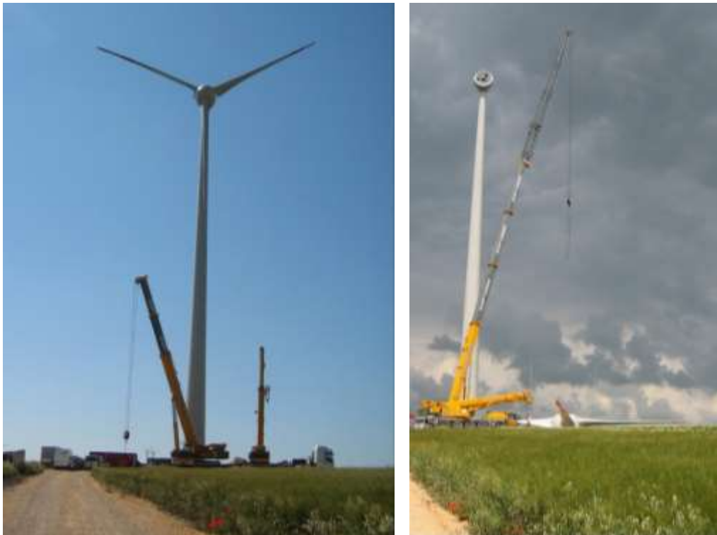
Figura 2: rimozione eliche e mozzo
