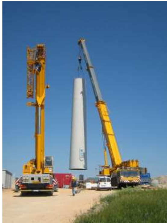
Figura 5: elemento torre smontata da trasportare
