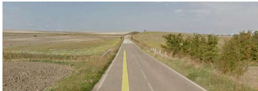
Figura 5 – Attraversamento cavidotto esterno (soluzione di progetto) su Canale Pozzo Vitolo – SP103
