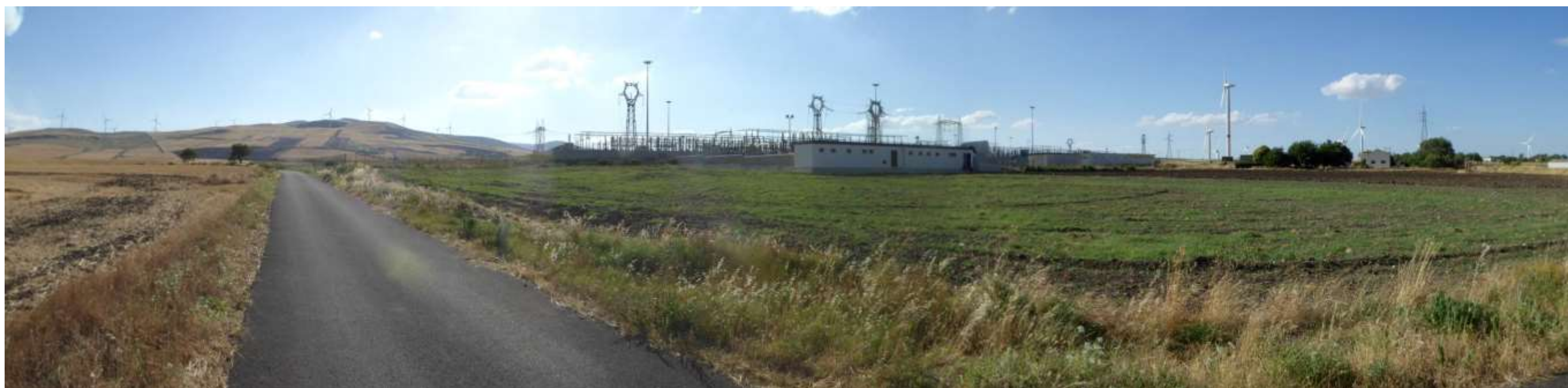
Figura 7: Panoramica dell'area della stazione RTN Deliceto
