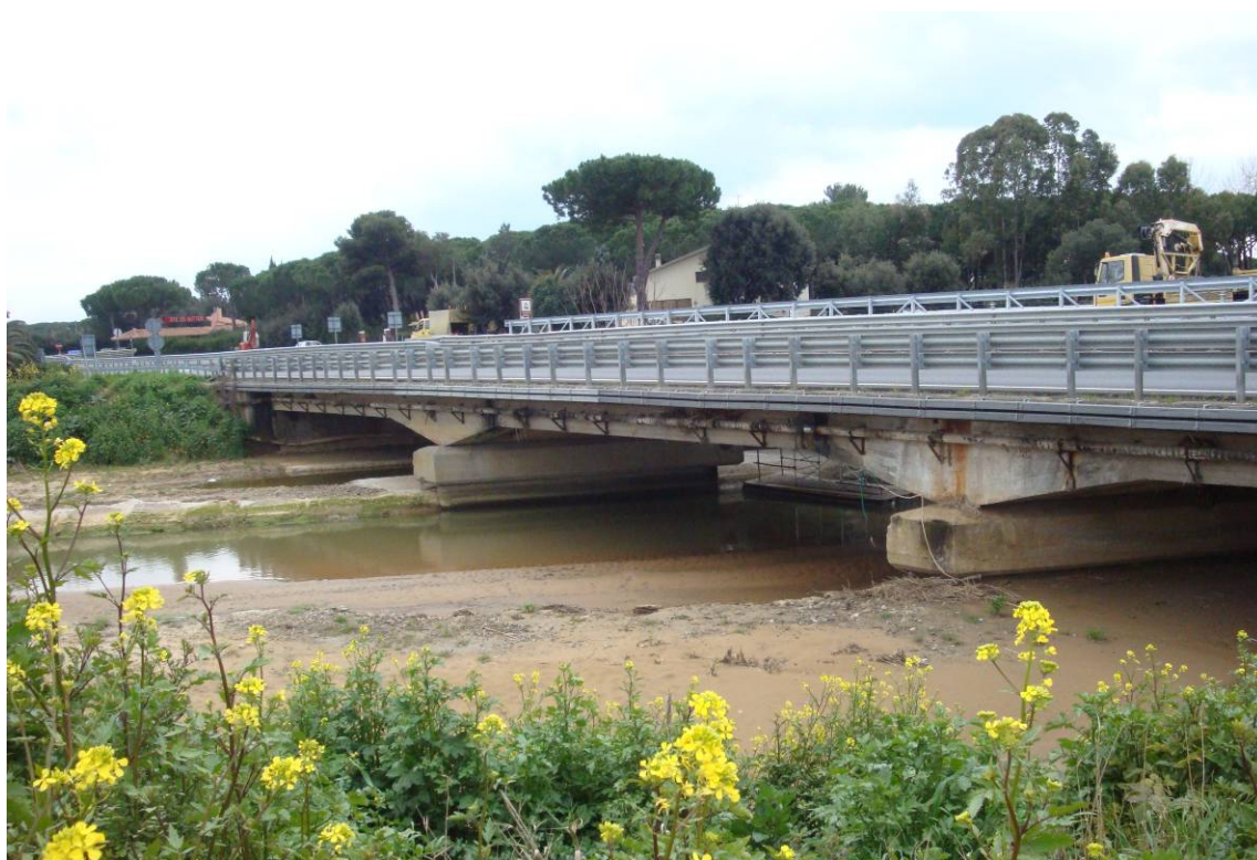
Foto 2 – Vista laterale da monte
