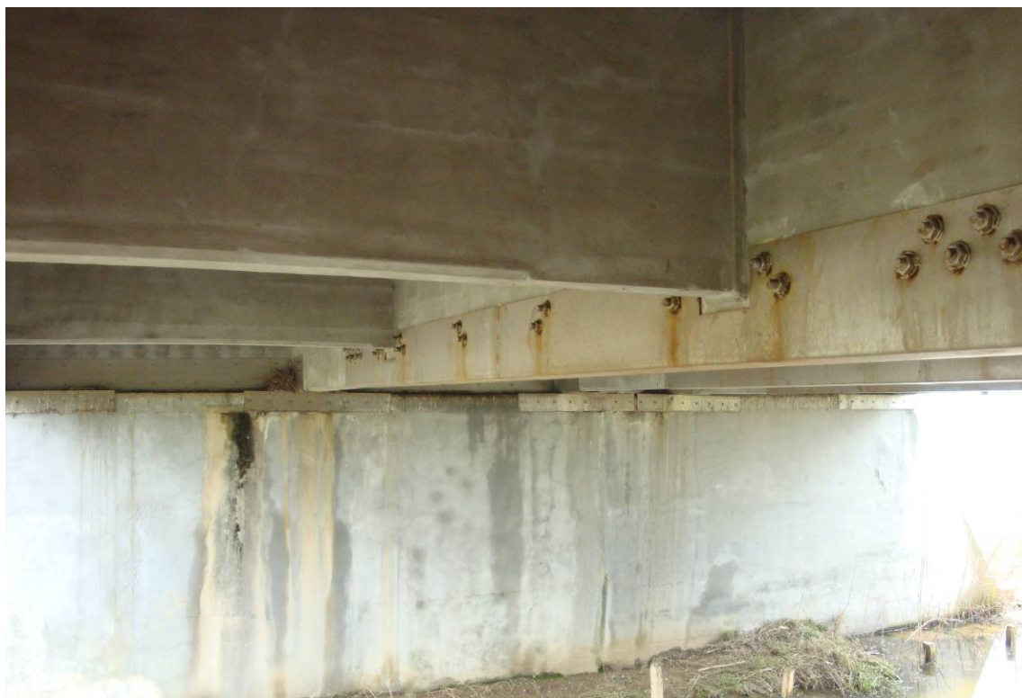
Foto 8 – Vista intradosso – placcaggio trave
