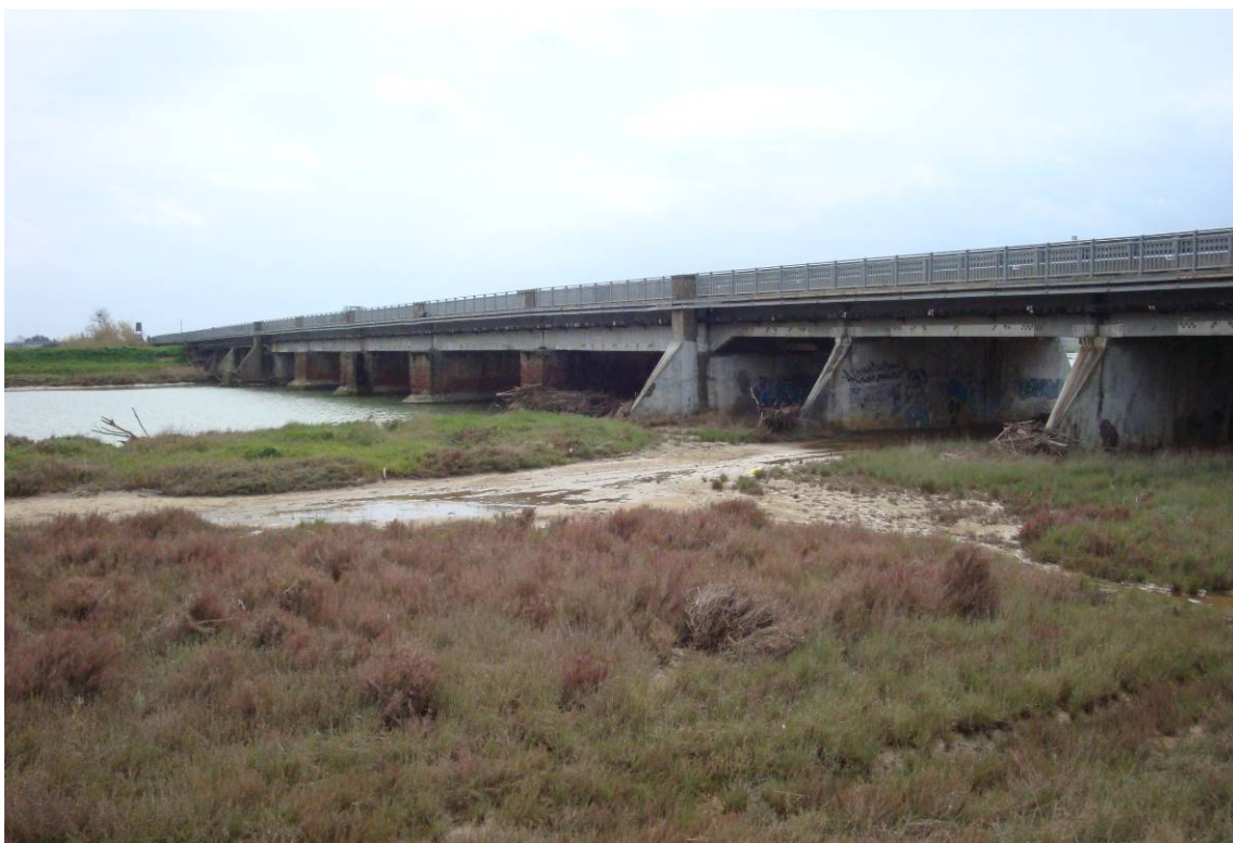
Foto 3 – Vista laterale da monte
