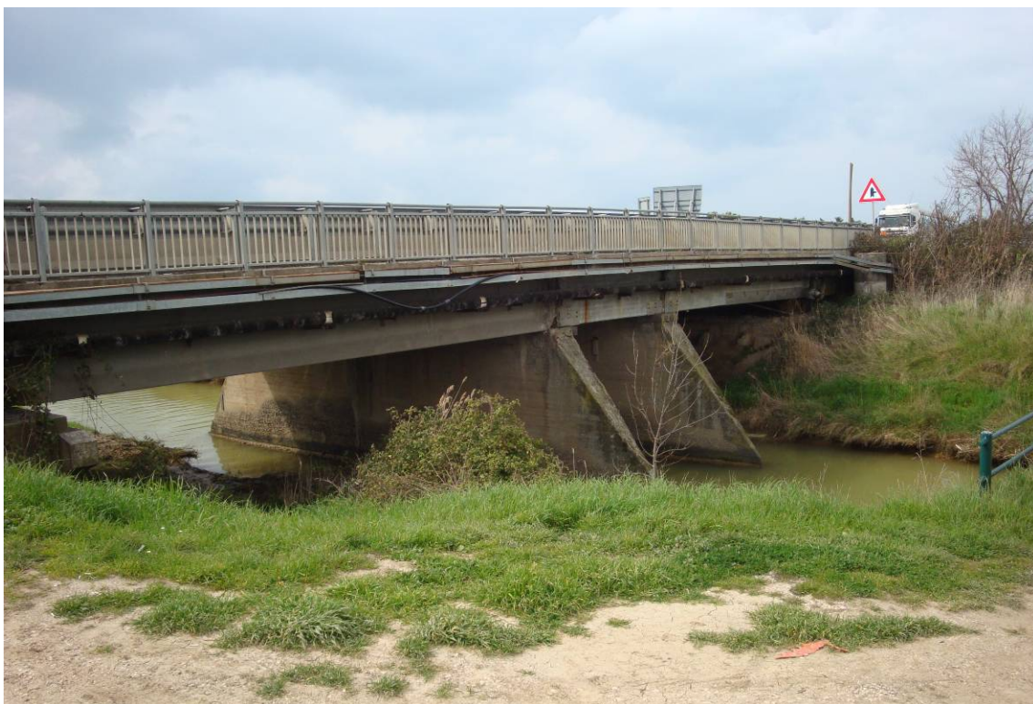
Foto 4 – Vista laterale da monte – campate sul canale nord
