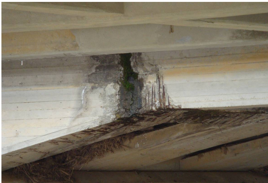
Foto 11 – Particolare seggiola gerber impalcato monte
