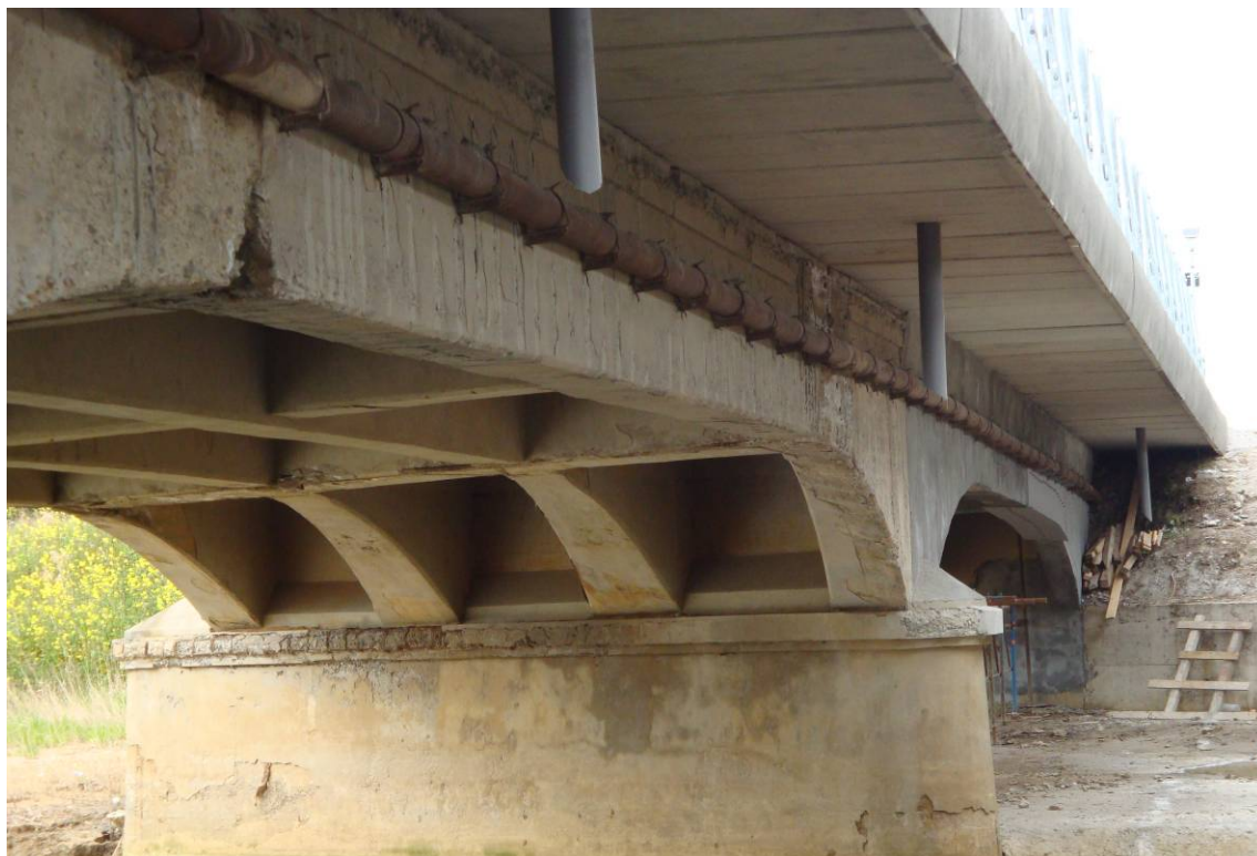
Foto 10 – Vista intradosso impalcato valle, campata centrale
