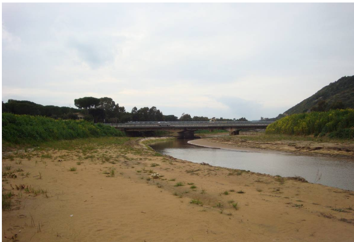
Foto 1 – Vista laterale da monte
