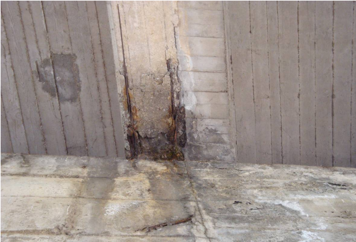
Foto 5 – particolare intradosso impalcato - appoggio trave doppia
