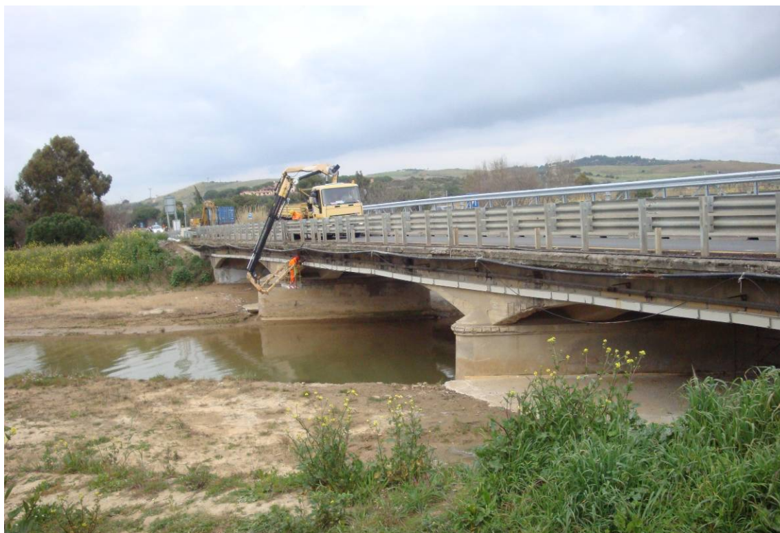
Foto 4 – Vista laterale da valle
