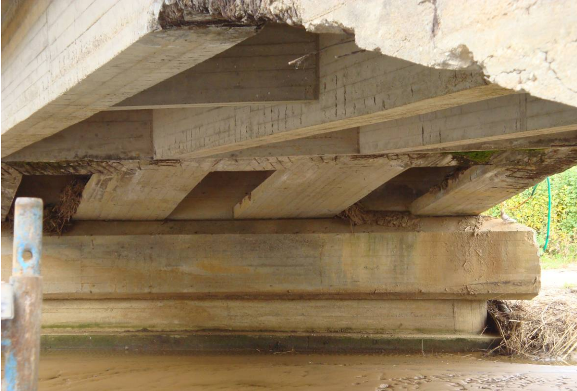
Foto 7 – Vista intradosso impalcato monte, campata centrale
