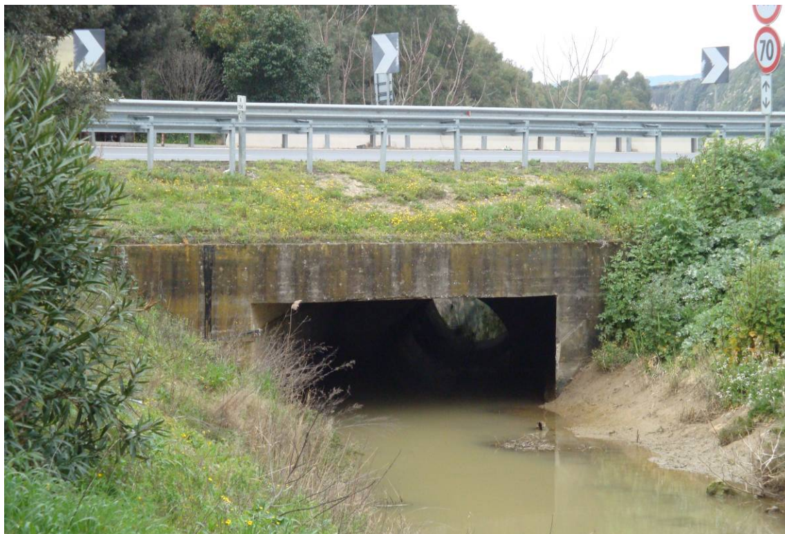
Foto 5 – Scatolare sul canale sud
