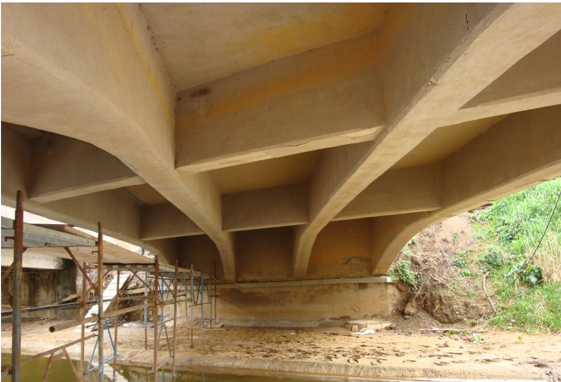
Foto 8 – Vista intradosso impalcato valle, campata sud
