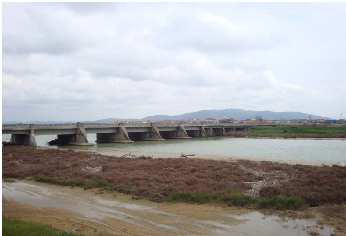
Foto 1 – Vista laterale da valle
