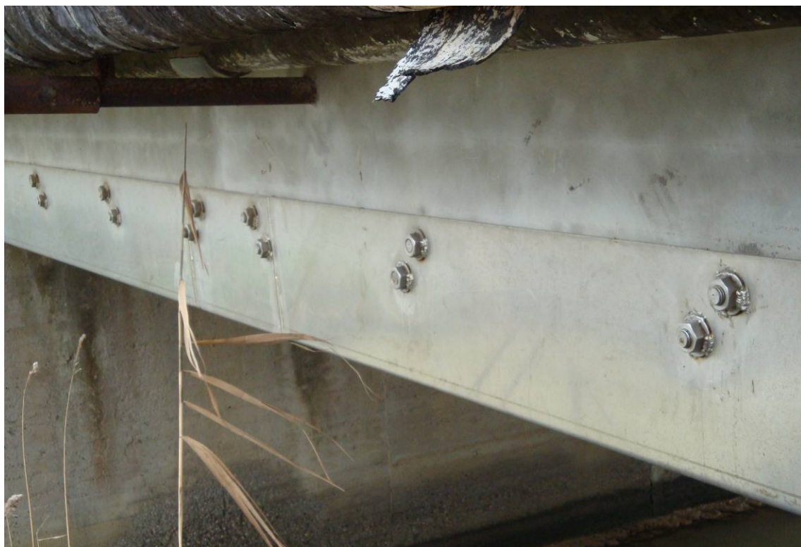
Foto 9 – particolare placcaggio trave
