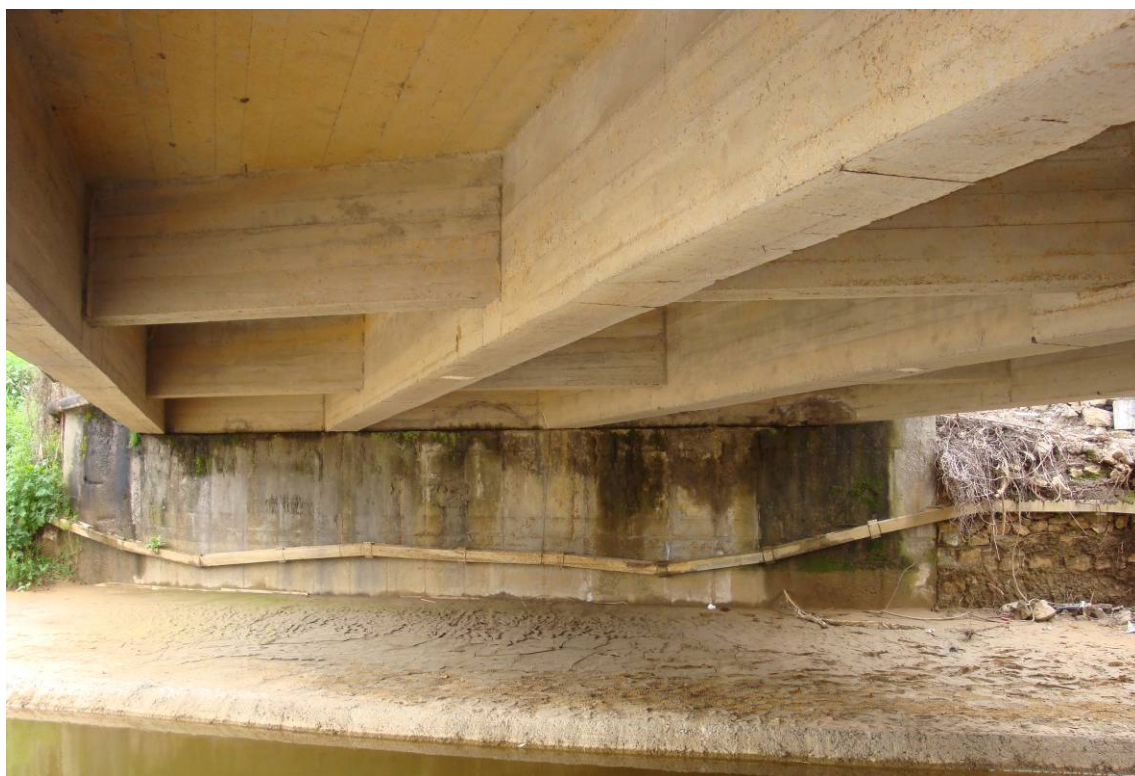
Foto 6 – Vista intradosso impalcato monte, campata sud
