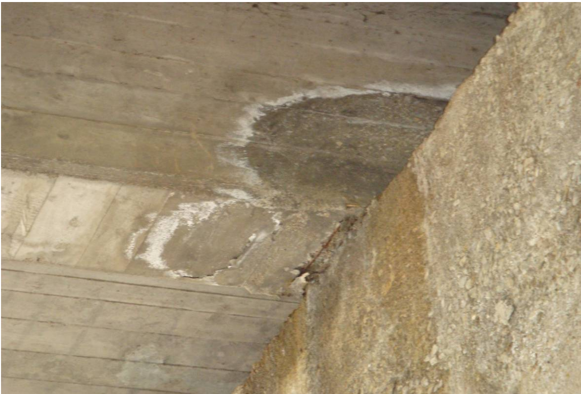
Foto 6 – Particolare intradosso impalcato – appoggio trave
