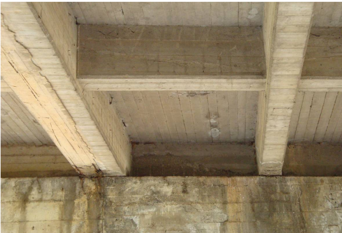
Foto 4 – particolare intradosso impalcato - appoggio trave doppia
