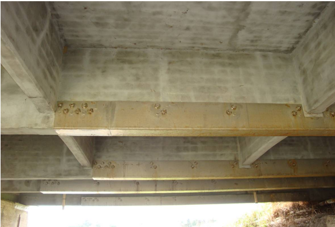
Foto 8 – Vista intradosso – placcaggio trave
