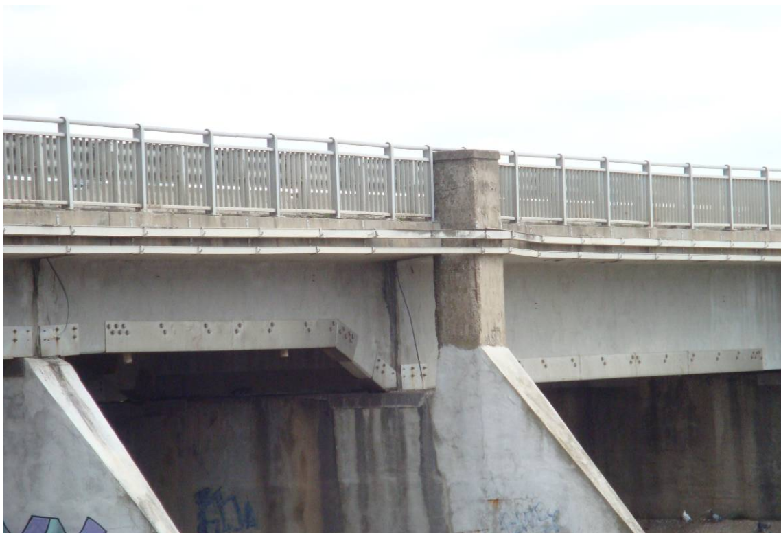
Foto 6 – Vista laterale da valle – particolare placcaggio travi
