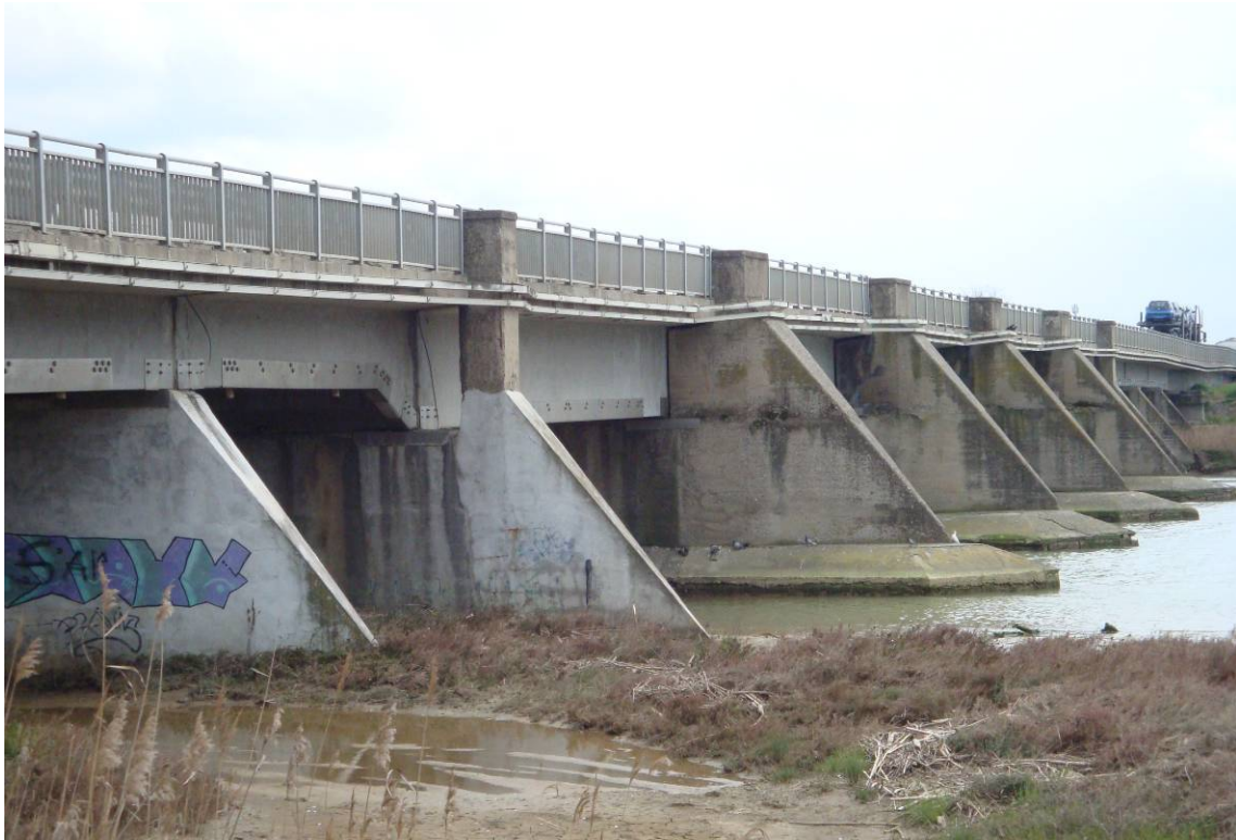
Foto 5 – Vista laterale da valle – particolare variazione di altezza delle travi
