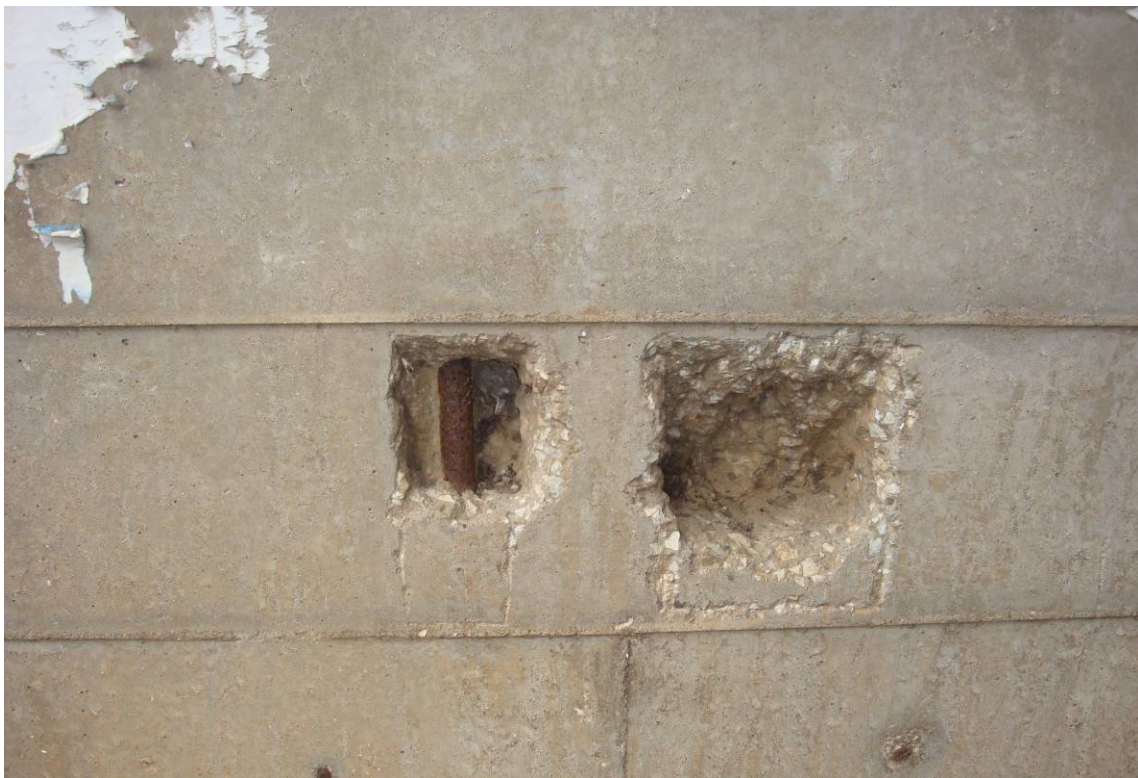
Foto 6 – Particolare saggi conoscitivi sulle spalle
