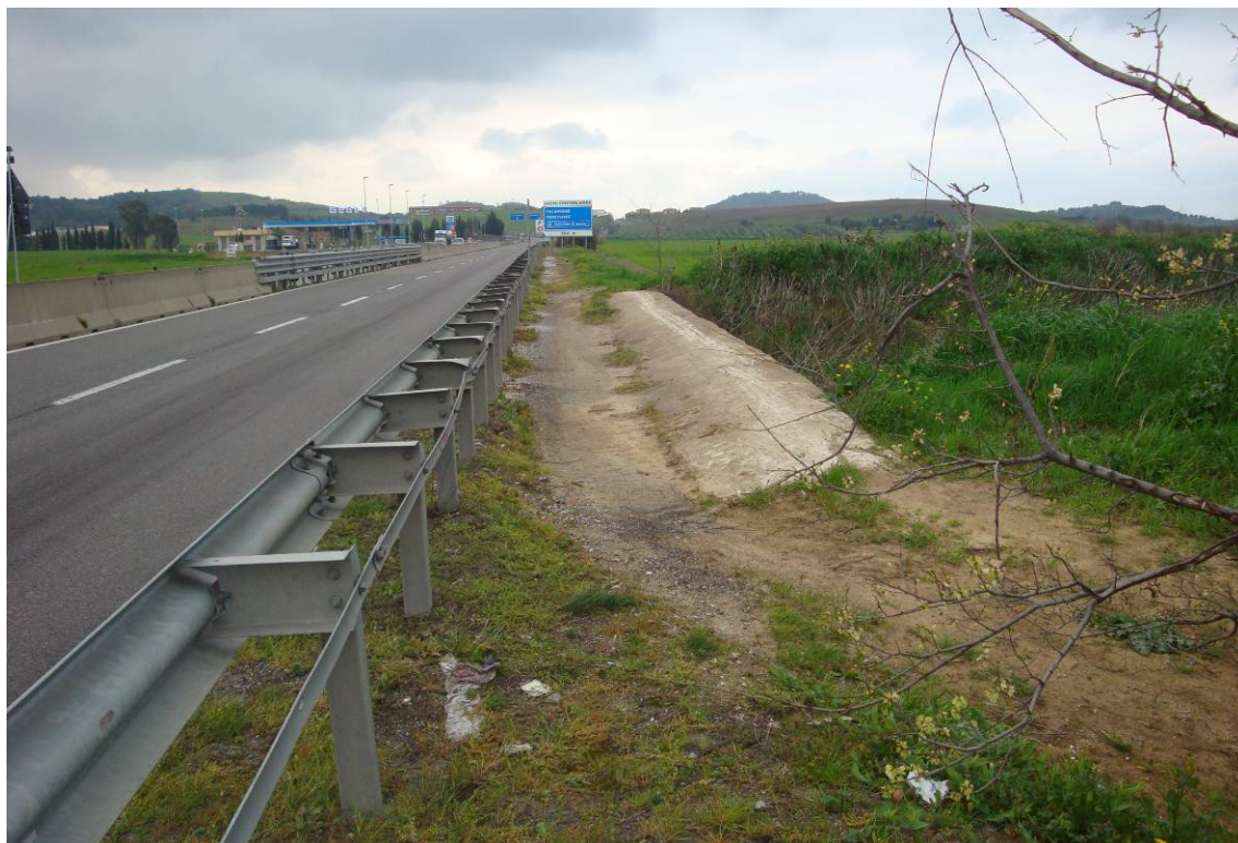
Foto 5 – Vista estradosso lato valle
