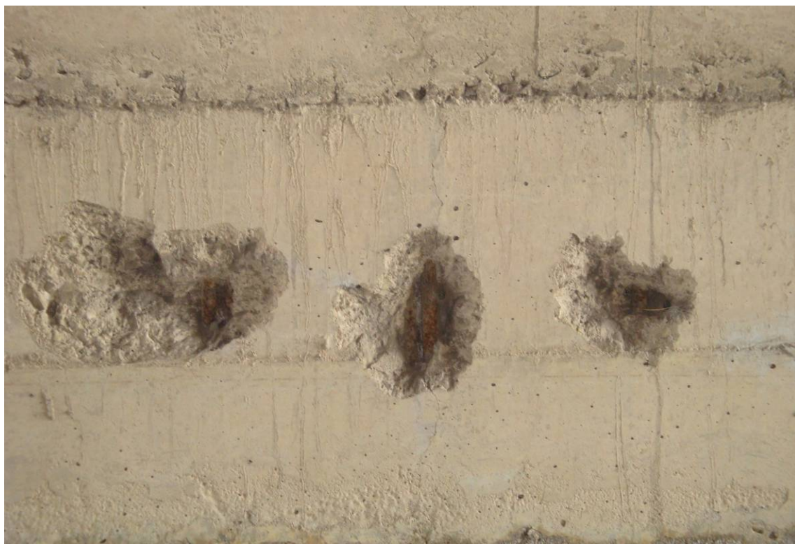
Foto 6 – Muro frontale della spalla – particolare saggi conoscitivi
