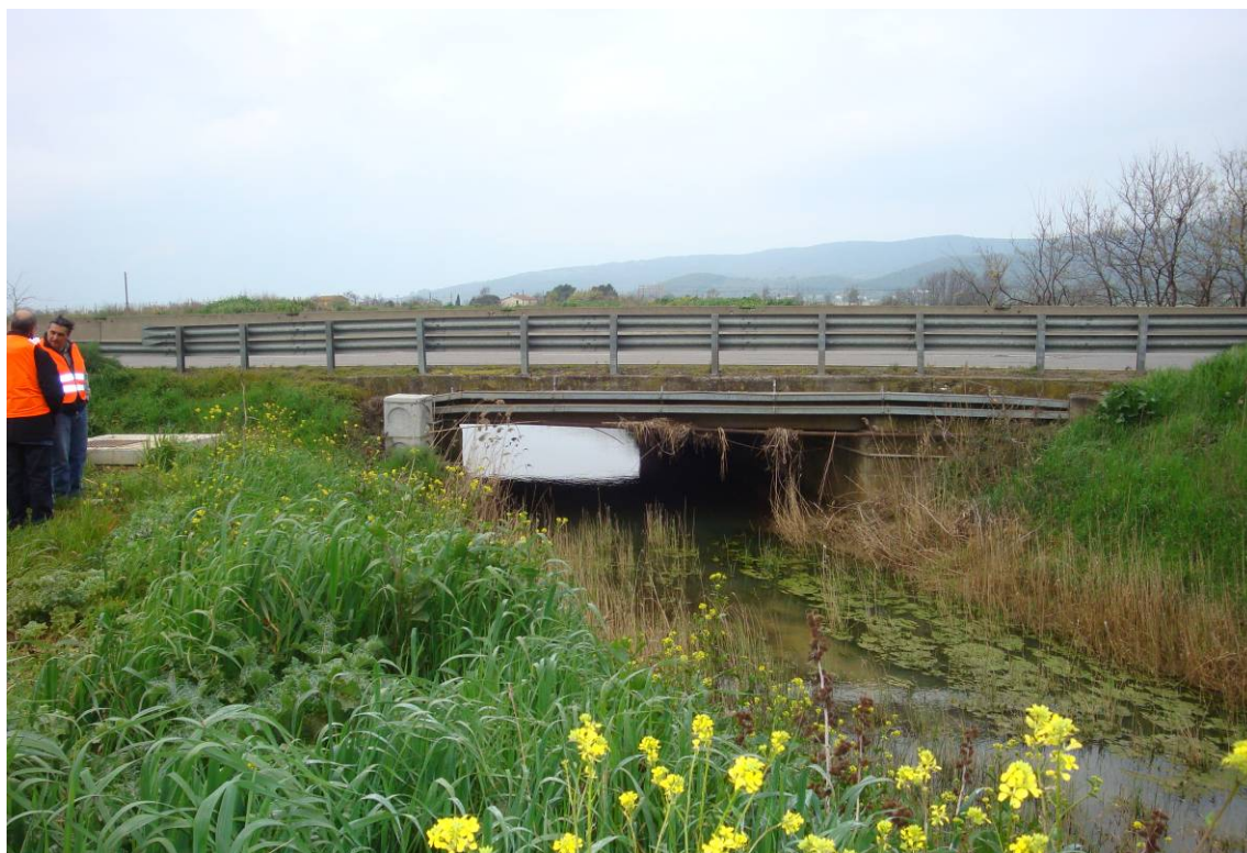
Foto 1 – Vista laterale da monte
