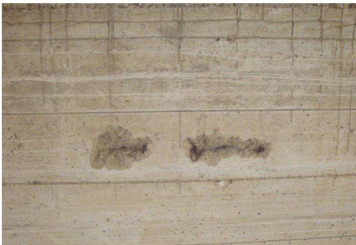
Foto 4 – Muro frontale della spalla – particolare saggi conoscitivi
