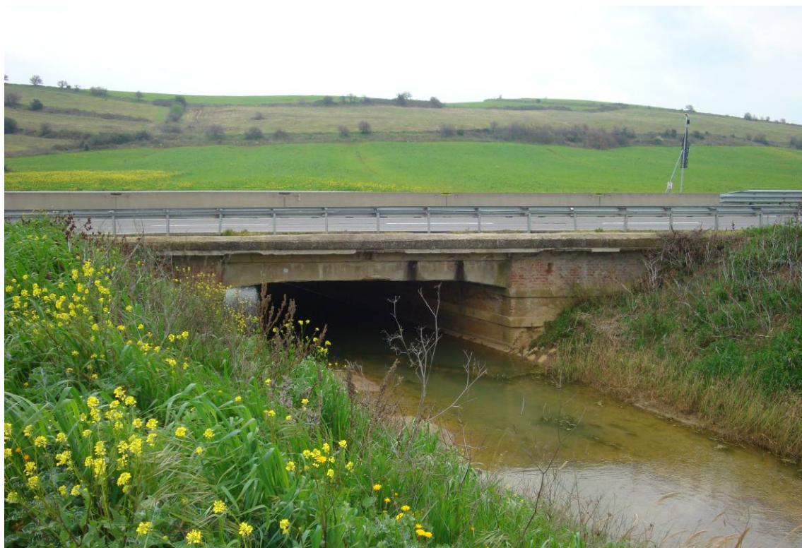
Foto 2 – Vista laterale da valle
