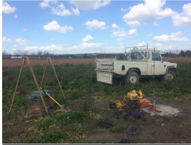
Figura 7.5 – Fase di esecuzione del carotaggio sismico down-hole.
