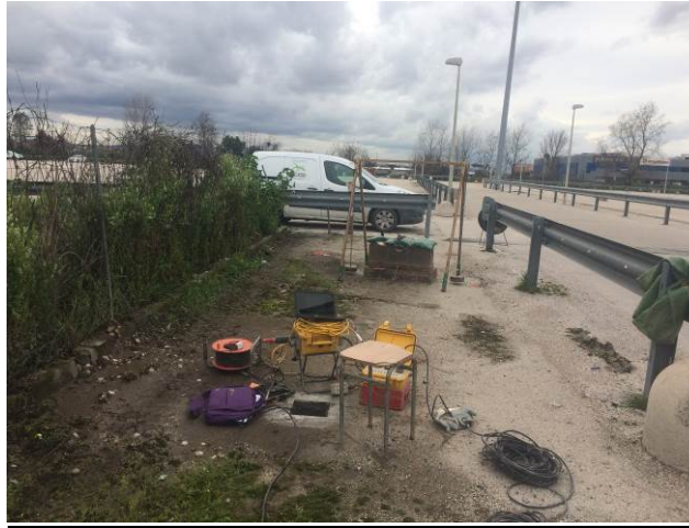
Figura 7.11 – Fase di esecuzione del carotaggio sismico down-hole.
