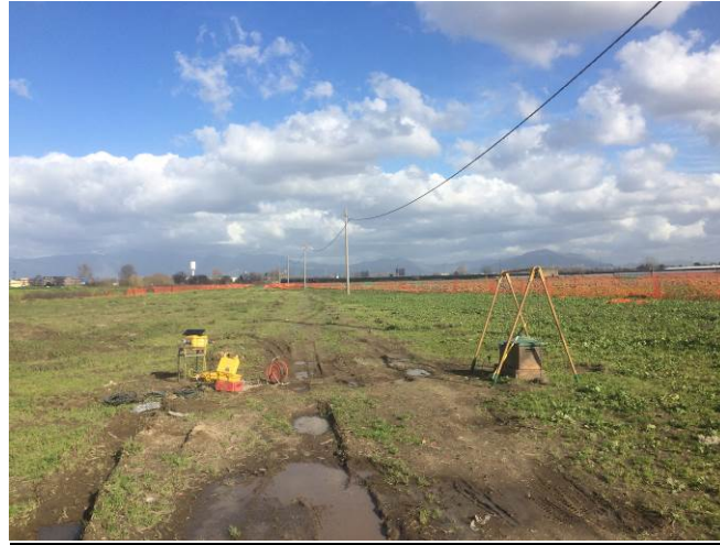
Figura 7.17 – Fase di esecuzione del carotaggio sismico down-hole.
