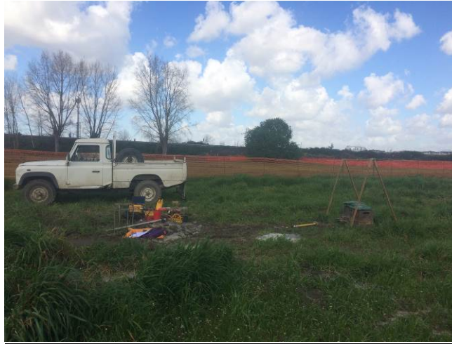
Figura 7.27 – Fase di esecuzione del carotaggio sismico down-hole.
