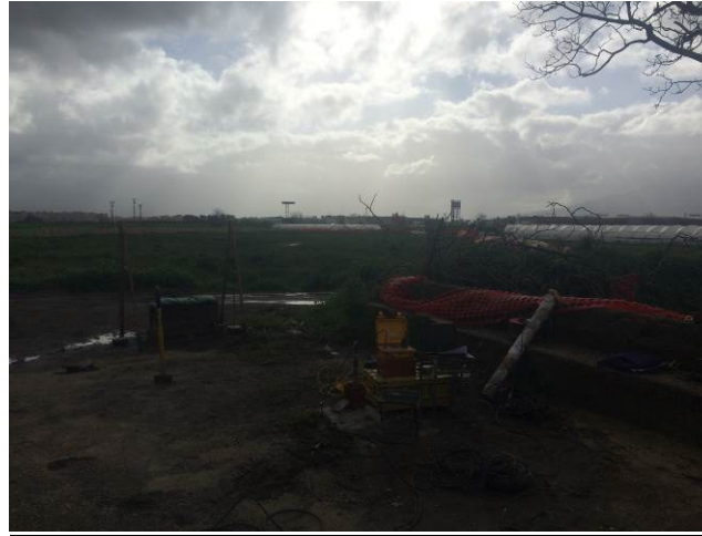
Figura 7.3 – Fase di esecuzione del carotaggio sismico down-hole.
