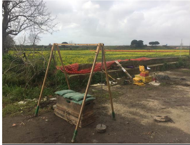
Figura 7.13 – Fase di esecuzione del carotaggio sismico down-hole.
