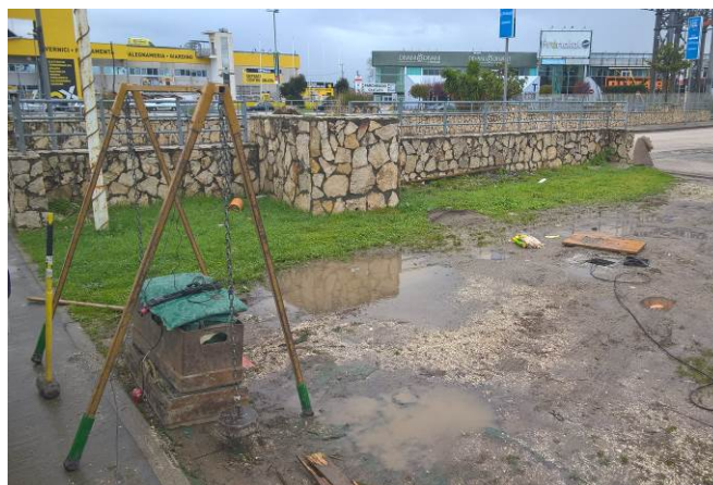
Figura 7.9 – Fase di esecuzione del carotaggio sismico down-hole.
