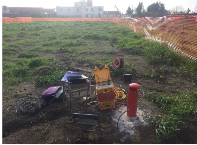
Figura 7.21 – Fase di esecuzione del carotaggio sismico down-hole.
