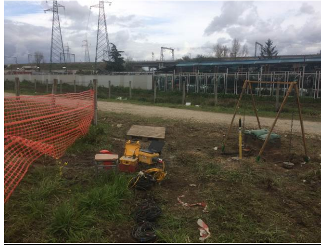
Figura 7.7 – Fase di esecuzione del carotaggio sismico down-hole.
