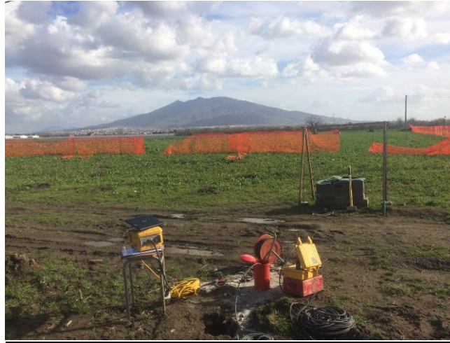
Figura 7.25 – Fase di esecuzione del carotaggio sismico down-hole.
