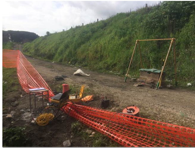
Figura 7.33 – Fase di esecuzione del carotaggio sismico down-hole.
