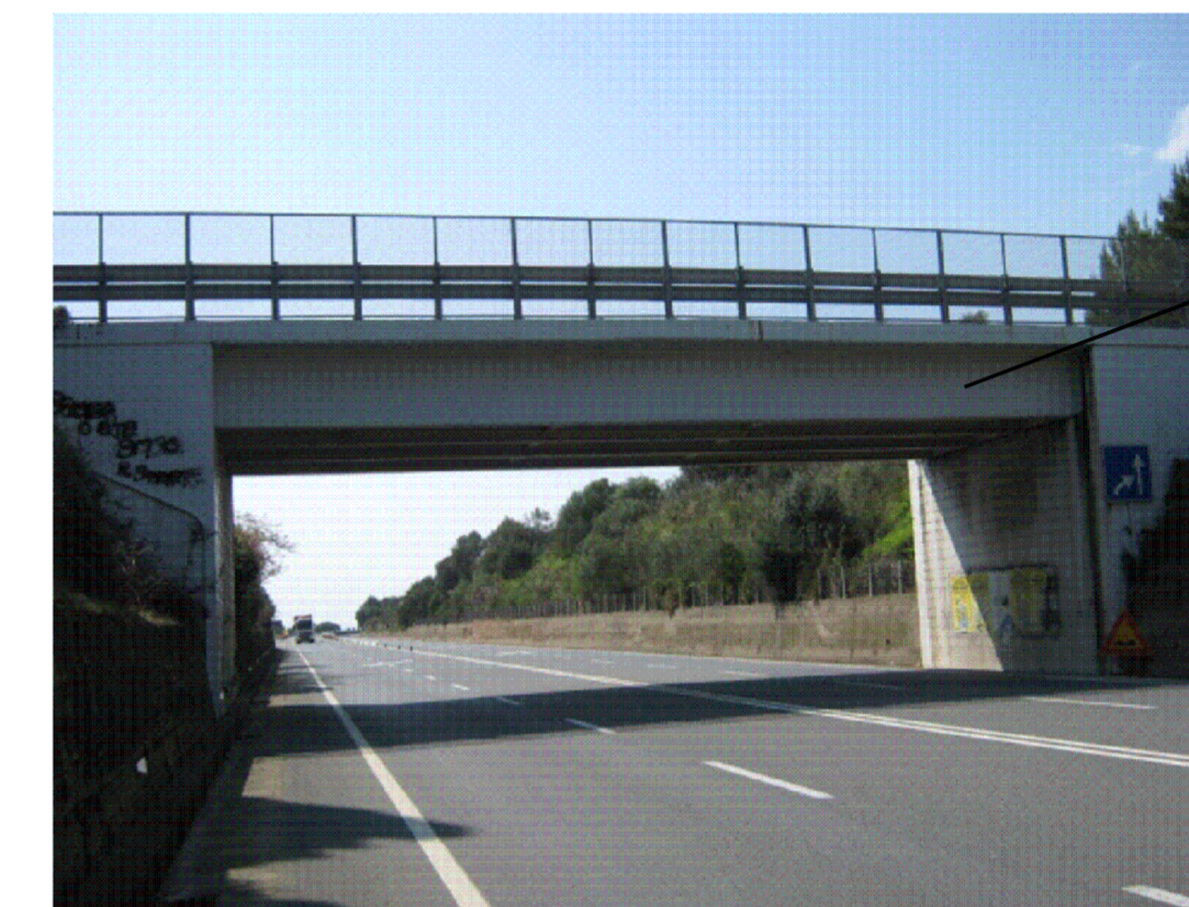
- Demolizione cavalcavia esistente
