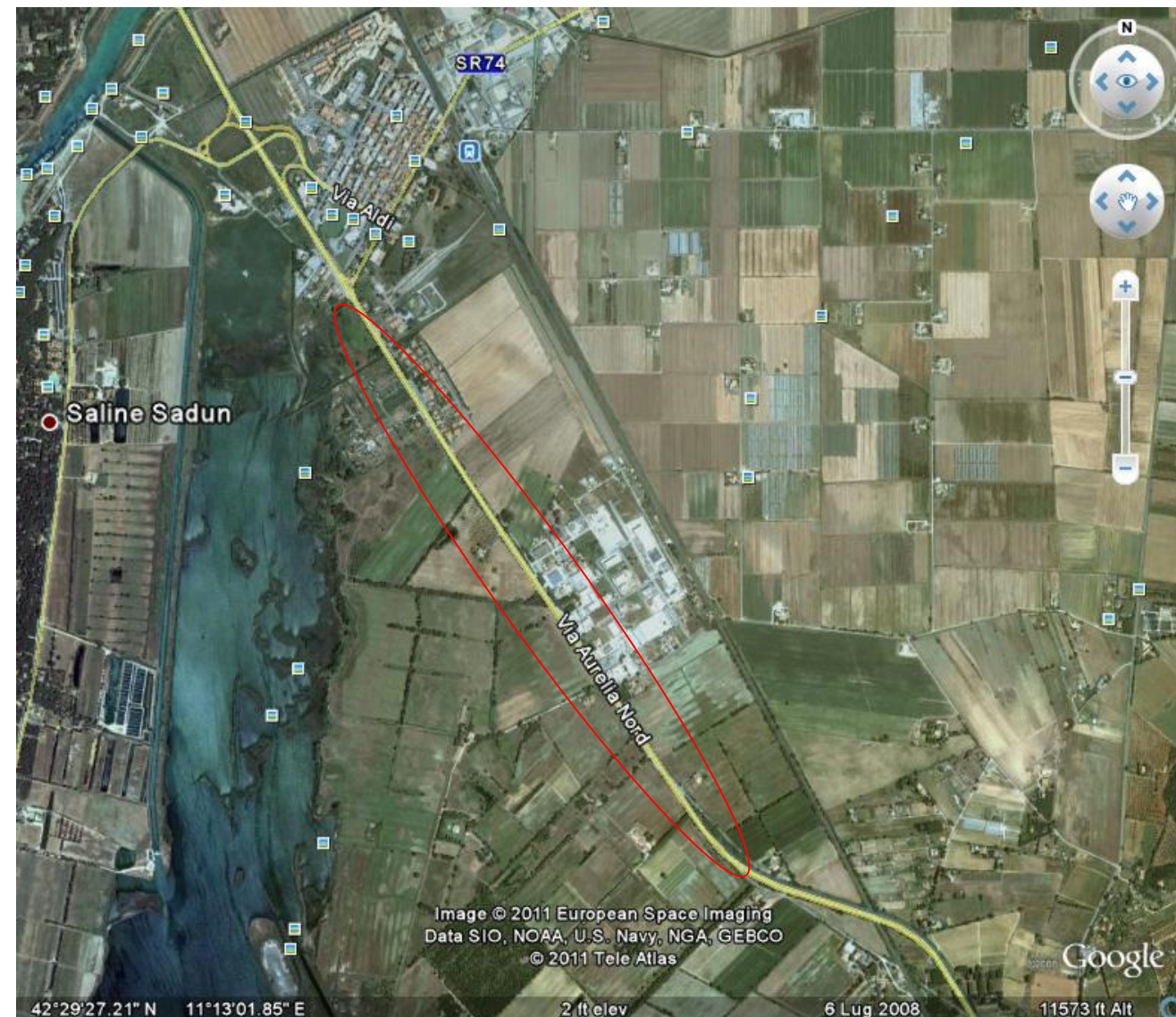
Figura 6.11 - L'area tra lo svincolo di Albinia e la progr. 13+500 in cui è presente sono presenti il SIC e la ZPS IT51A0026 "Laguna di Orbetello" (con l'ovale rosso è indicato il tratto in cui il tracciato interessa marginalmente il SIC e la ZPS)
