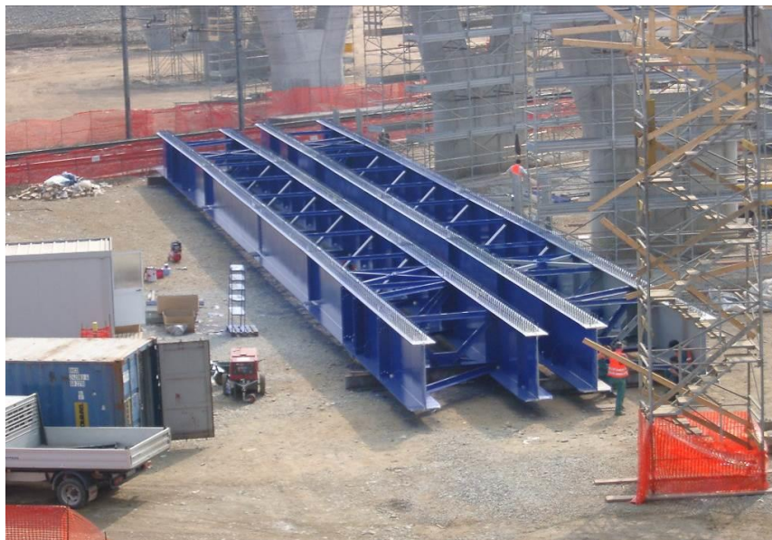
Alcuni esempi di pre-assemblaggio a terra
