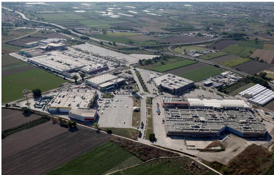
Area di sedime del viadotto ad archi tra le progr. 6+950 e 8+050 - Foto aerea da Nord-Ovest
