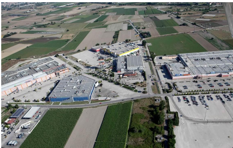
Area di sedime del viadotto ad archi tra le progr. 6+950 e 8+050 - Foto aerea da Sud
