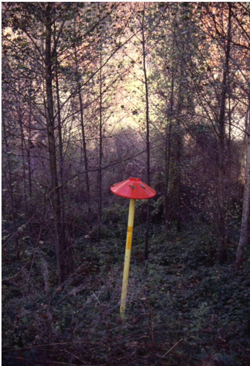
Foto 9/C: Metanodotto realizzato nel 1980: rivegetazione (naturale non sono stati eseguiti ripristini) totale del metanodotto, le paline sono totalmente nascosta dalla vegetazione.
