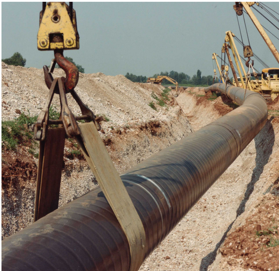
Foto 5.1/F: Posa della condotta
