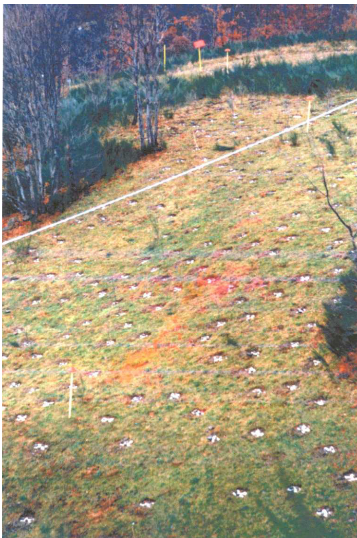
Foto 9/A: Ripristino vegetazionale eseguito nel 1997: la messa a dimora delle piante viene fatta su tutta la pista del metanodotto. Al termine del lavoro di messa a dimora vengono eseguite le cure colturali alle piantine ed il risarcimento delle fallanze.
