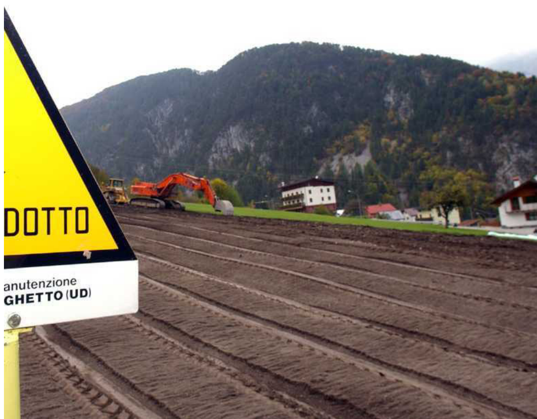
Foto 5.1/I: Ridistribuzione dello strato humico superficiale
