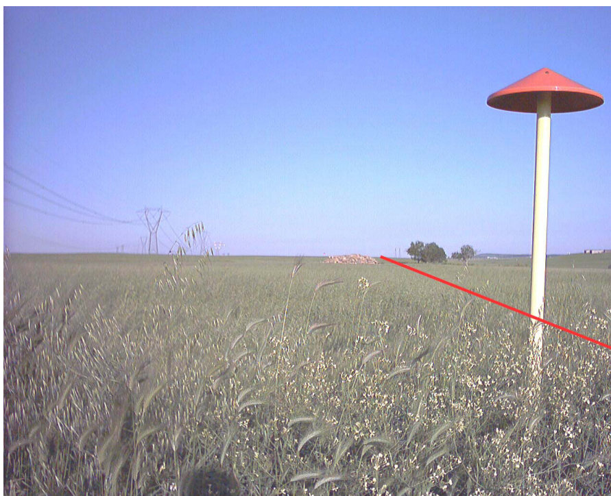
Foto 9/G: Il metanodotto "Dorsale per Taranto - Tratto Altamura - Taranto DN 350 (14)" in località "Fontana Imperatore", in Comune di Laterza
