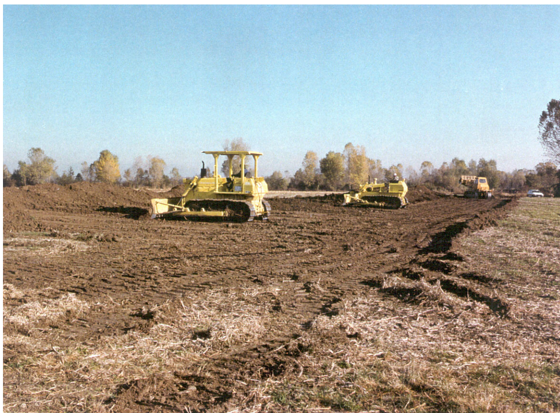
Foto 5.1/B: Apertura dell'area di passaggio
