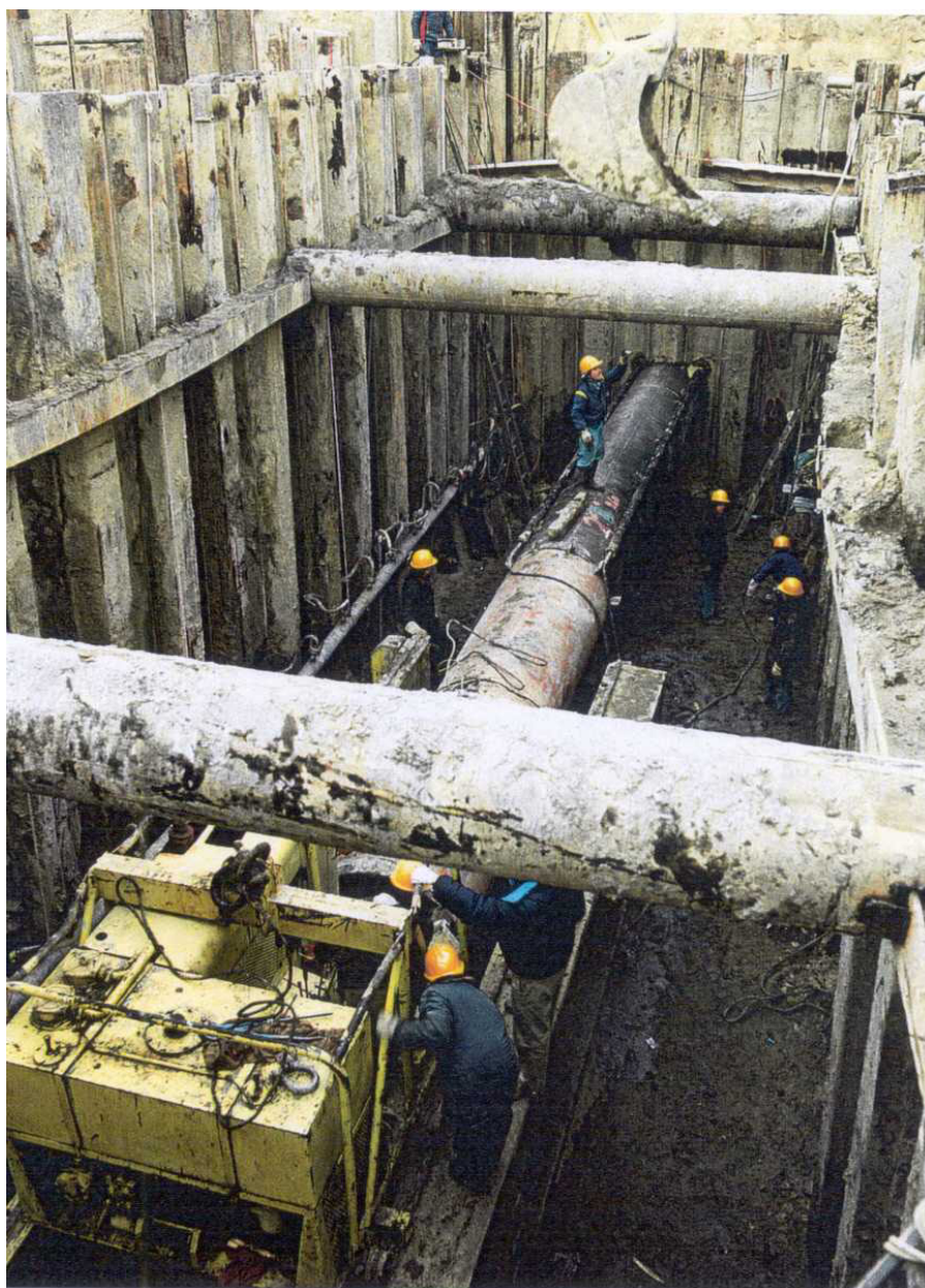
Foto 5.1/L: Trivellazione con spingitubo
