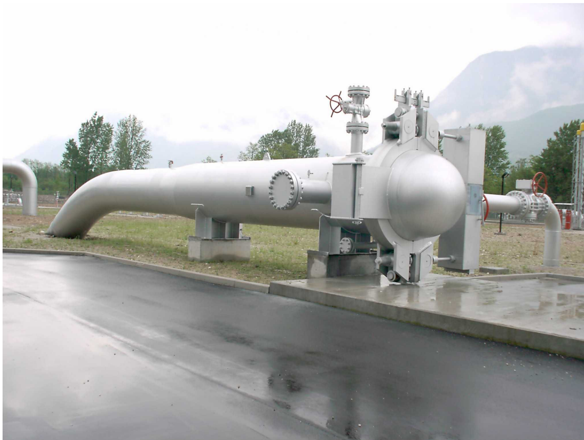
Foto 4.2/A: Punto di lancio e ricevimento pig
