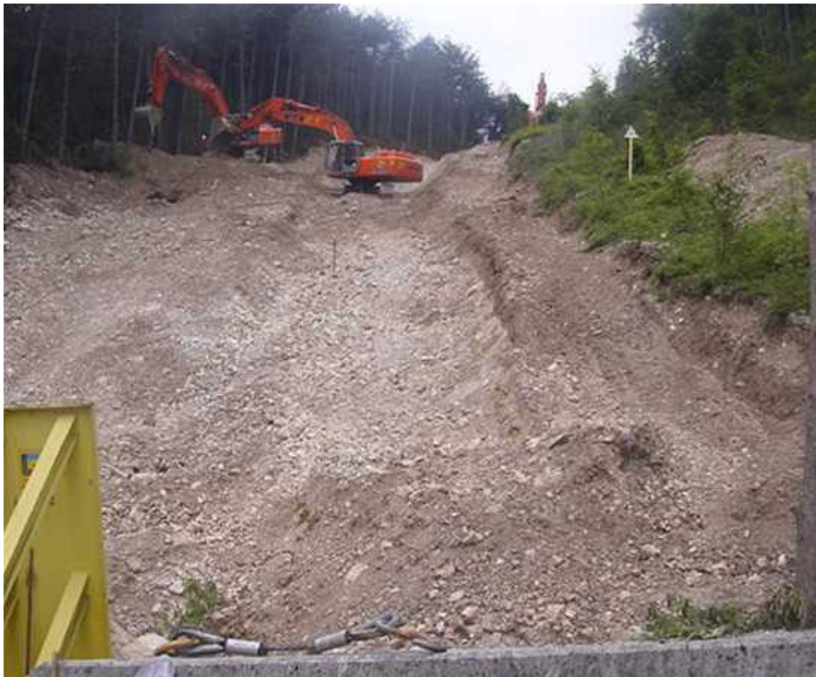
Foto 5.1/E: Scavo della trincea
