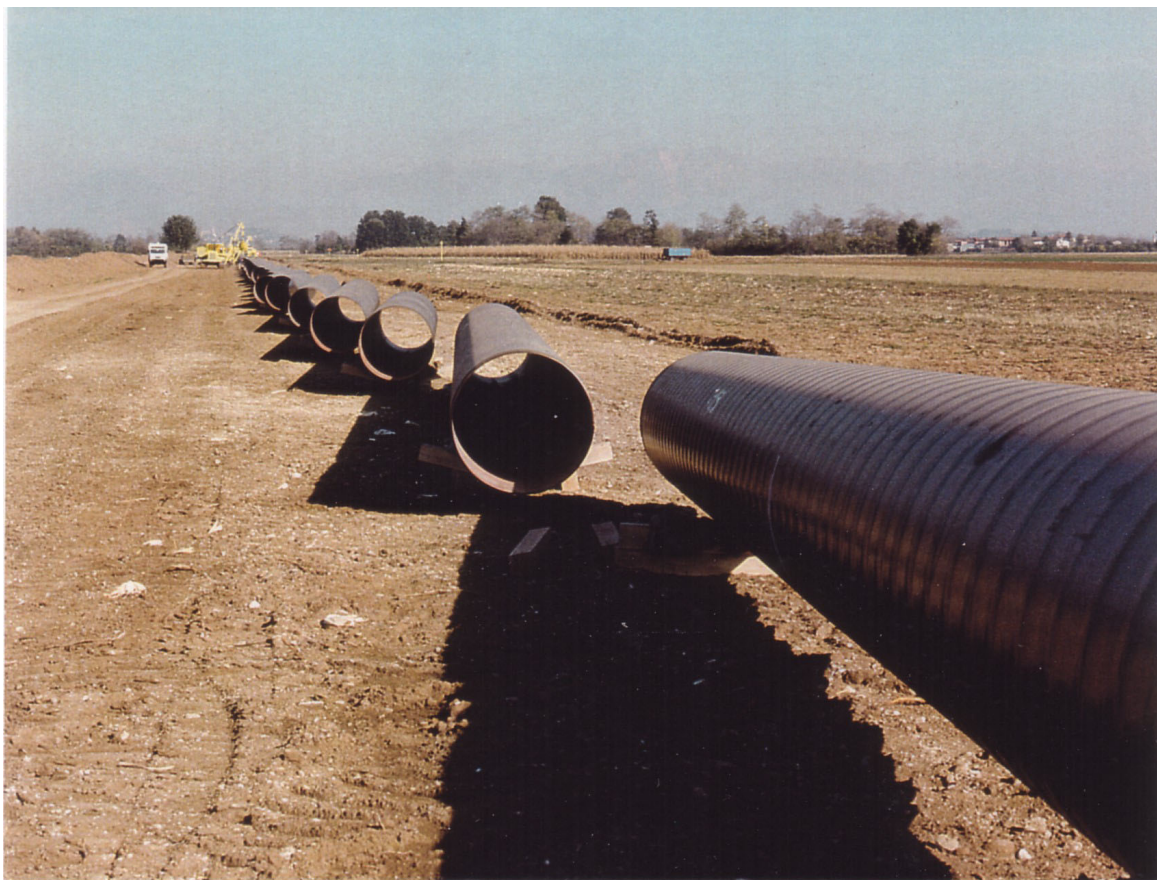
Foto 5.1/C: Sfilamento tubazioni
