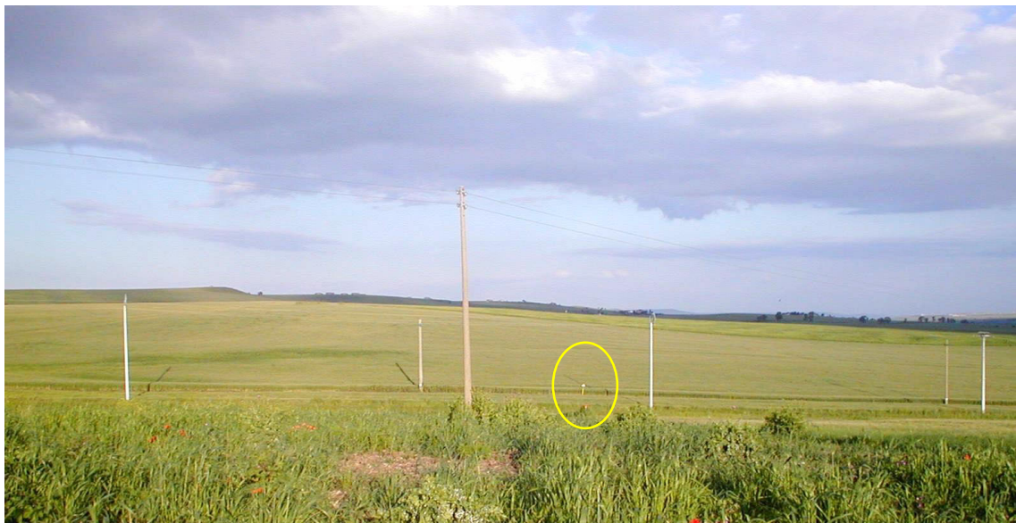
Foto 9/M: Il metanodotto "Dorsale per Taranto - Tratto Candela - Altamura DN 400 (16") in prossimità di Masseria la Ginestra, in Comune di Spinazzola (l'ovale giallo evidenzia il cartello segnalatore)
