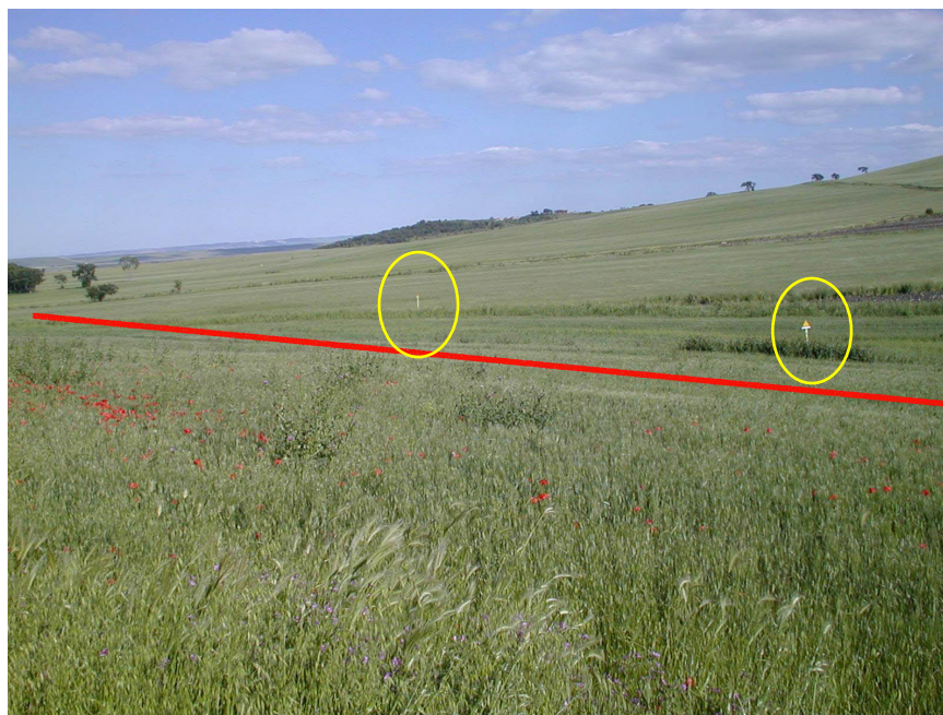
Foto 9/R: Il metanodotto "Dorsale per Taranto - Tratto Biccari - Candela DN 450 (18") in località "Mezzanelle", in Comune di Bovino (l'ovale giallo evidenzia il cartello segnalatore)
