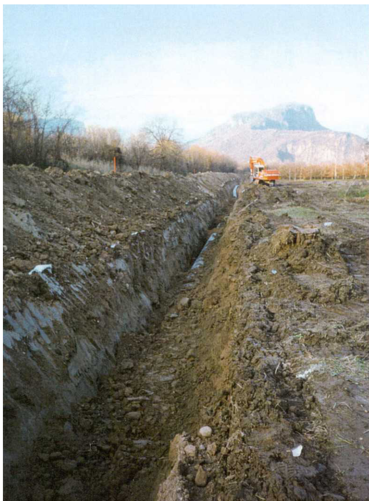
Foto 5.1/H: Rinterro della condotta
