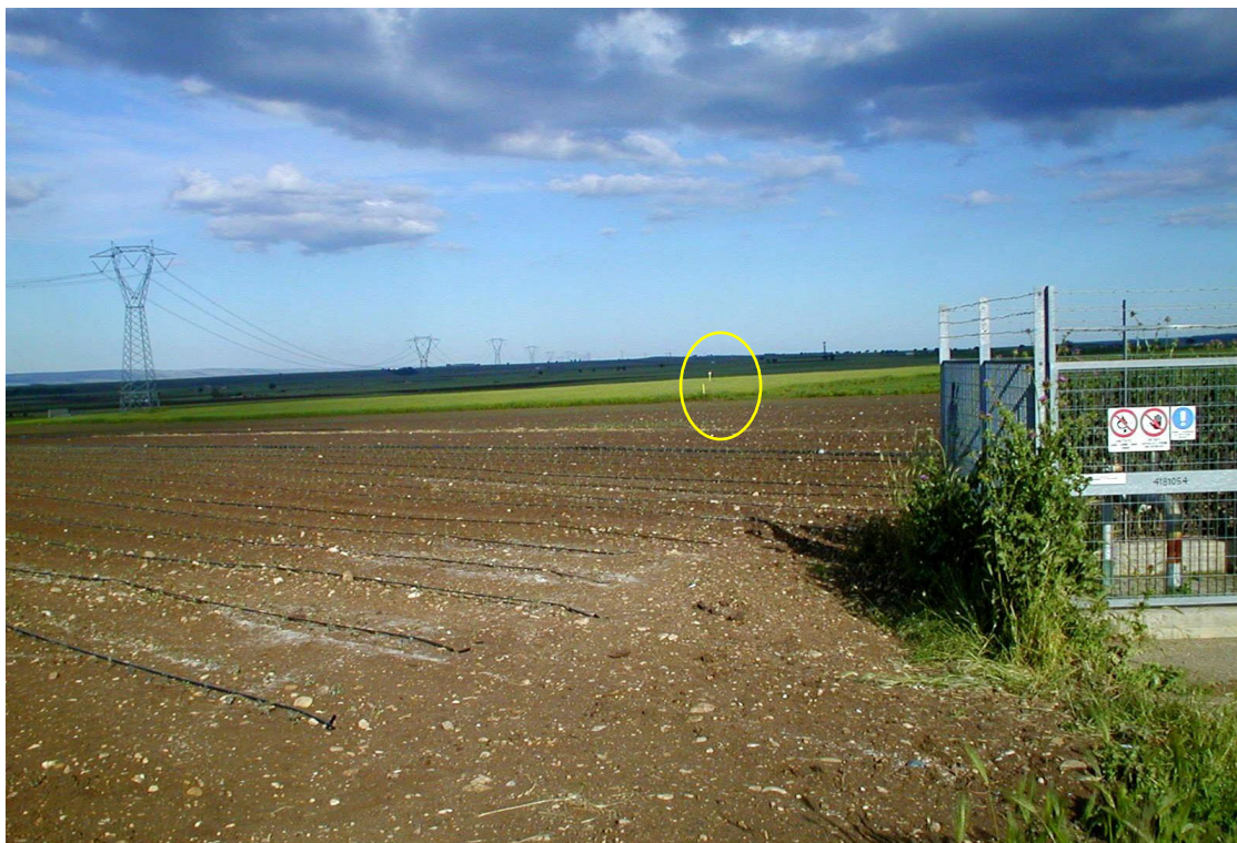
Foto 9/N: Il metanodotto "Dorsale per Taranto - Tratto Candela - Altamura DN 400 (16") in località "Messerò", in Comune di Venosa (l'ovale giallo evidenzia il cartello segnalatore)
