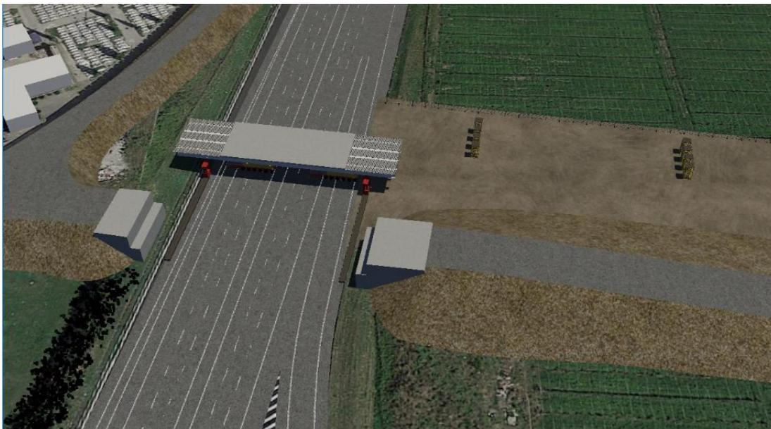
Figura 8 Fase di traslazione su carrelloni motorizzati
