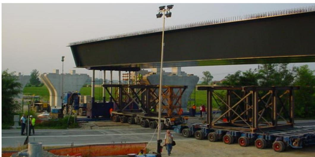
Figura 2 Esempio di varo su carrelloni e sollevatori idraulici
