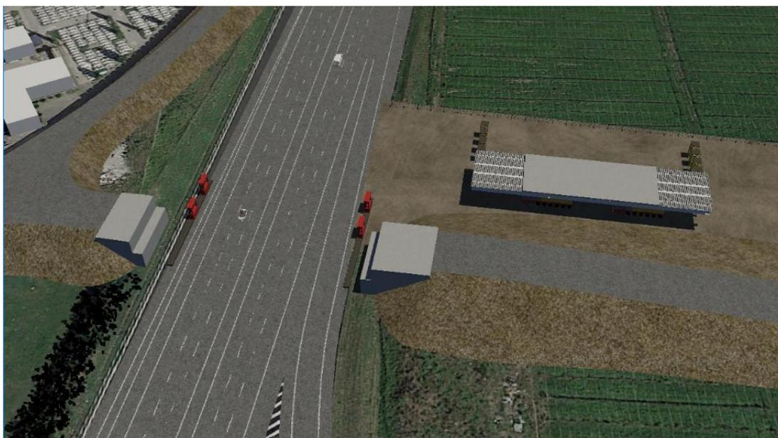
Figura 7 Fase di traslazione su carrelloni motorizzati
