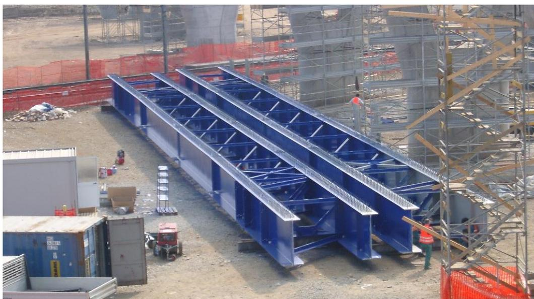
Figura 1 Esempio di montaggio a terra
