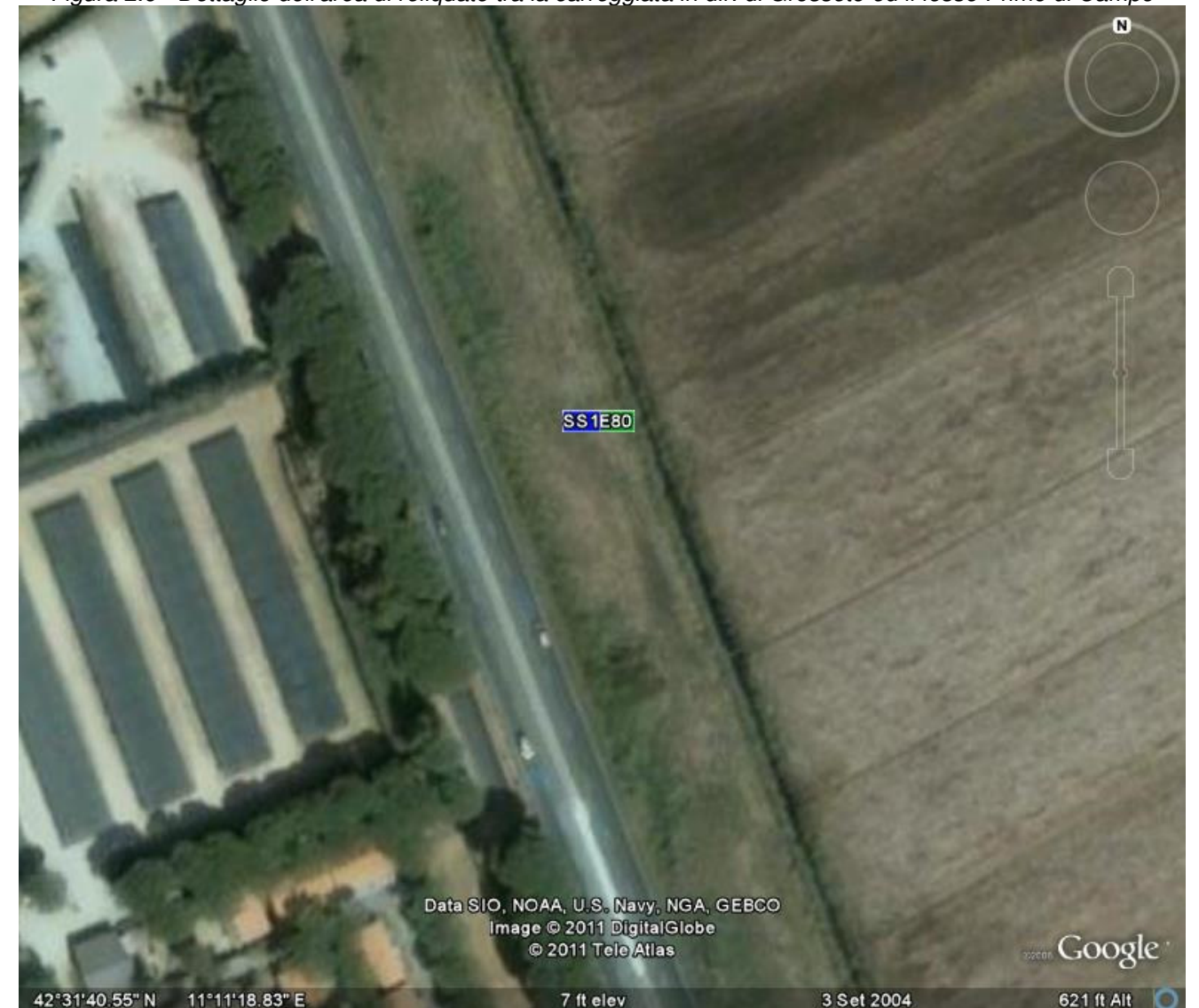
Figura 2.6 - Dettaglio dell'area di reliquato tra la carreggiata in dir. di Grosseto ed il fosso Primo di Campo
