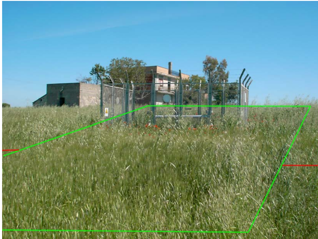
Foto A4: Matera - PIL n. 4 in località Masseria Punzi
