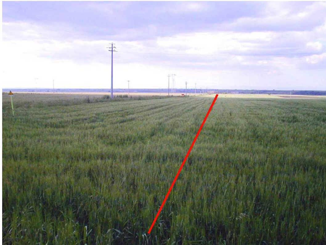
Foto 45: Montemilone - Tratto presso la Sterpara.
