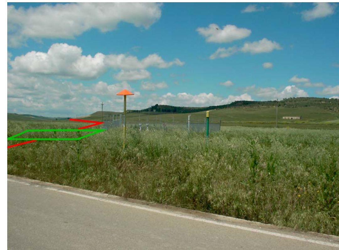
Foto A11: Gravina di P. - PIL n. 11 in località Masseria Nardone
