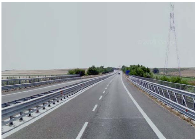
Figura 5: Viadotto "Ponte rotto" Km 114+700
