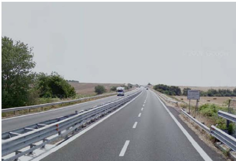
Figura 4: Viadotto "Tafone" Km 116+500
