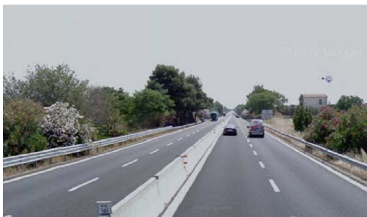
Figura 2: L'infrastruttura attuale in corrispondenza del Km 12+800
