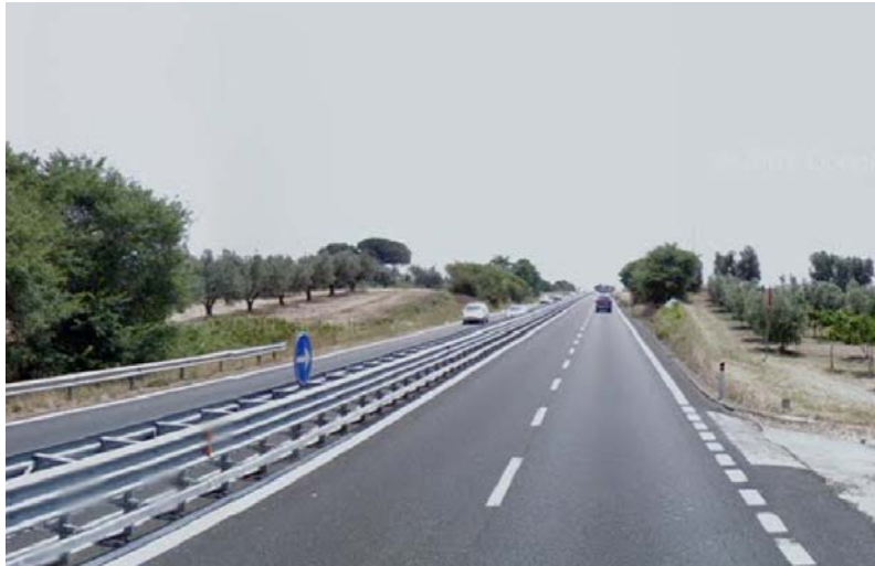
Figura 3: Intersezioni a raso lungo l'infrastruttura esistente. Km 117+800
