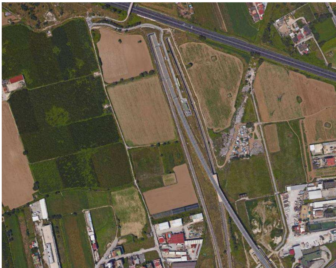
Vista aerea dell'area in cui si inserisce il cantiere: sono visibili i manufatti della linea AV e del collegamento Nord-Sud, oltre che l'autostrada A16 (ortofoto da Google Earth).
