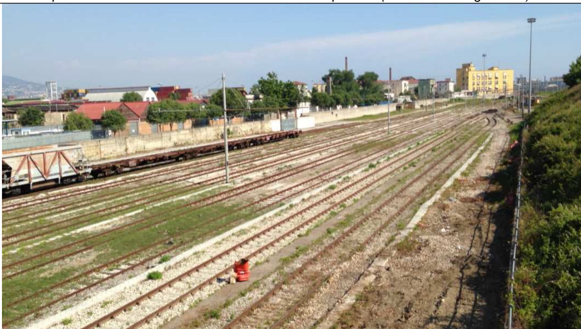
Vista dell'area destinata al cantiere dagli impianti ferroviari soprastanti dell'IDP di Napoli.
