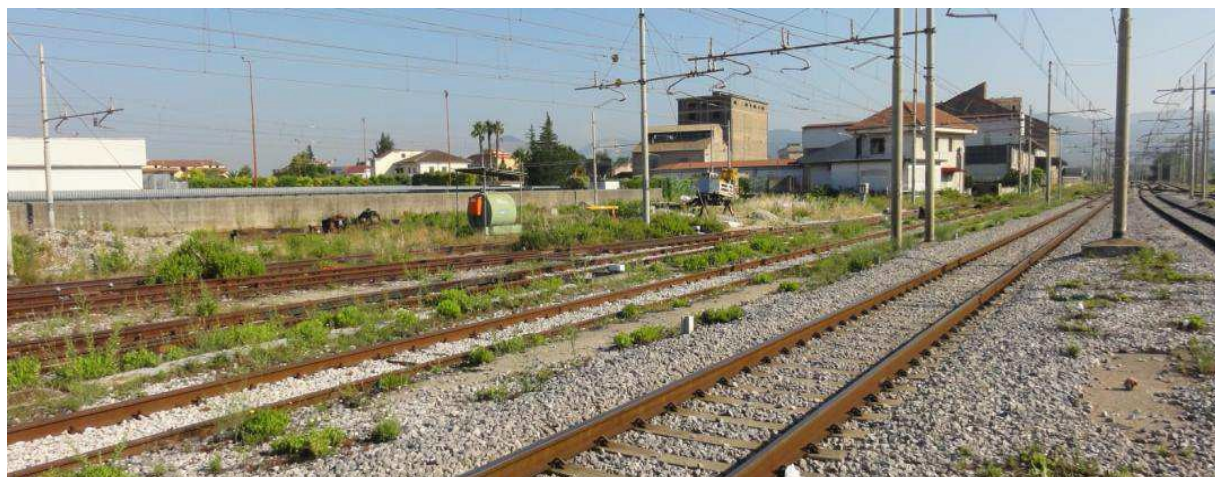
Area con tranchini lato nord-ovest
