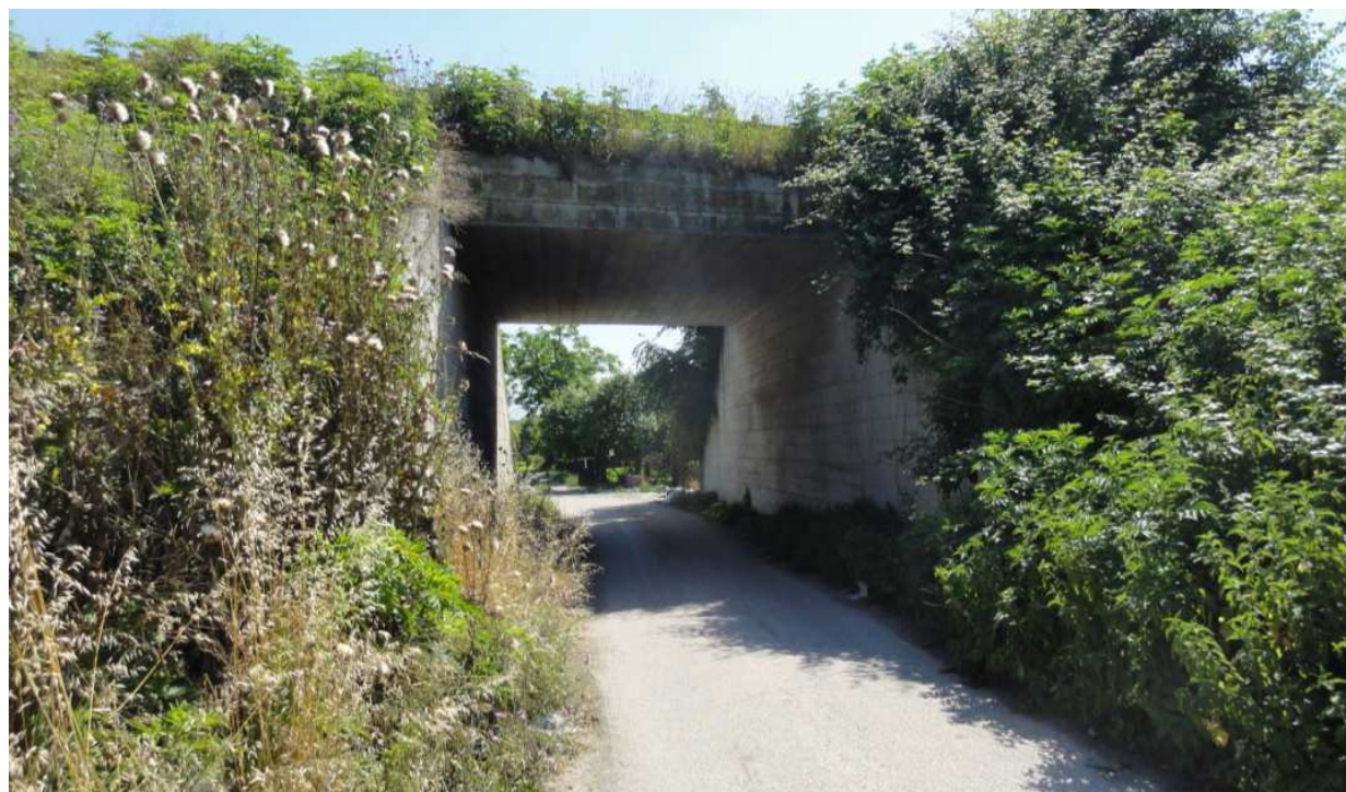
Sottopasso sulla strada vicinale di accesso all'area di deposito terre.
