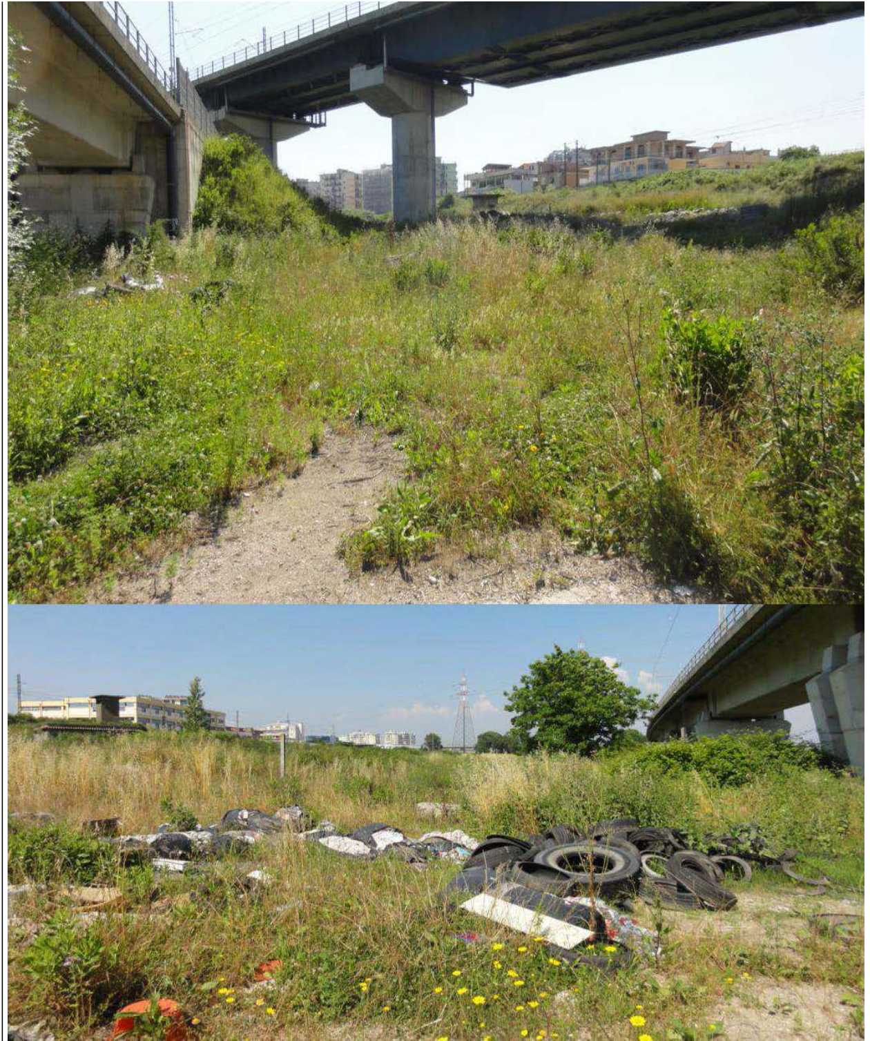
Viste dell'area tecnica sovrastata dal viadotto AV.
