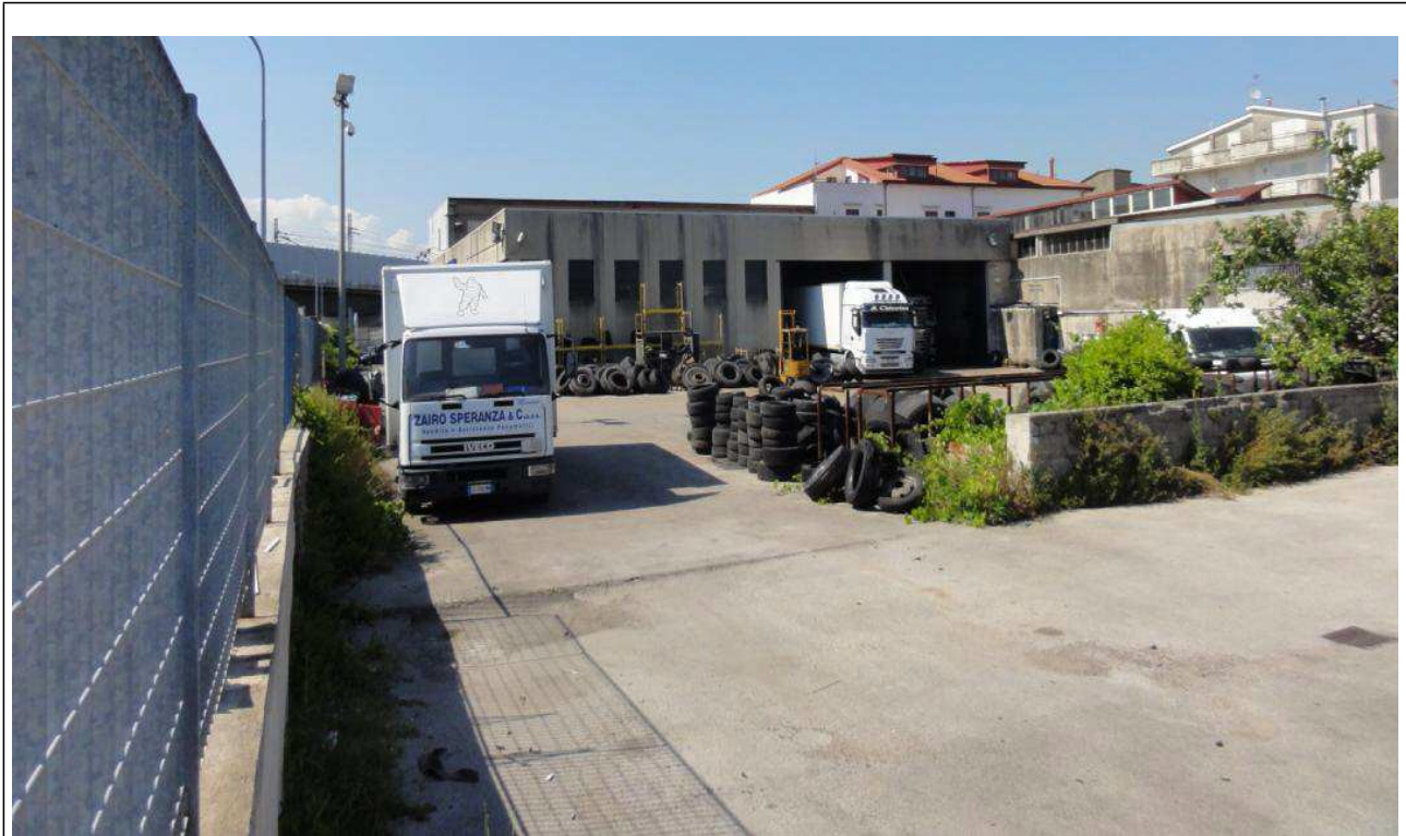
Fabbricati oggetto di demolizione, sul cui sedime verrà posta l'area tecnica. Vista lato linea ferroviaria.
