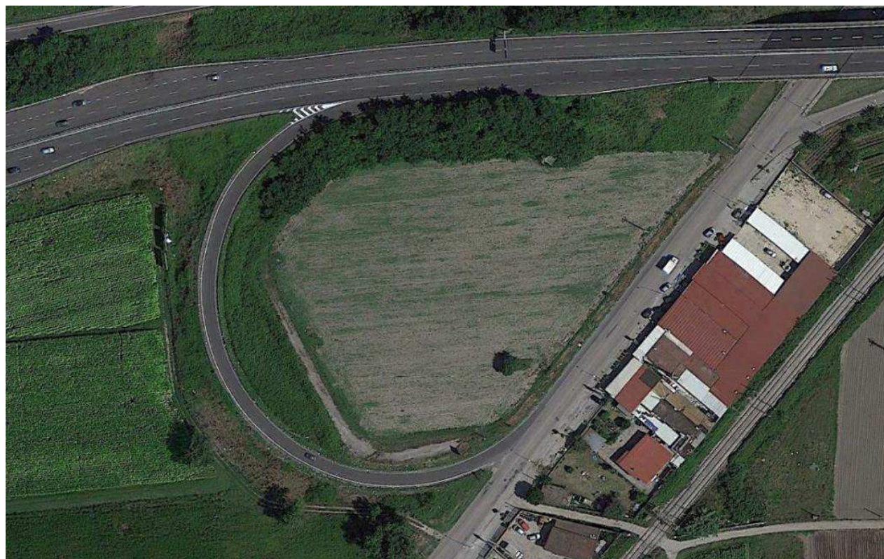
Vista aerea dell'area dello svincolo in cui si inserisce il cantiere, tra l'Asse Mediano, in alto, e via Benevento, a destra (ortofoto da Google Earth).
