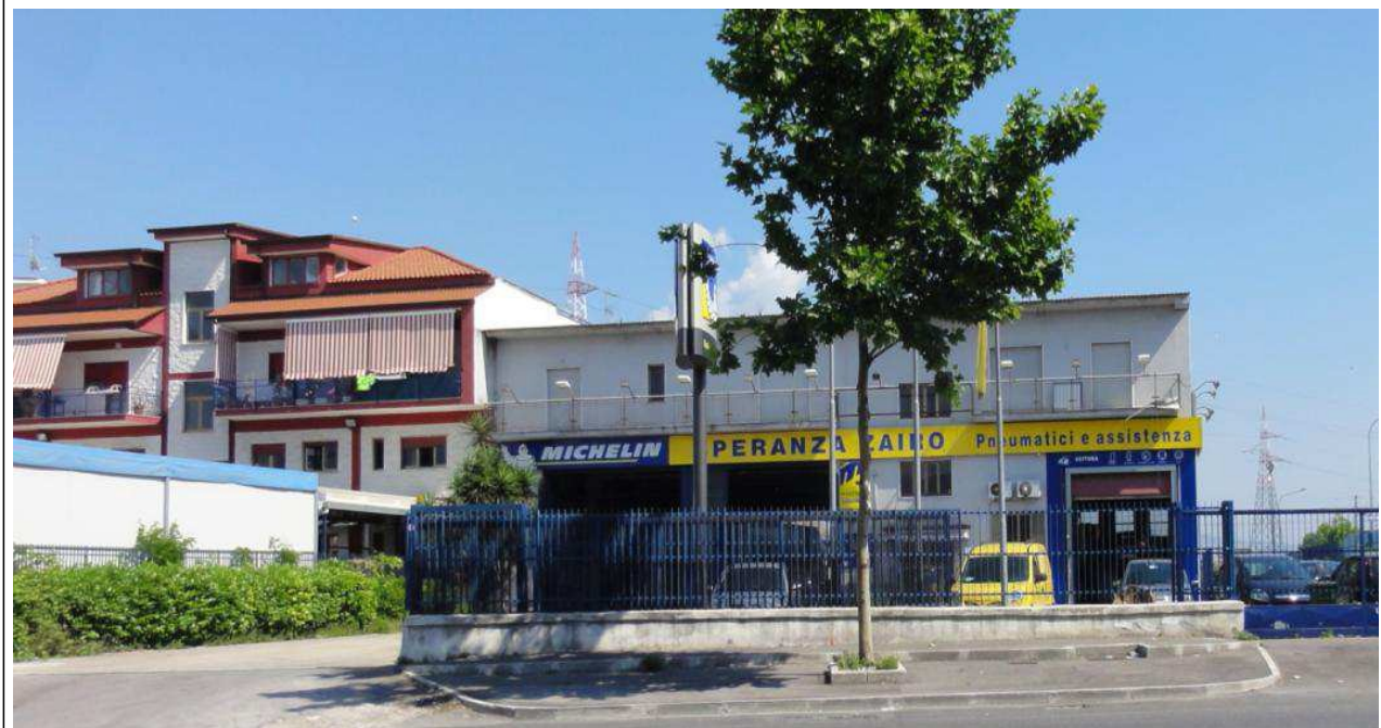
Fabbricati oggetto di demolizione sul cui sedime verrà posta l'area tecnica. Vista dalla via Nazionale delle Puglie,
