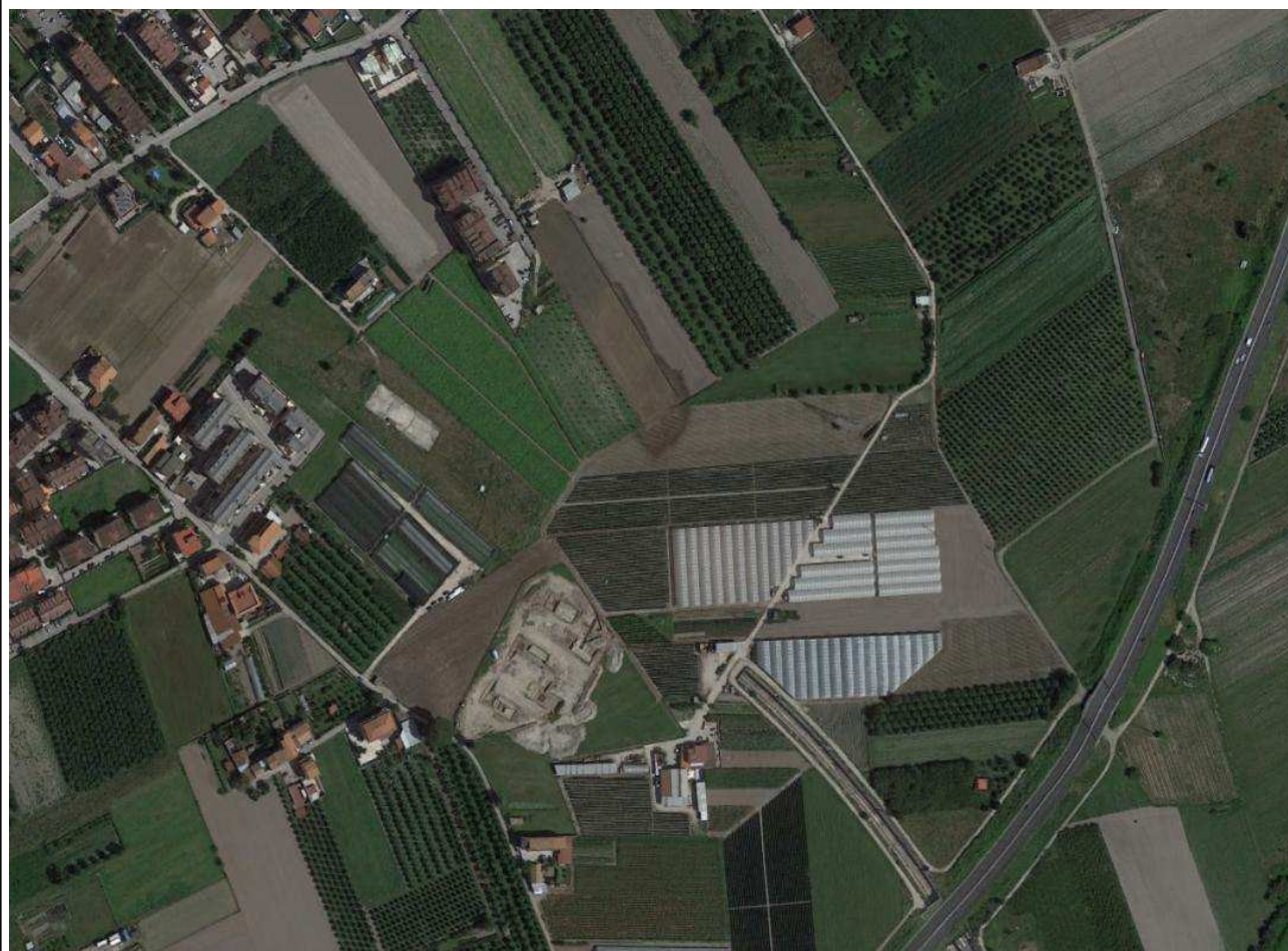
Vista aerea dell'area destinata al cantiere operativo; a sud è visibile il tracciato della linea Circumvesuviana che attraversa l'area in sotterraneo (ortofoto da Google Earth).
