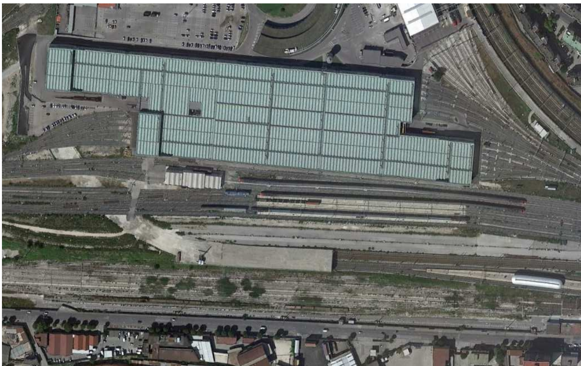
Vista aerea della porzione nord dell'area di scalo in cui si inserisce il cantiere; in basso a destra si nota la pensilina della fermata Traccia della linea metropolitana (ortofoto da Google Earth)
