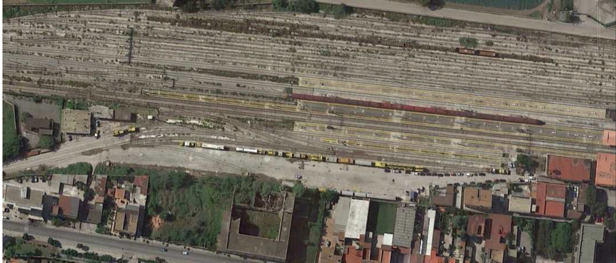
Vista aerea del piazzale lato sud, con l'area incolta ad esso contigua a lato dell'area ferroviaria (ortofoto da Google Earth).
