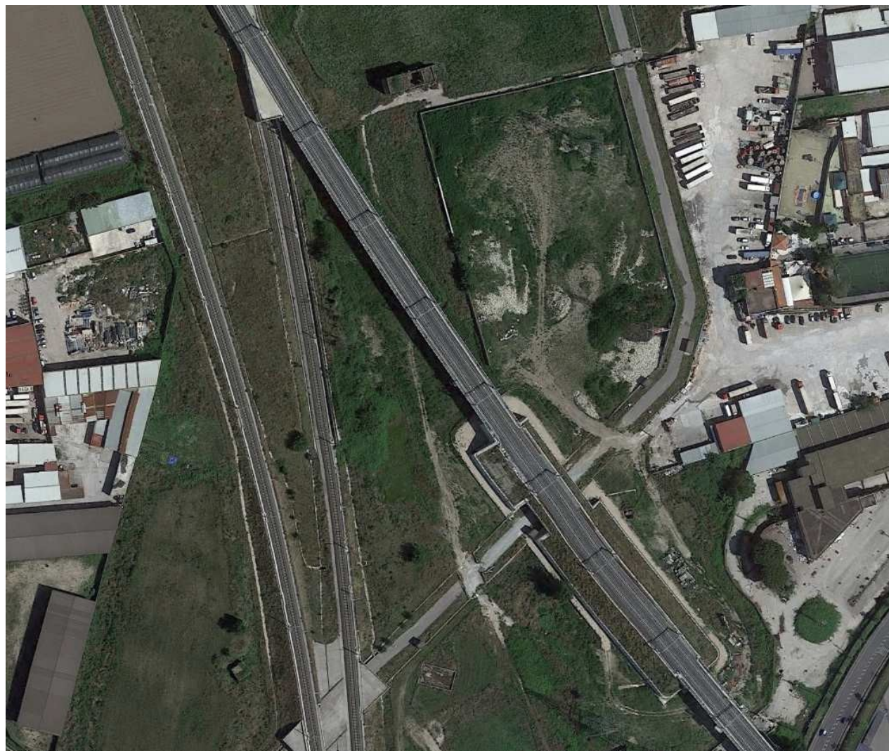
Vista aerea dell'area destinata al cantiere operativo , attraversata dal viadotto del collegamento Nord-Sud (ortofoto da Google Earth).
