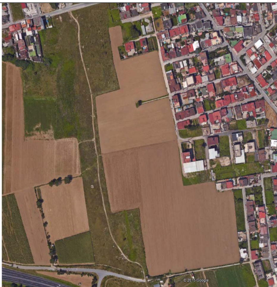
Vista aerea dell'area in cui si inserisce il cantiere, già interessata dalla cantierizzazione della linea AV (ortofoto da Google Earth).
