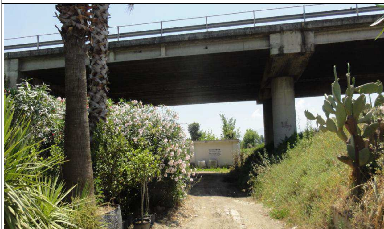
Passaggio sotto l'Asse Mediano per l'accesso all'area del cantiere base.
