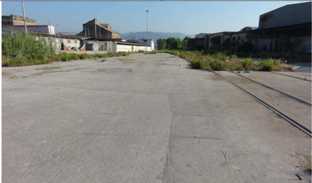
Piazzale lato nord-est: vista verso nord.
