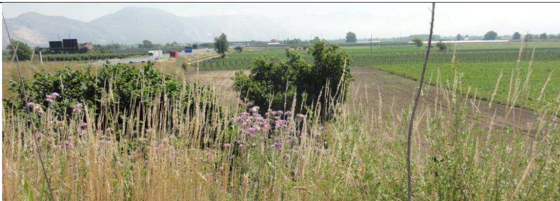
Vista dell'area tecnica dalla rampa del cavalcavia sulla SS 7bis.
