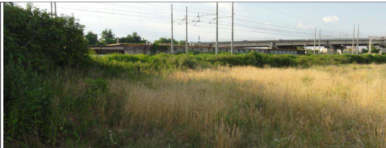
Vista dell'area tecnica; sullo sfondo si intravede l'Asse Mediano.
