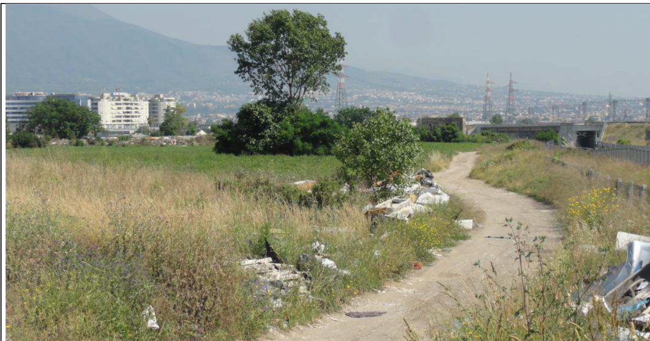
Vista dell'area di stoccaggio dall'estremità settentrionale (lato autostrada A16). A destra si nota la sede ferroviaria esistente, in trincea prima dell'imbocco della galleria artificiale.
