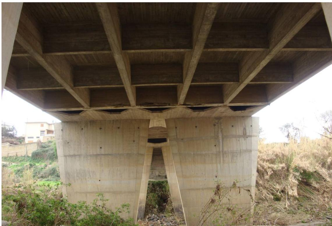
*Foto 6 – Vista intradosso – campata con travata tamponone*
