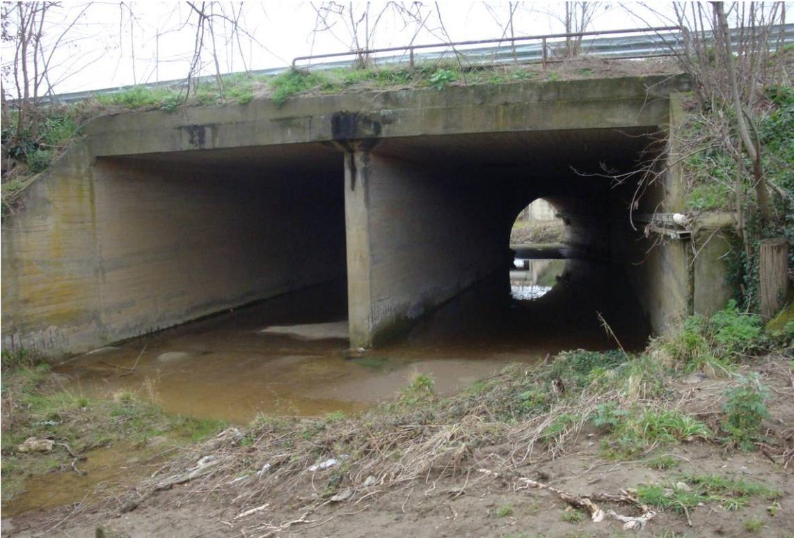
*Foto 1 – Vista laterale – struttura in allargamento in c.a.*
