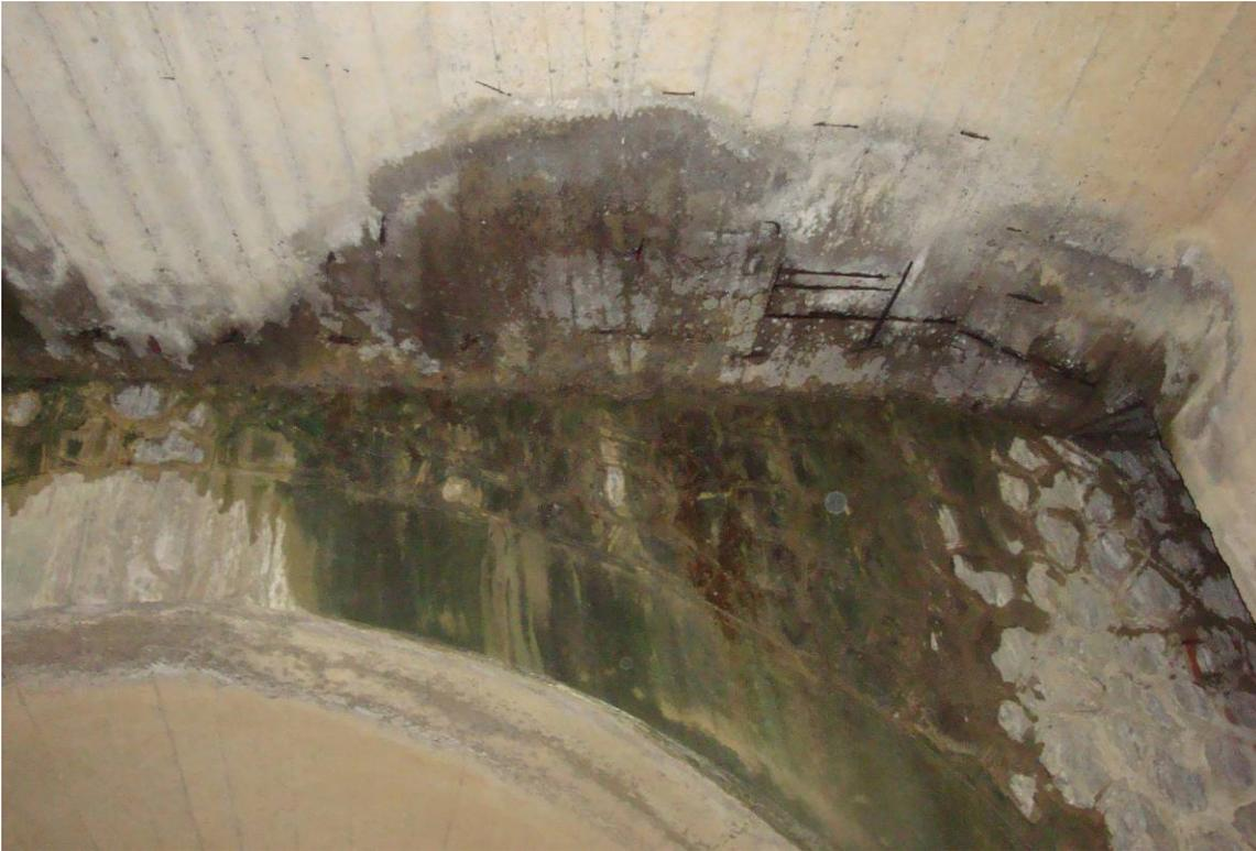
*Foto 7 – Particolare del giunto tra muro di timpano della volta in cls.e solettone in c.a.*
