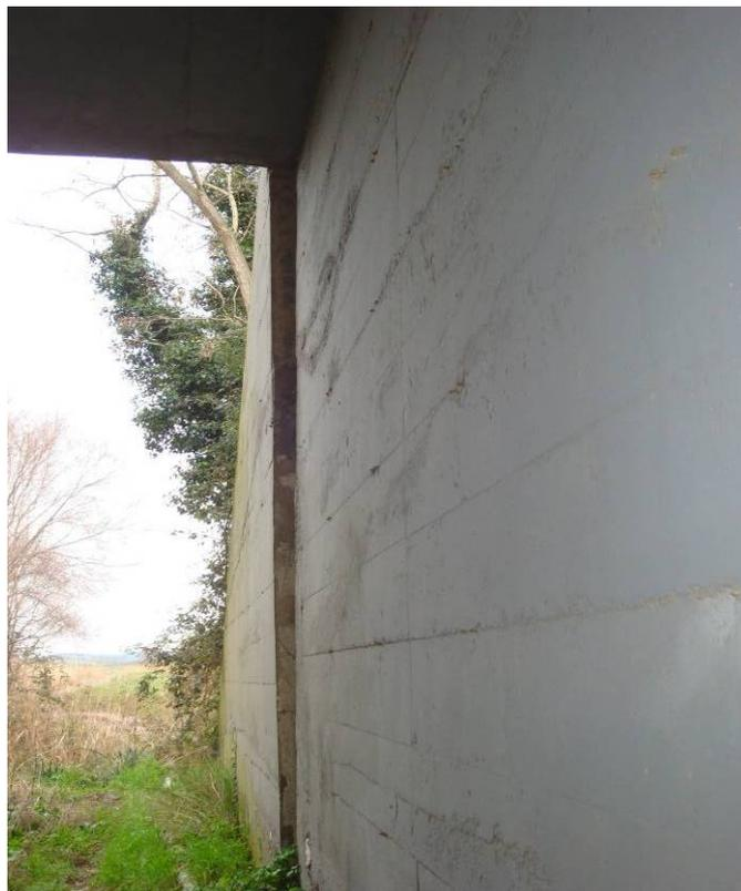
*Foto 4 – Particolare del giunto tra spalla e muro d'ala*
