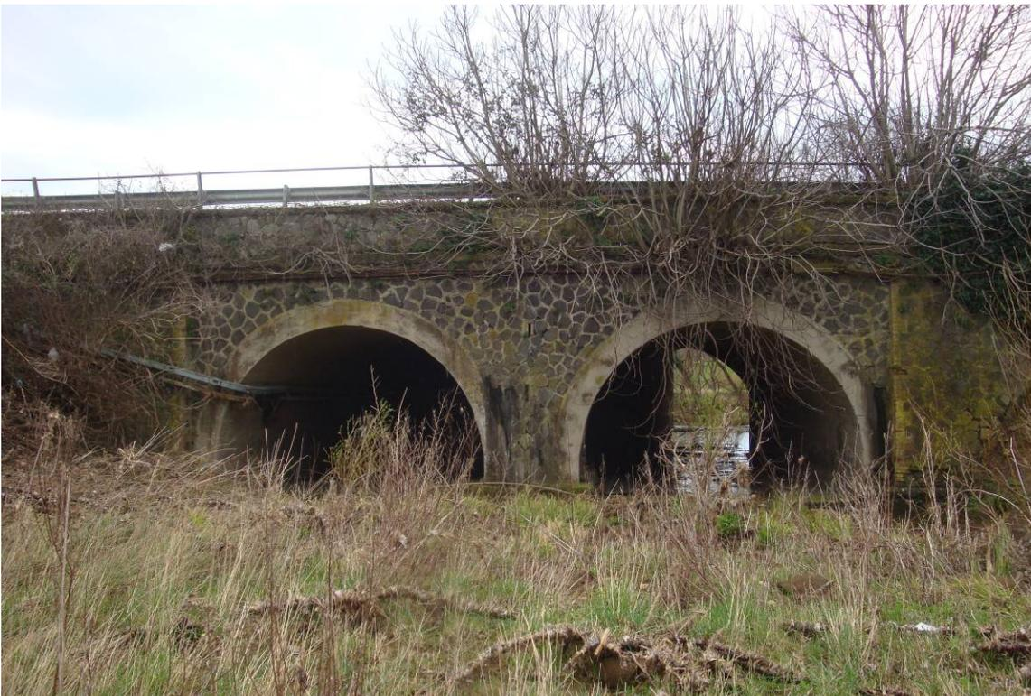
*Foto 2 – Vista laterale – struttura originaria ad arco*
