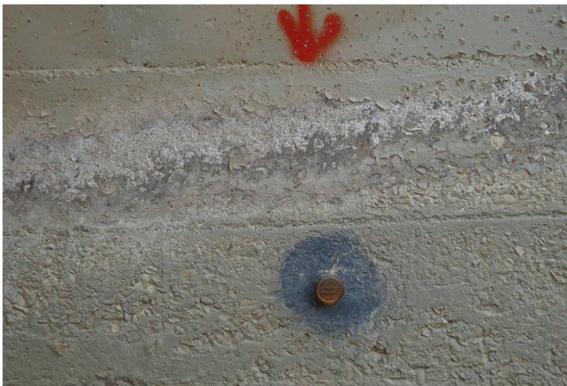
*Foto 4 – Caposaldo di livellazione IGM ubicato sulla spalla*
