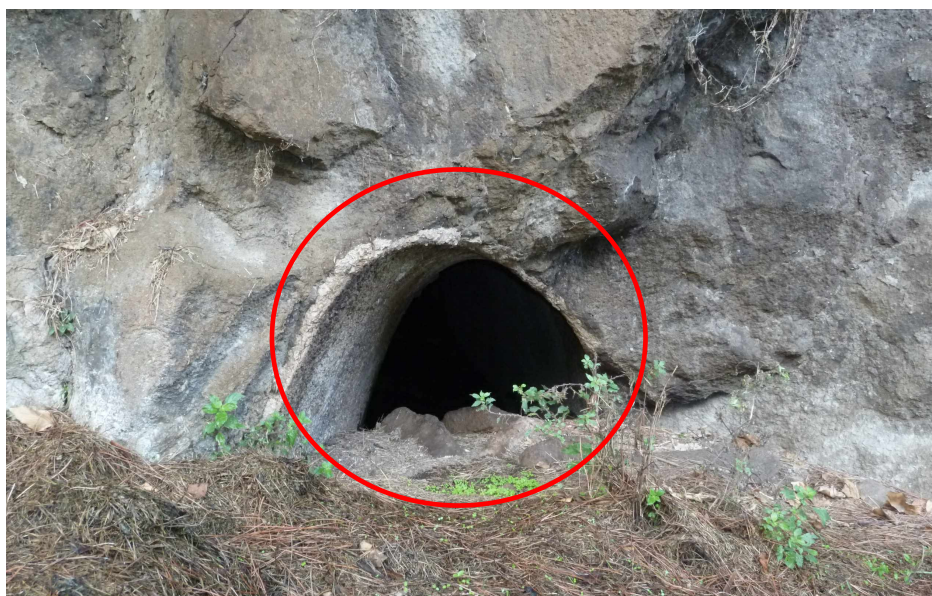
Foto 8 – Il cunicolo al piede della rupe est della torre
