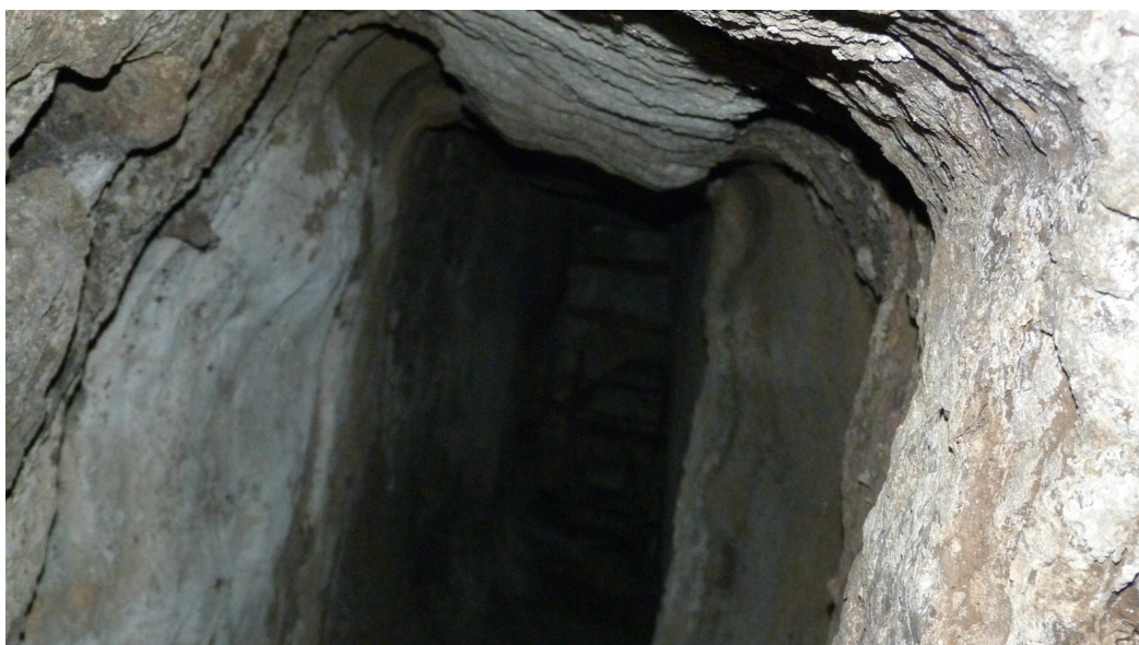
Foto 4 - Il condotto di forma rettangolare che collega la galleria con l'esterno tramite una botola
