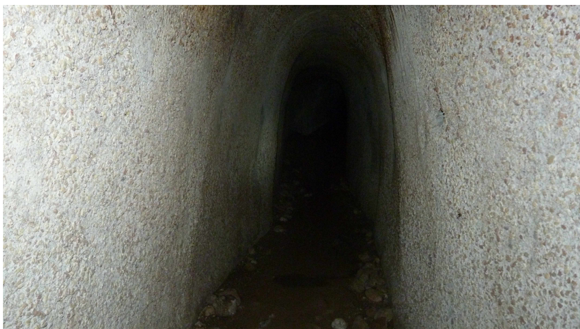
Foto 18 – La prosecuzione del cunicolo che si dirama dalla destra della cavità C2
