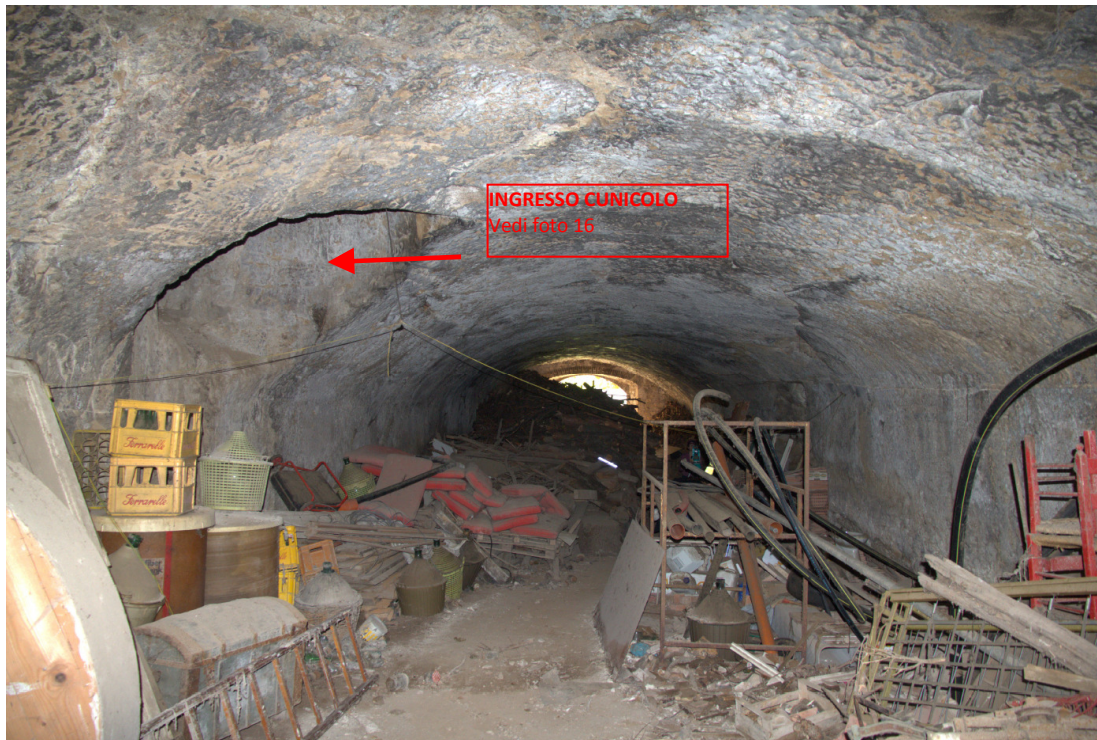
Foto 15 – L'interno della cavità C2 e l'ingresso del cunicolo laterale
