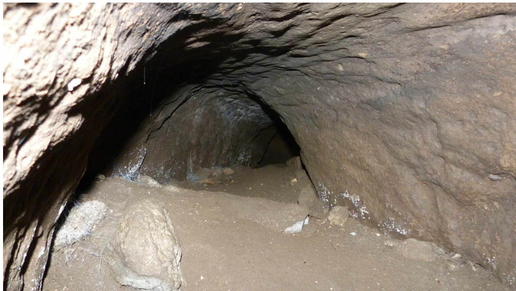
Foto 6 – Uno dei condotti ubicati al piede della galleria
