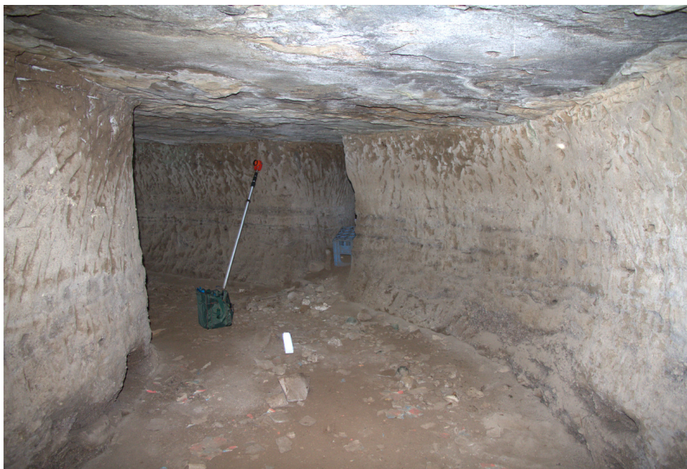
Foto 21 – L'interno della cavità C3 (fotografia presa dall'interno verso l'esterno)
