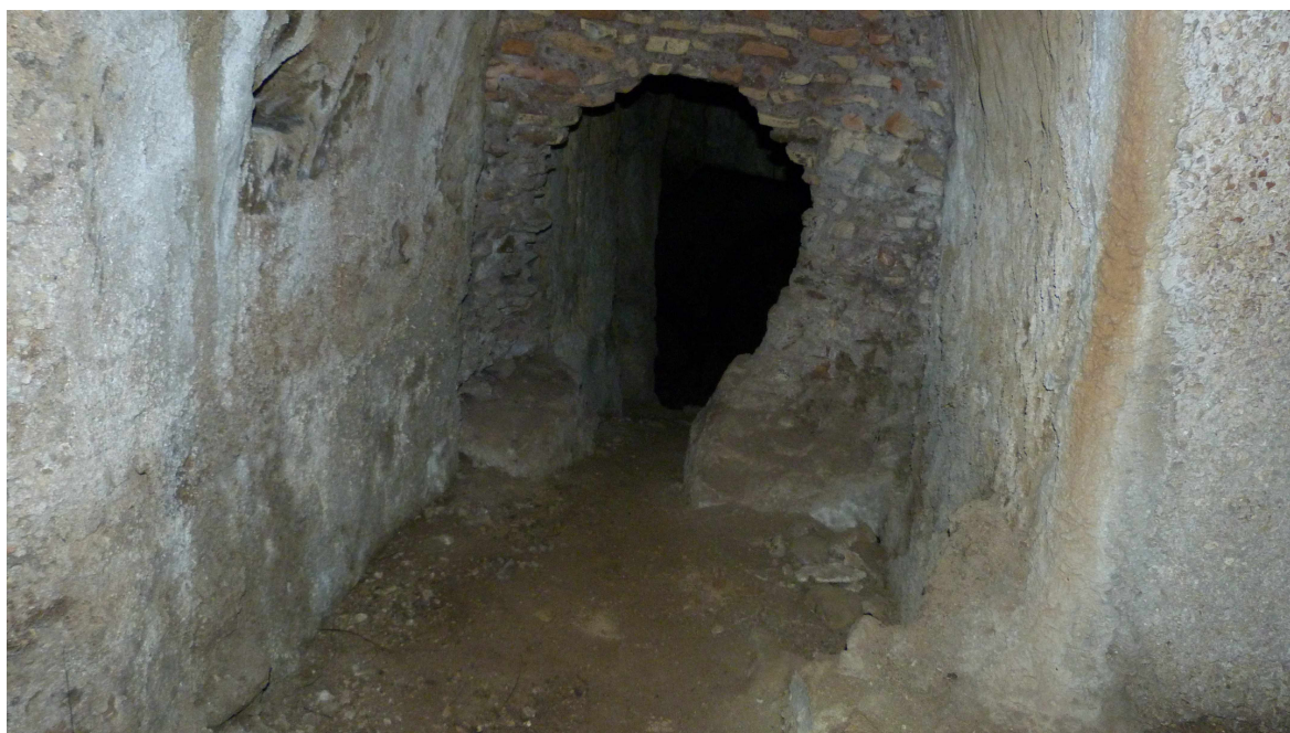
Foto 17 - Il setto in muratura all'interno del cunicolo che si dirama dalla destra della cavità C2
