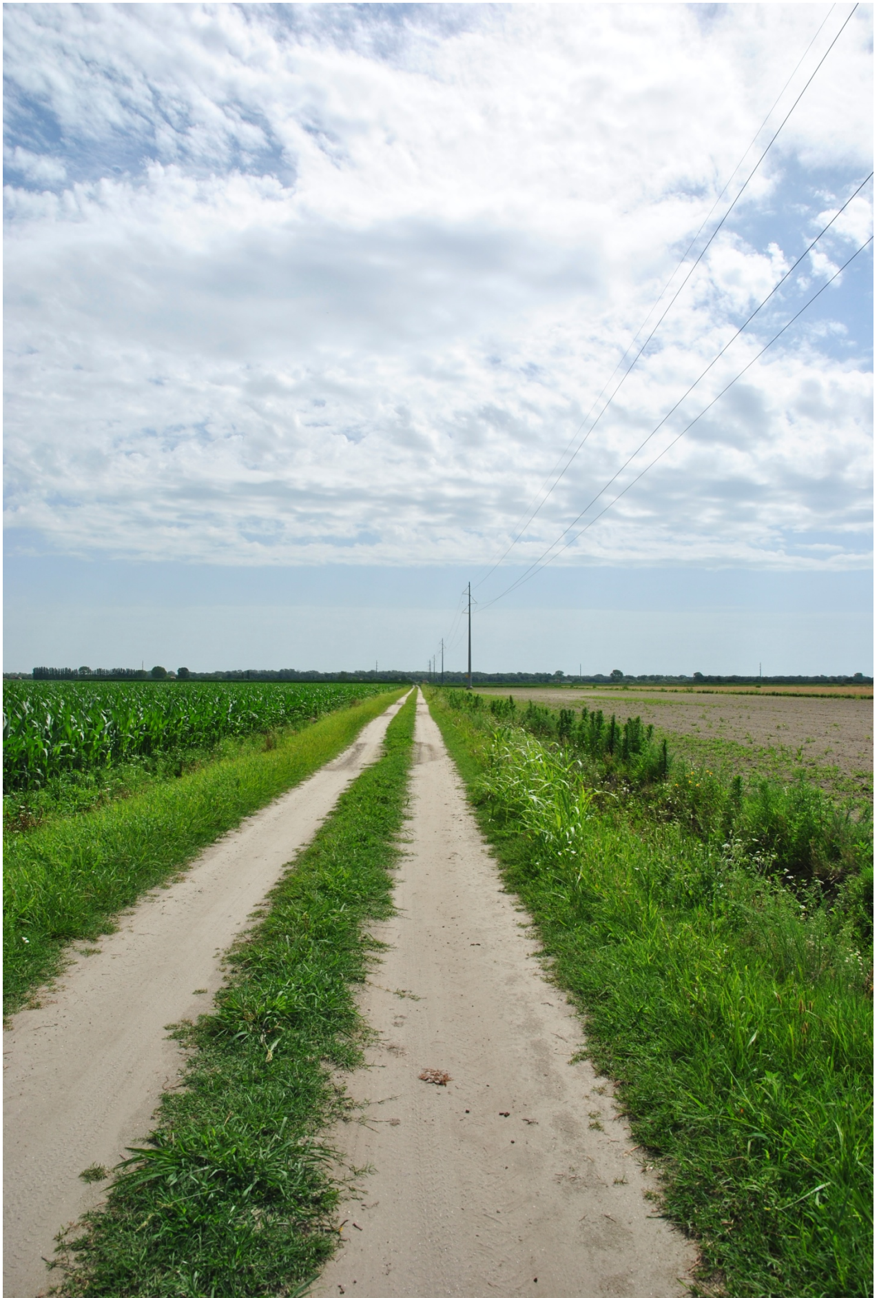
4 - vista della linea esistente su viabilità interpodereale in direzione Est
