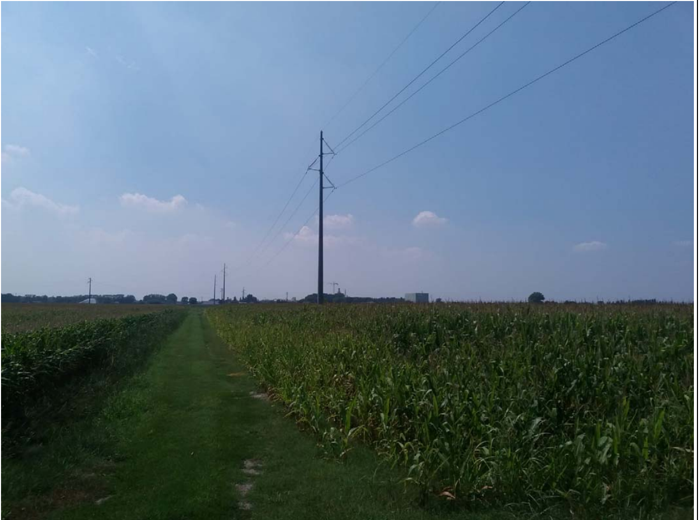
2 - vista dalla Strada delle Starne, in corrispondenza della linea esistente in direzione Ovest
