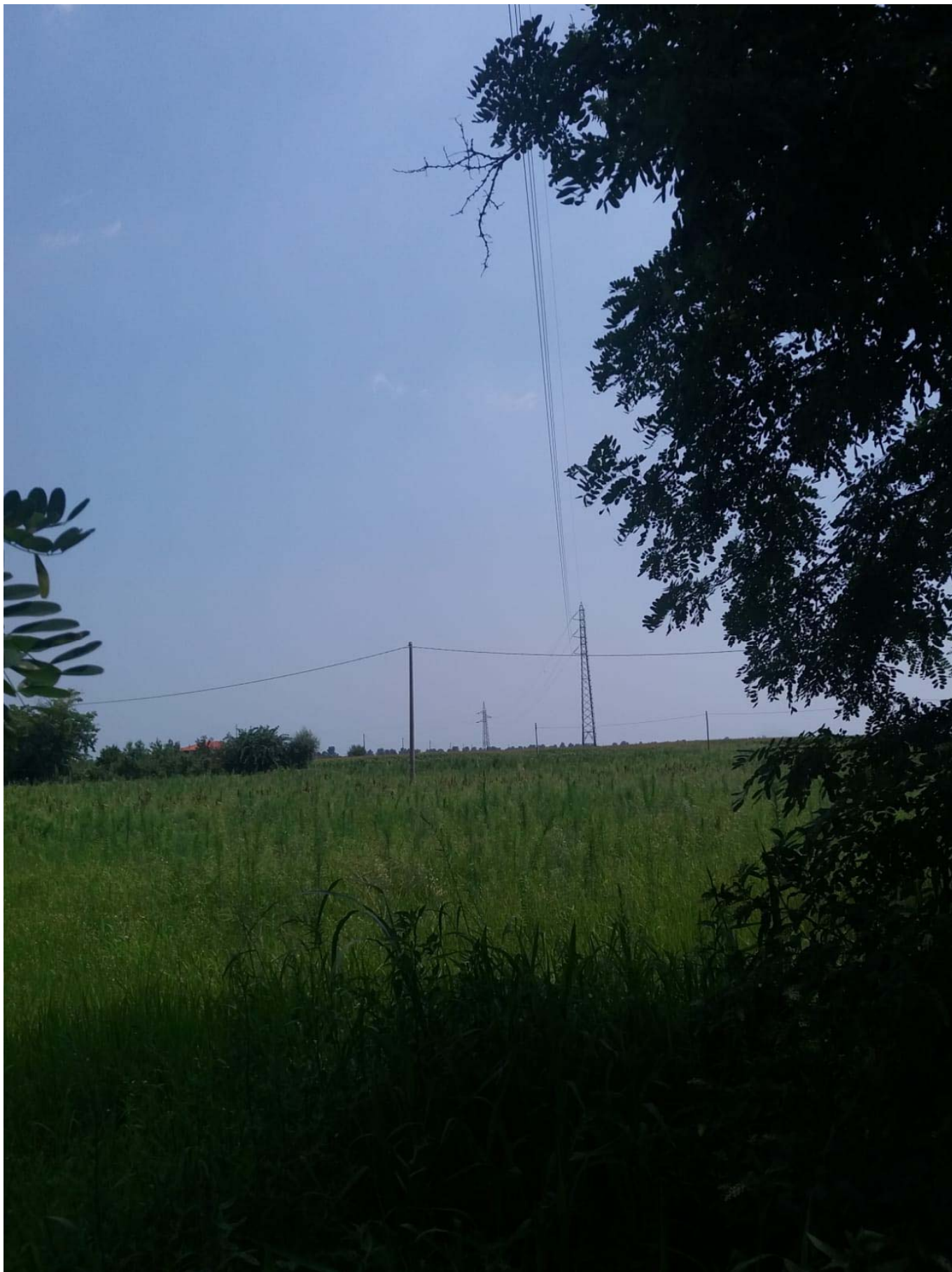
3 - vista su strada Lovara, in corrispondenza della linea esistente in direzione Est in un punto libero dalla vegetazione ai lati della strada
