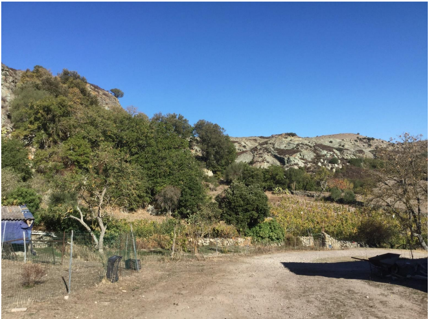
Foto 18 – Vista panoramica dell'imbocco sud della galleria in esame.
