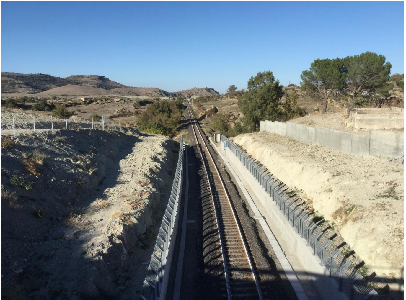
Foto 17 – Vista panoramica del tratto iniziale del tratto in esame.
