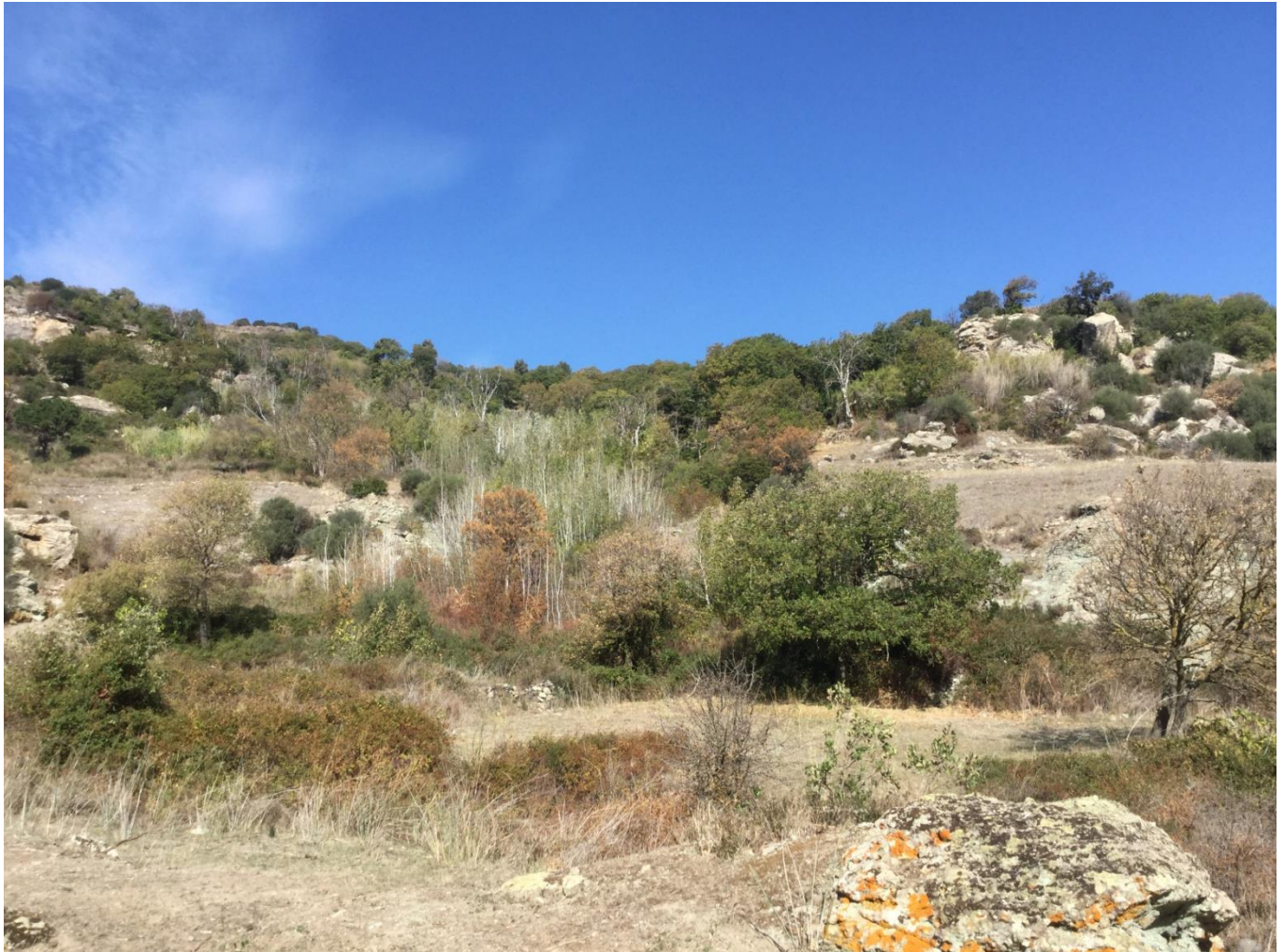
Foto 11 - Scarbate morfologiche interessate da fenomeni di crollo in roccia nei settori centrali della zona di studio, lungo il margine meridionale del rilievo collinare su cui sorge il centro abitato di Giave.
