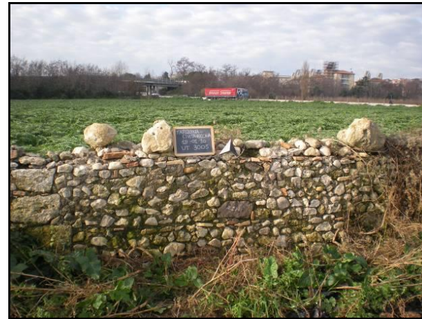
Sito 3005, particolare della struttura muraria, da S
