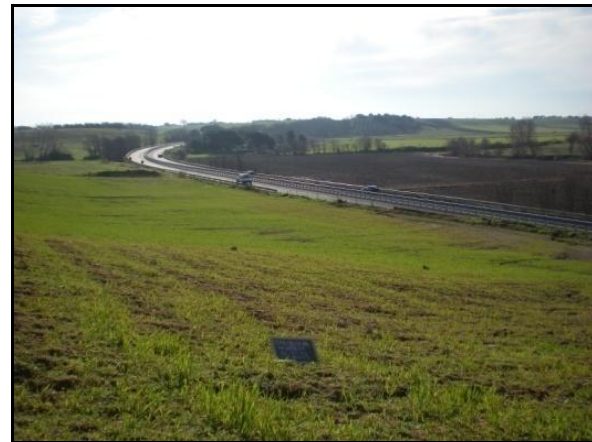
Panoramica del sito 4003, da SE. Sullo sfondo la SS1 Aurelia
