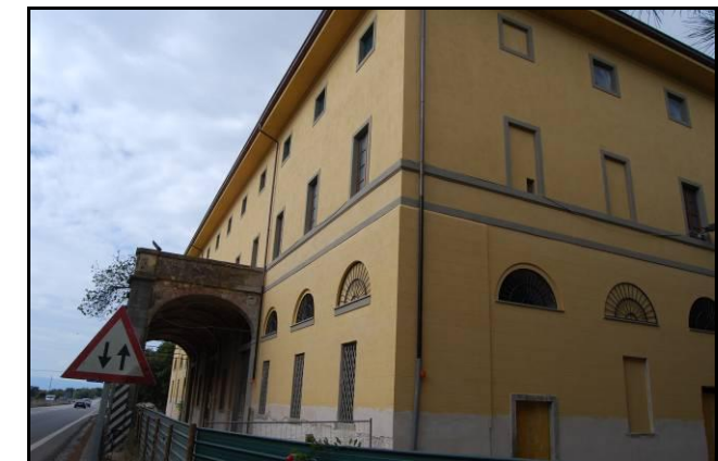
UR 267, Palazzo del Chiarone in fase di restauro, da S
