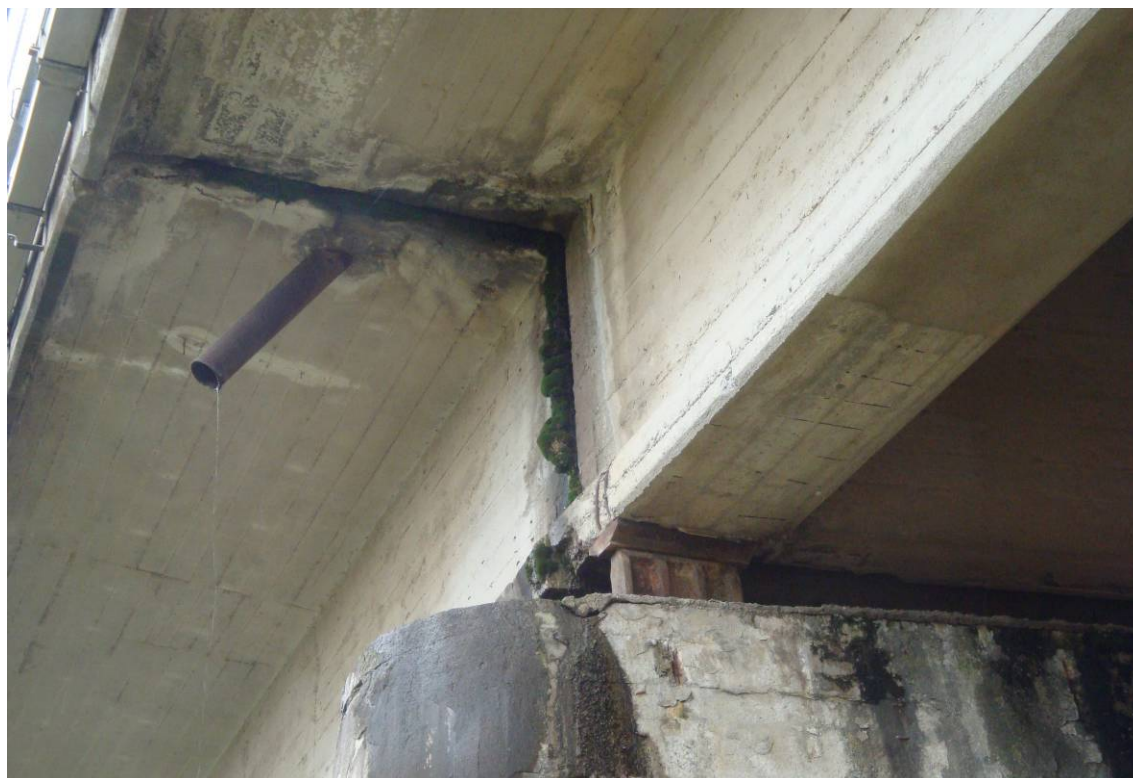
Apparecchio d'appoggio metallico sulla pila
