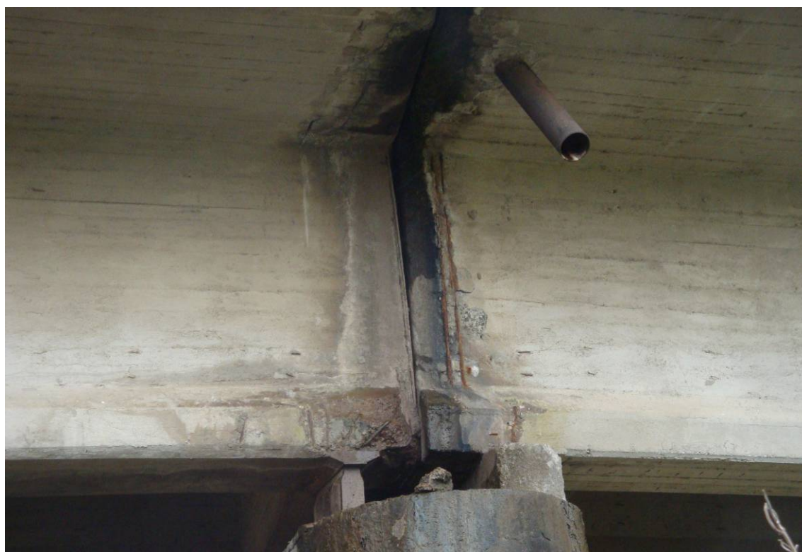
Vista laterale – particolare appoggi sulla pila
