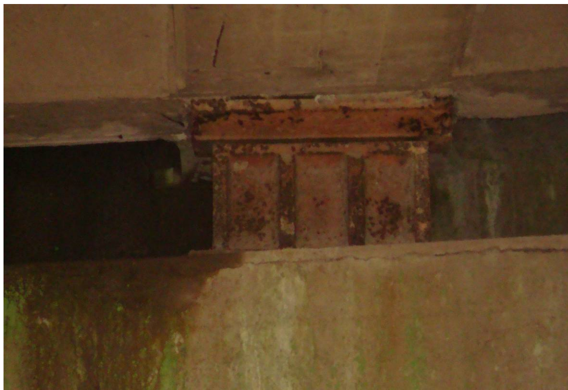
Apparecchio d'appoggio metallico sulla spalla
