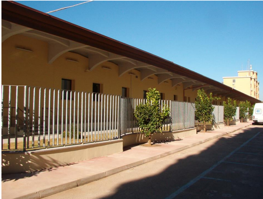
Figura 7 - Edificio del Posto Centrale CTC Rete Sarda (Cagliari)
