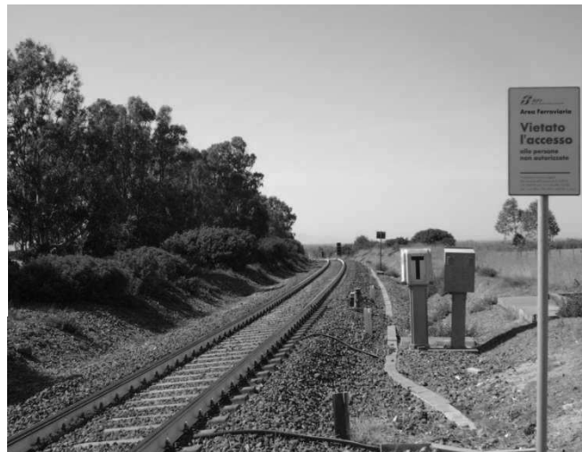
Vista lato Solarussa Km 107+885 – Curva R=1000 m
