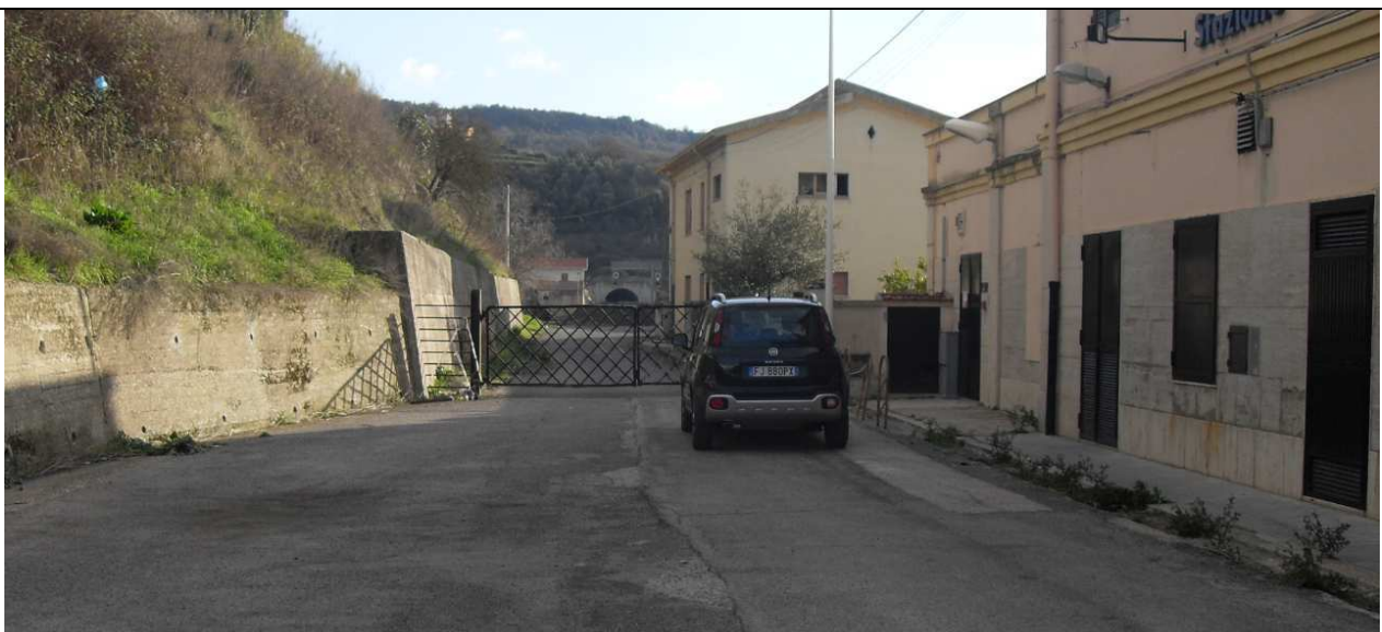
Cancello di accesso all'area di stoccaggio tolto d'opera AR.02 (da via G. Deledda)
