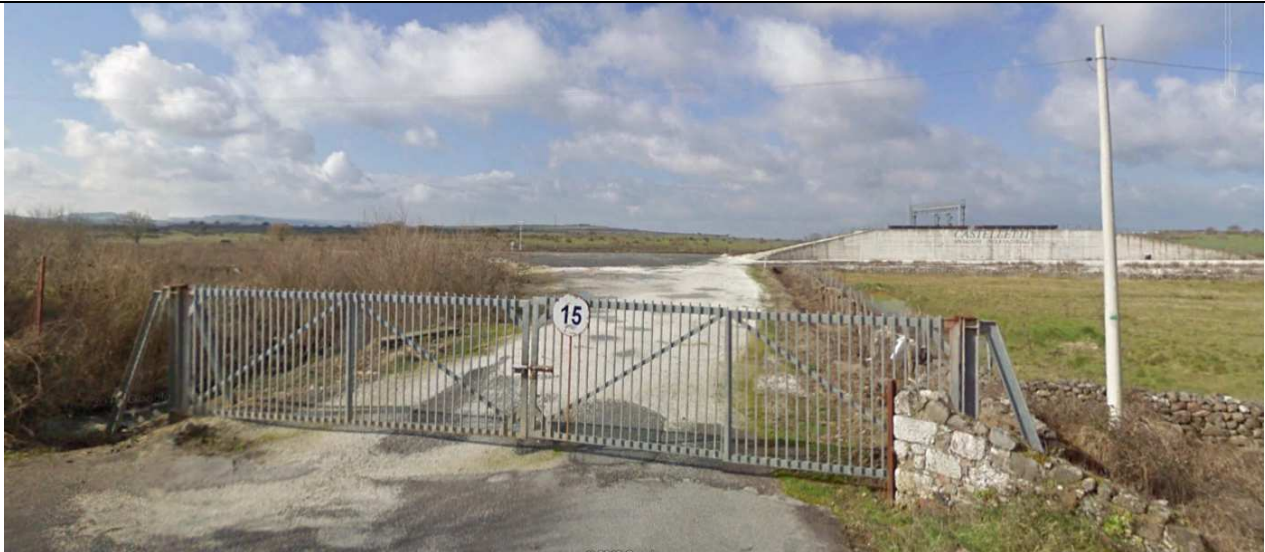
Cancello di accesso area di stoccaggio tolto d'opera AR.03
