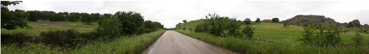
Foto 4 – La SP43 a lato dell'area di cantiere (sulla sinistra) durante il sopralluogo.
