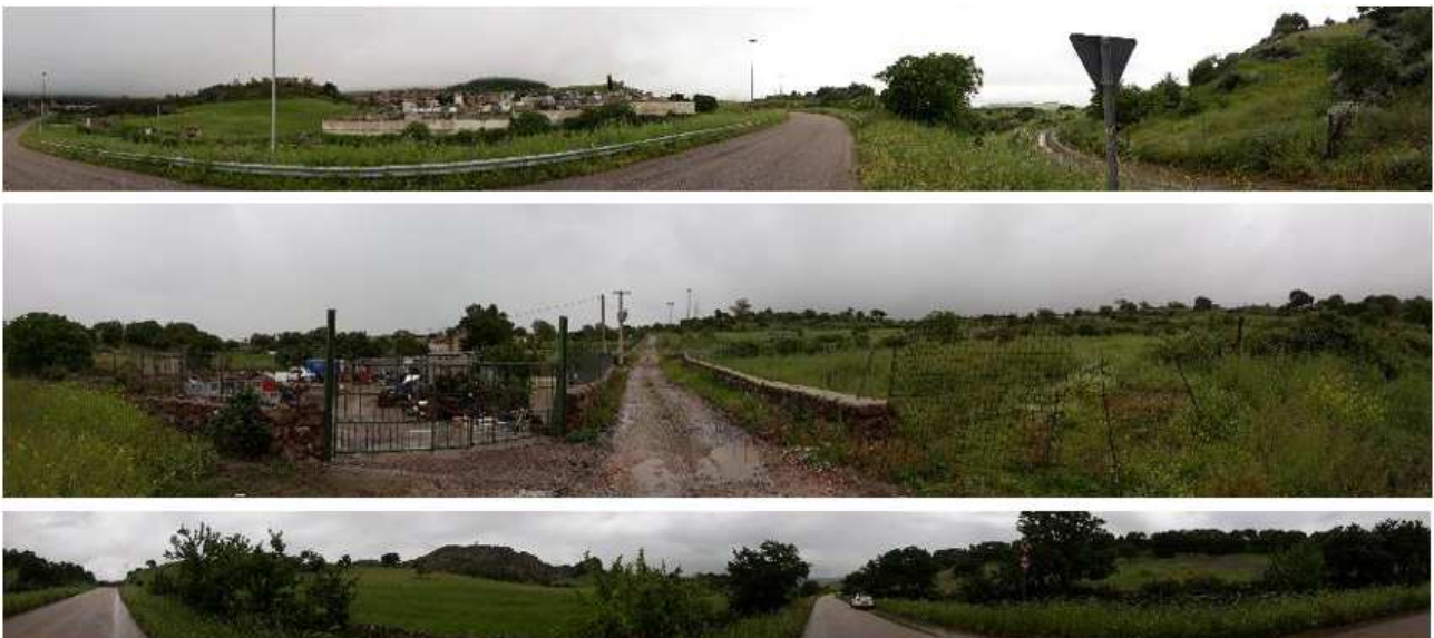
Figura 3-4 dettaglio delle vie d'accesso alle aree di cantiere. In alto: Pista Cantiere 1 (a destra nell'immagine): la pista decorre parallelamente alla via carrabile di Giave. Al centro: Pista Cantiere 2: la pista decorre al margine di una proprietà privata adibita a deposito: è fiancheggiata da muretti a secco per gran parte del percorso e parzialmente asfaltata/cementata. In basso: l'accesso all'area del Cantiere Base (al centro): l'area è raggiungibile tramite la viabilità ordinaria.
