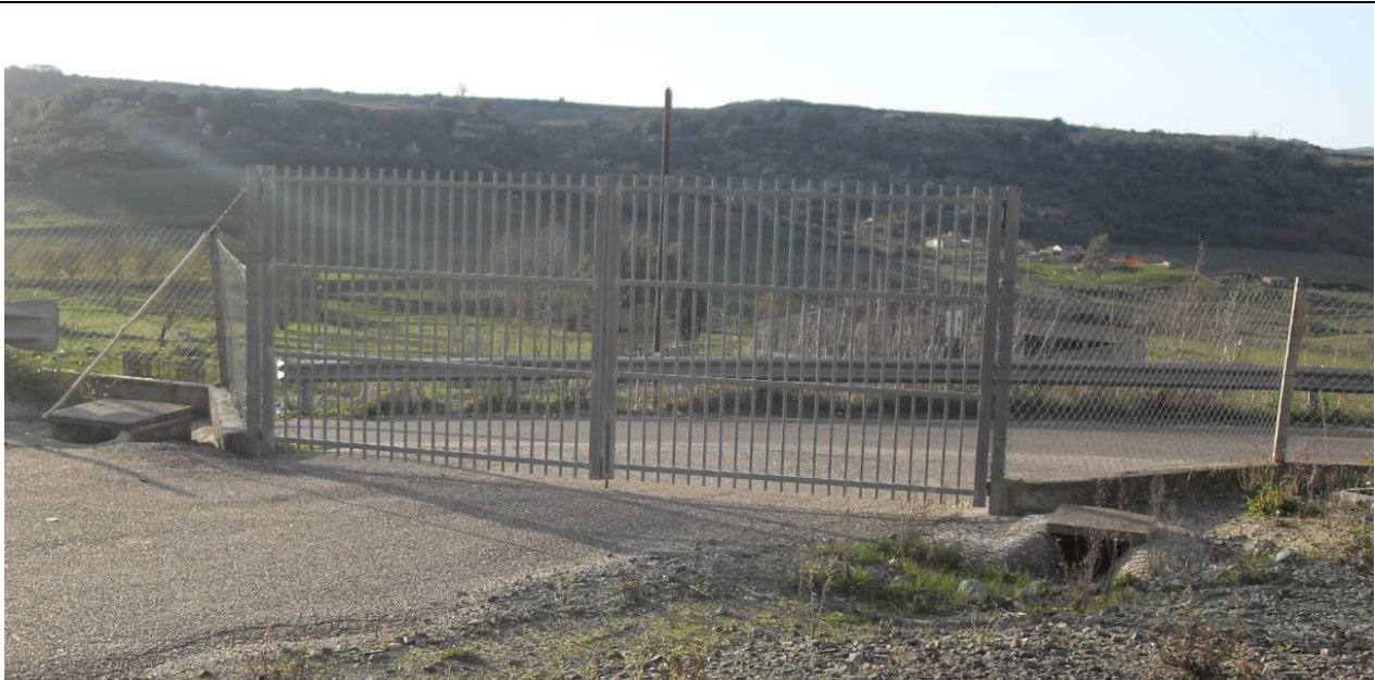
Cancello di accesso area di stoccaggio tolto d'opera AR.02 (da via E. Costa)
