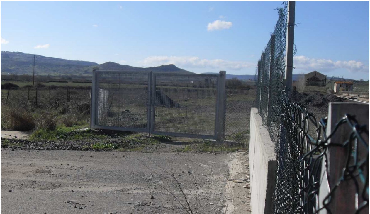
Cancello di accesso al cantiere
