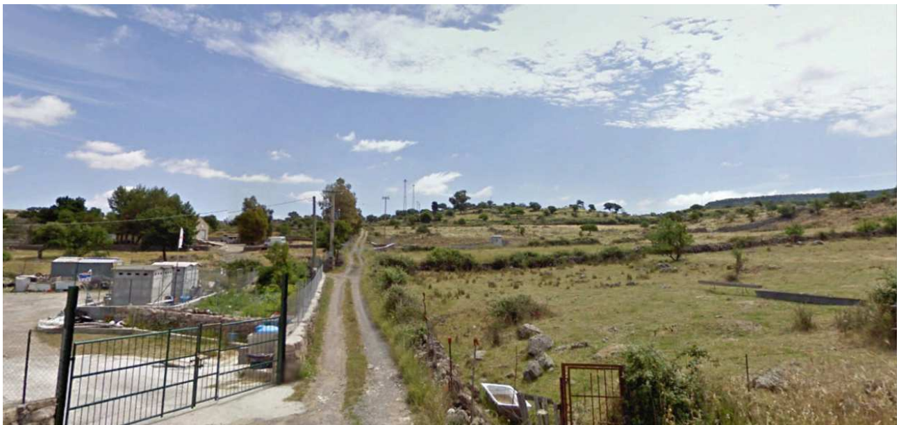
Figura 2-10 vista della viabilità di accesso alle wbs TR01(in sx)
