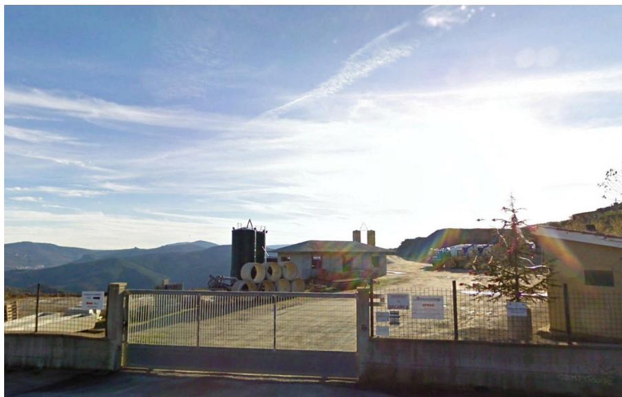
Figura 4-3 Impianto Edilcalcestruzzi di Tonara
