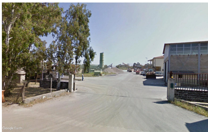
Figura 4-4 impianto UNICAL di Simaxis
