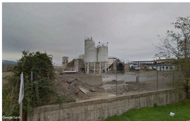
Figura 4-5 impianto UNICAL di Macomer
