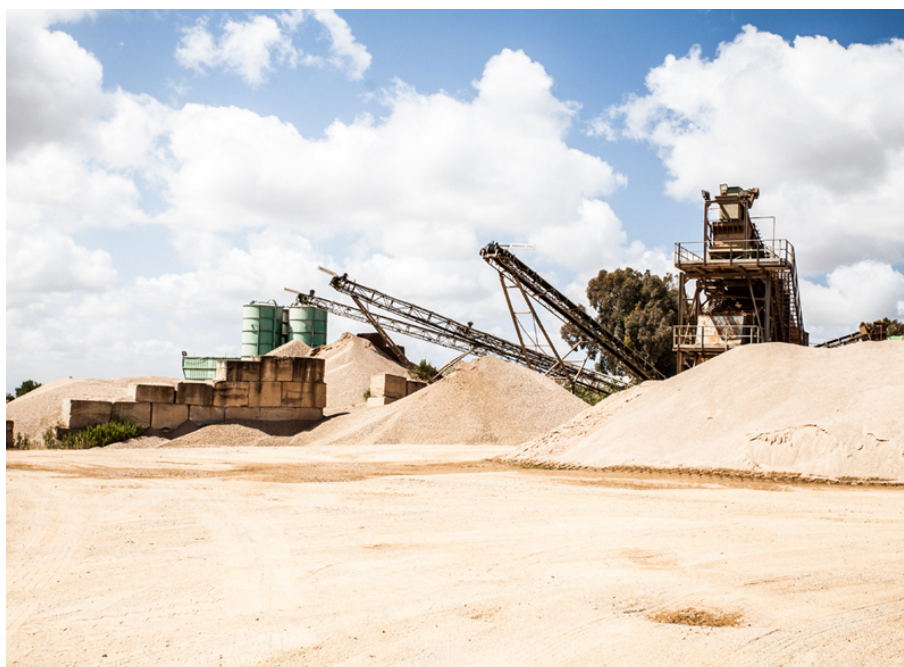
Figura 4-2 Impianto Guido Ruggiu a Solarussa
