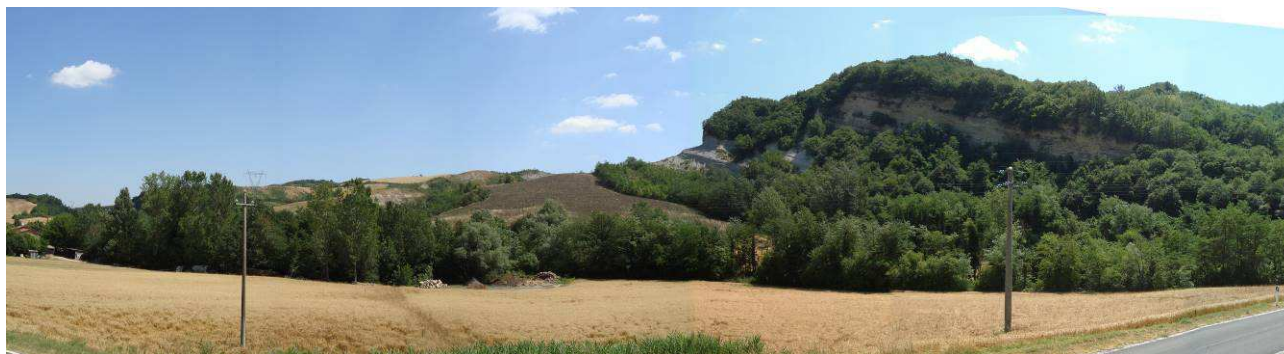
Figura 26: sulla sinistra i versanti interessati dalla campata 42-43
