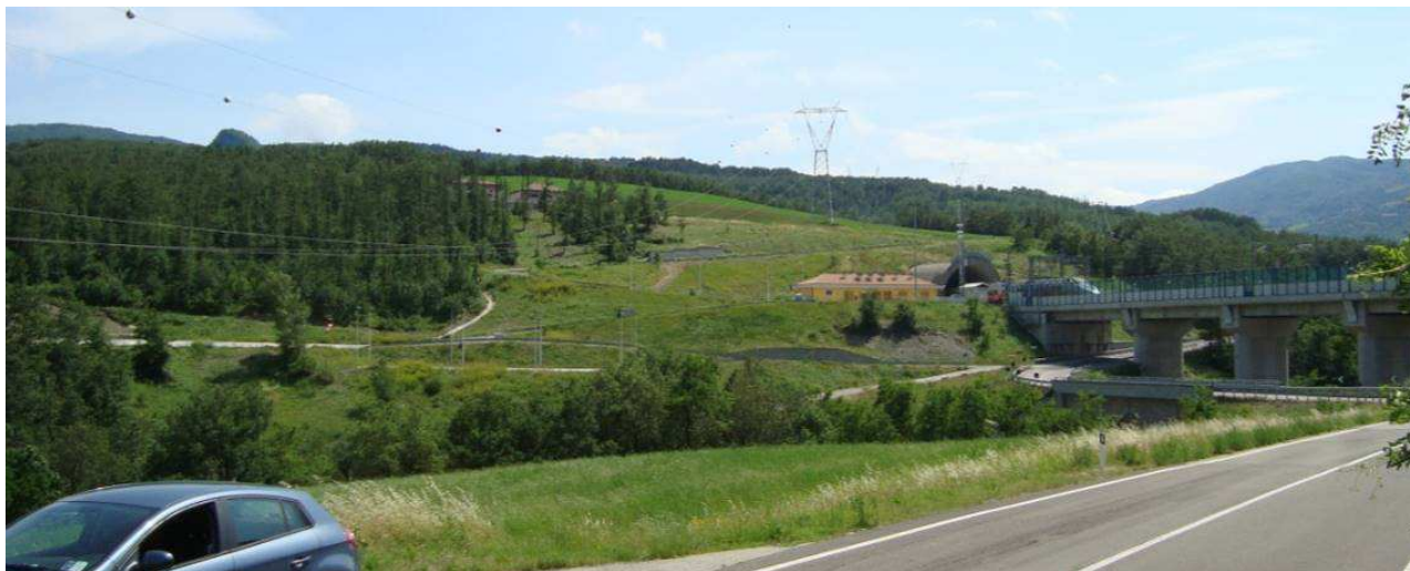
Figura 4-30: Tratto in corrispondenza dei sostegni 87 - 88. In primo piano la linea da smantellare
