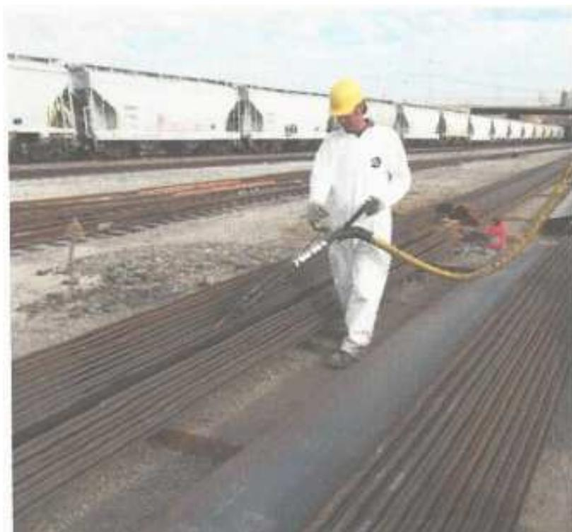
*Posa in opera sistema di sigillatura delle palancole*
