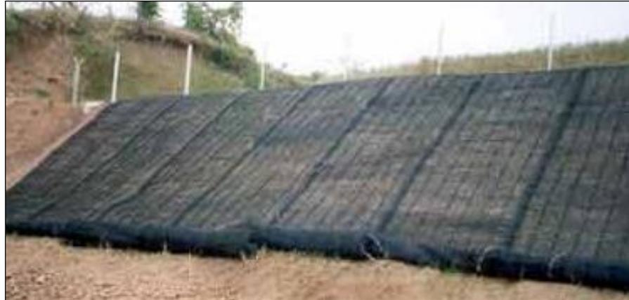
**Figura 39: Bobine di geostuia poste in opera su un versante stradale.**
