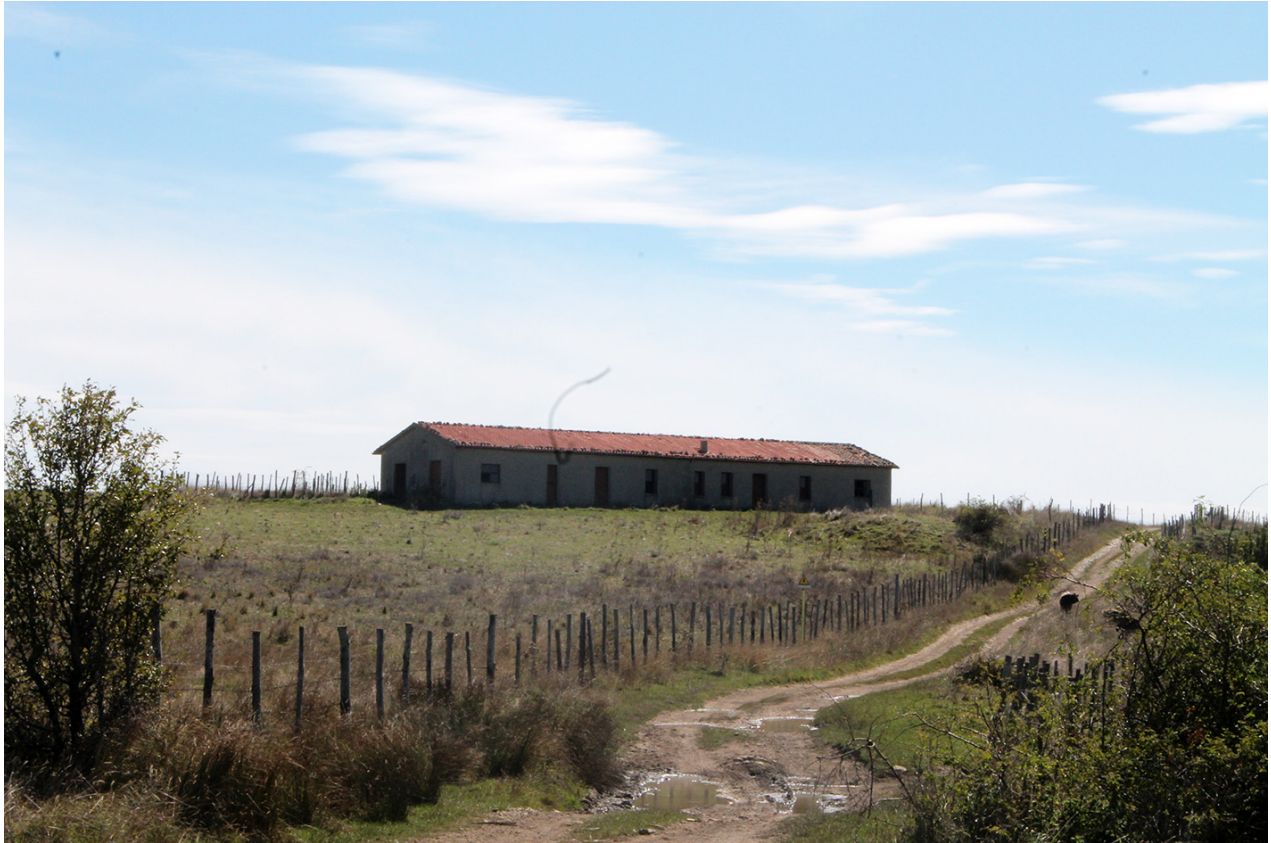
Figura 10 – Viabilità sterrata e presenza di recinzioni per le attività di pascolo e allevamento nei pressi del Casone Martuscelli
