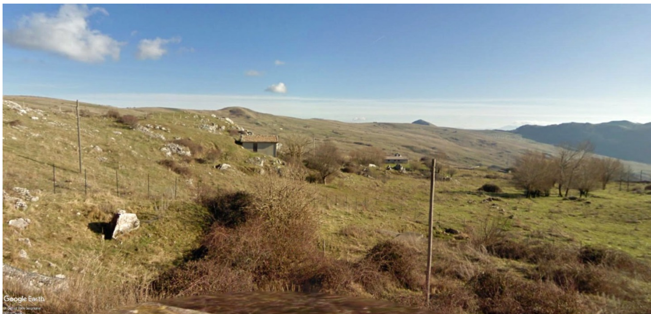
Figura 9 – Fabbricati abbandonati nei pressi del Tratturo di Lago Dragone, alle pendici occidentali dell'altipiano su cui si dispongono gli aerogeneratori della centrale eolica in progetto
