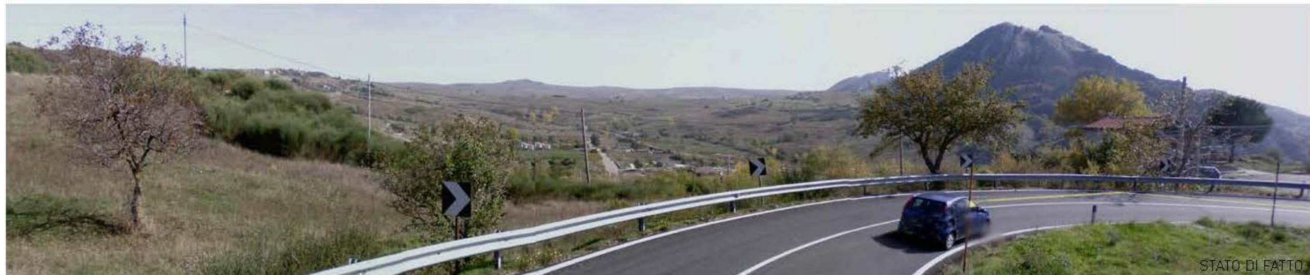
Figura 4: confronto tra progetto (in alto) e stato di fatto (in basso). Vista dal centro abitato di Castelgrande a circa 4,2 Km di distanza dagli aerogeneratori in progetto, che si intravedono solo in minima parte sullo sfondo senza determinare significative interazioni percettive di segno negativo rispetto alla comprensione della geografia e dei caratteristici profili morfologici dei rilievi circostanti.
