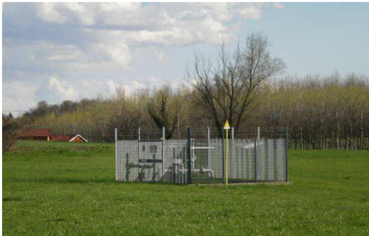
**Figura 10 - Esempio di Punto di Intercettazione di Derivazione Importante PIDI.**
