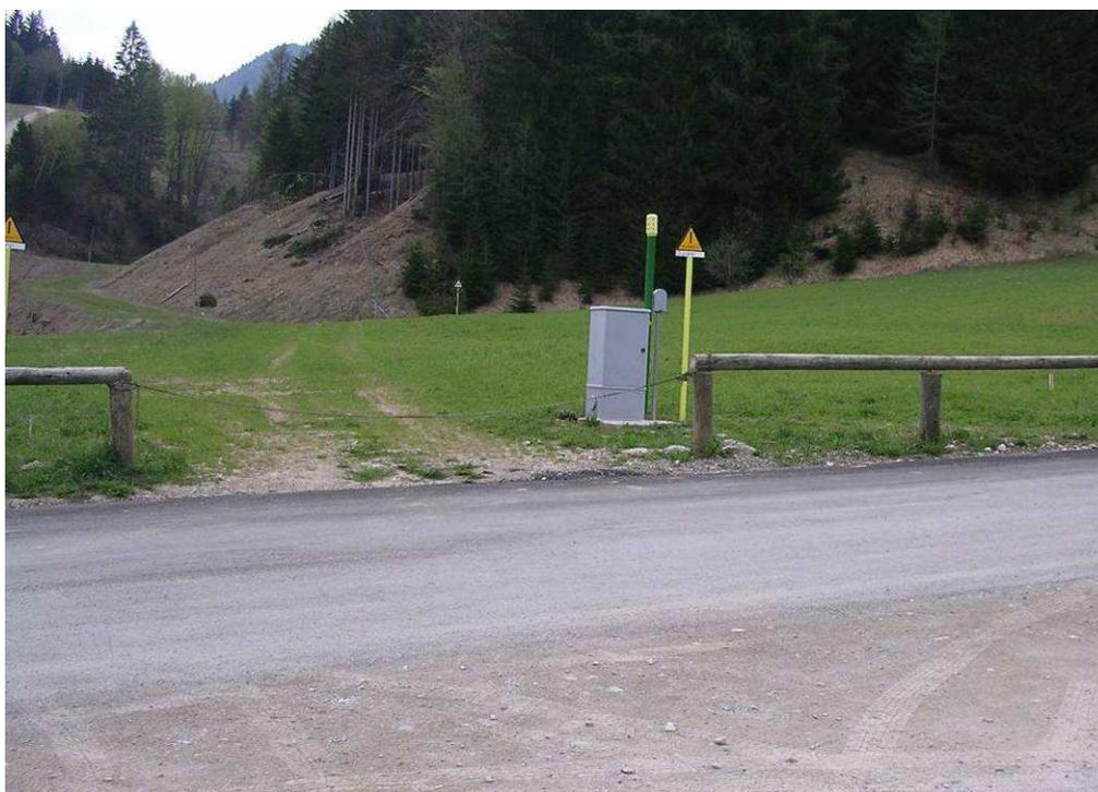
**Figura 11 - I cartelli segnalatori del metanodotto ed i tubi di sfiato posti in corrispondenza degli attraversamenti eseguiti con tubo di protezione.**
