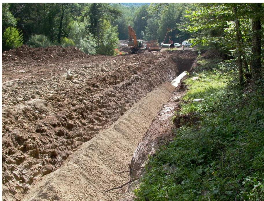
**Figura 8 - Operazione di rinterro della condotta.**
