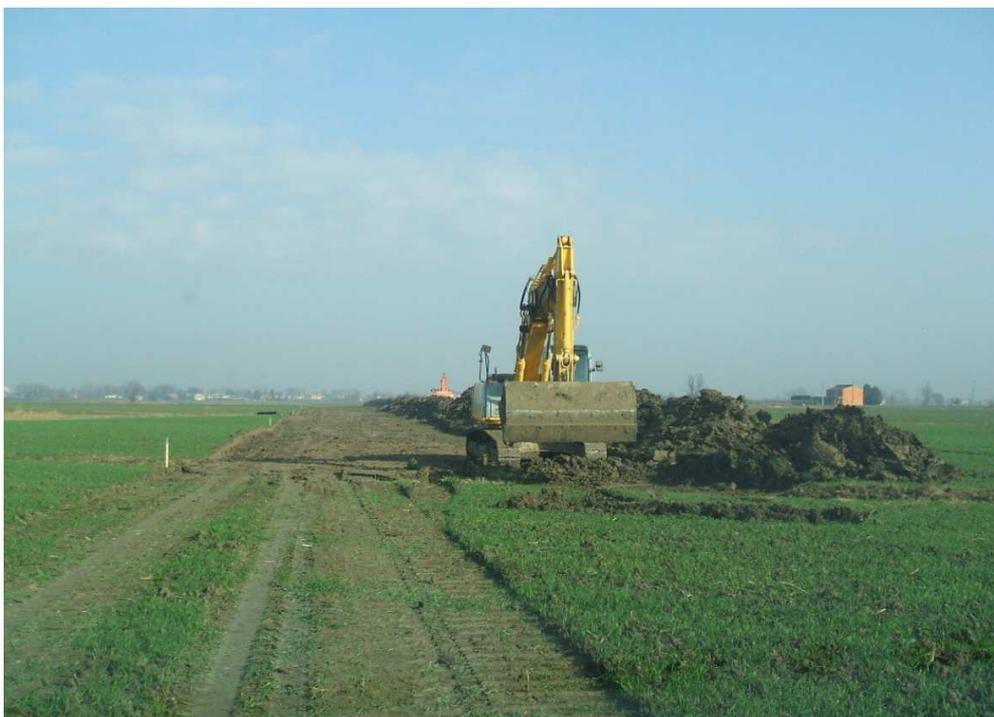
**Figura 6 – Esempio di apertura pista di lavoro su aree agricole.**
